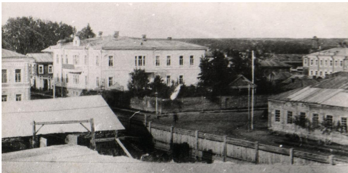
Рис. 3. Усадьба купца С.Ф. Хромова и его наследников по состоянию на нач. XX в. Репродукция из исторической записки проекта «Памятник истории б. усадьба купца Хромова по ул.Крылова, 26 в г.Томске», 2001 г.СИ «Сибспецпроектреставрация».
