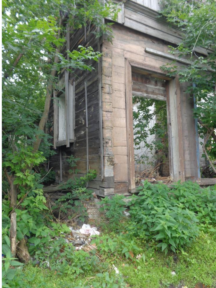
Рис. 16. Фрагмент главного усадебного дома купца С.Ф.Хромова и его наследников по ул.Крылова, 26. Вид со двора. Фрагмент сруба из бруса. По состоянию на 2017 г.
