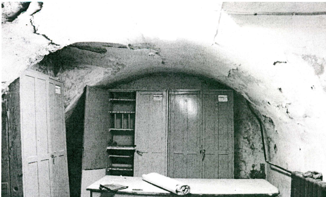
Видовая точка № 7. Коробовый свод с распалубками (подвал).
