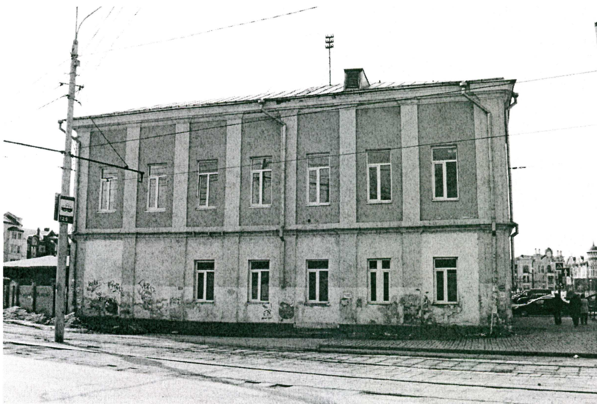
Видовая точка № 3. Северный фасад здания.
