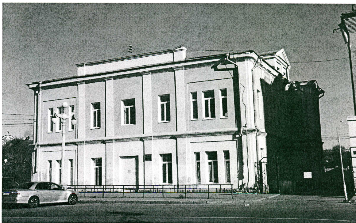
Видовая точка № 2. Главный (западный) фасад здания. Вид с ул. Набережной реки Ушайки.
