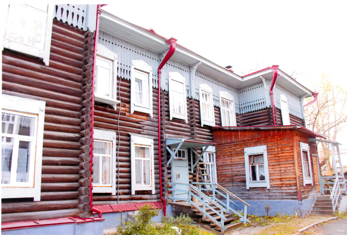
Видовая точка № 4. Северный (дворовый) фасад здания.
