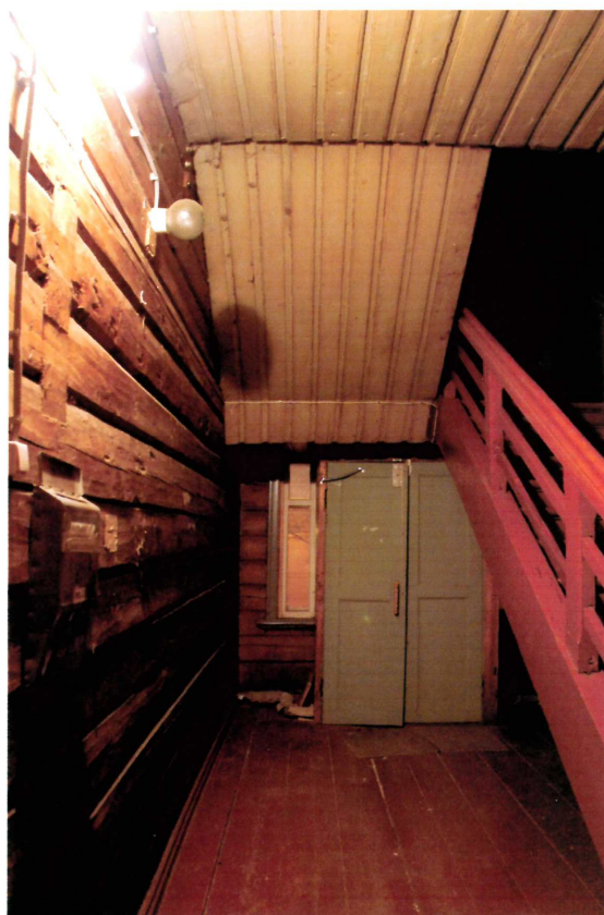
Видовая точка № 11. Вид на обшивку лестничных маршей и деревянное ограждение.
