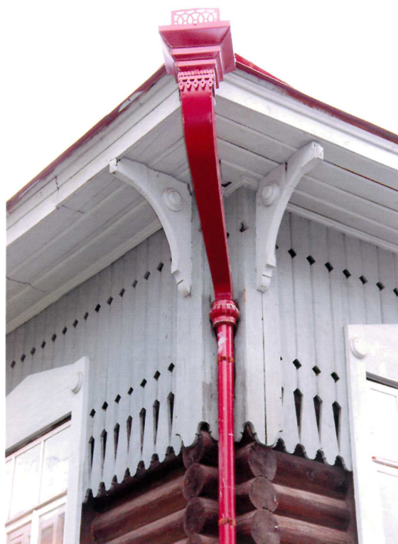
Видовая точка № 8. Фрагмент фасада. Угловая часть карниза. Водосточная труба (восстановлена).
