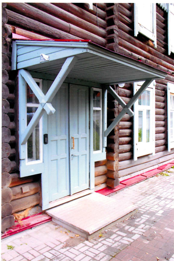
Видовая точка № 7. Центральный вход южного фасада. Козырек на кронштейнах (восстановлен).
