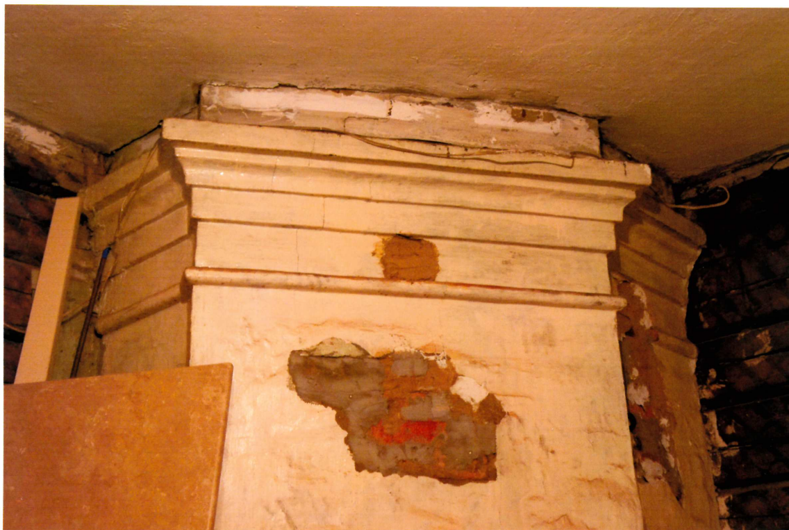
Видовая точка № 15. Фрагмент печи. Профильный карниз.
