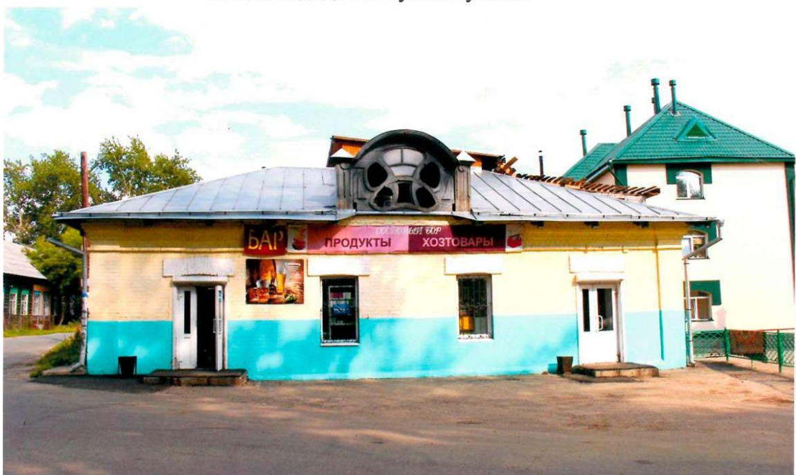
Видовая точка № 2. Главный (западный) фасад здания.
