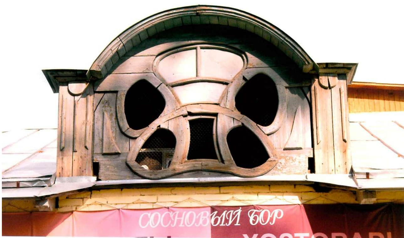
Видовая точка № 4. Слуховое окно главного фасада.
