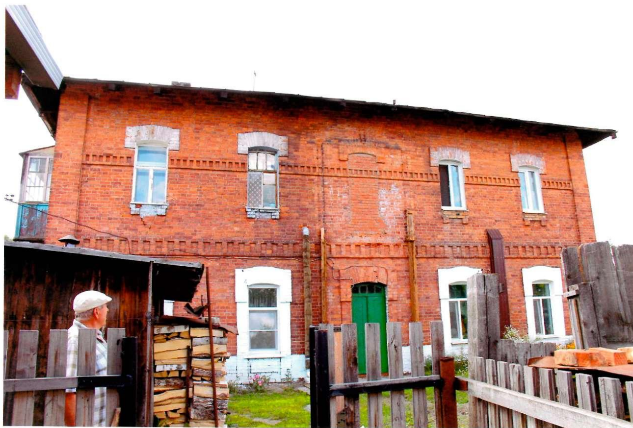
Видовая точка № 4. Восточный (дворовый) фасад здания.
