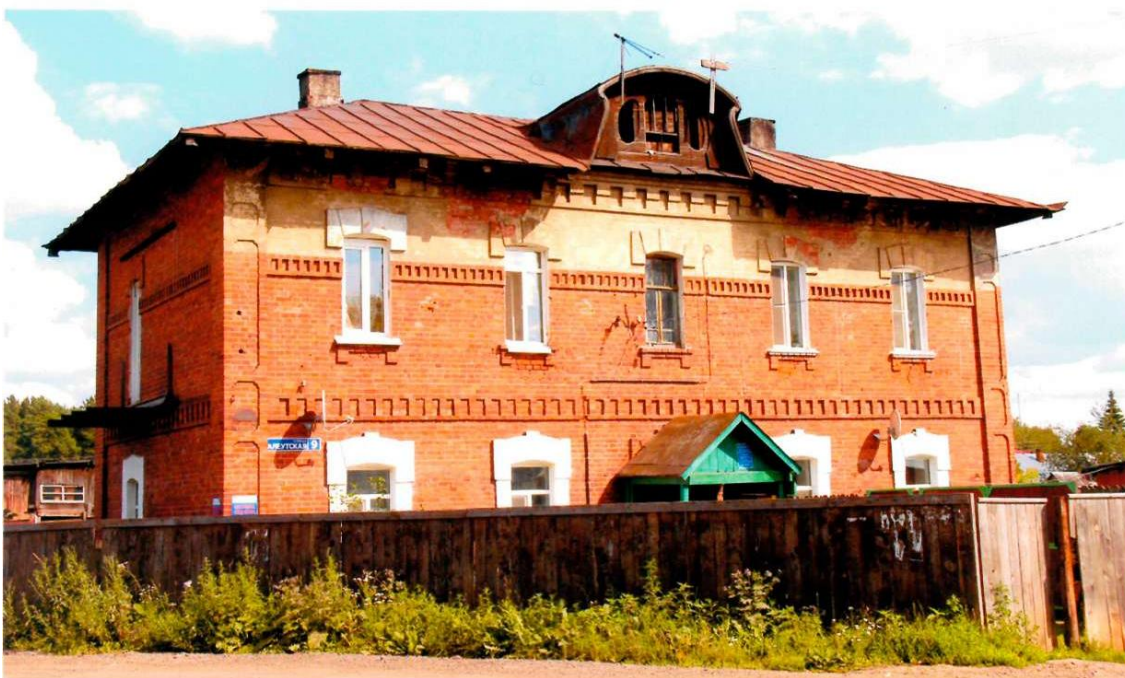
Видовая точка № 2. Главный (западный) фасад здания.
