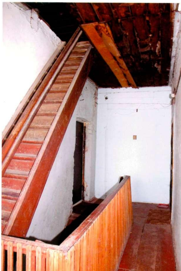
Видовая точка № 9. Деревянная лестница на чердак.
