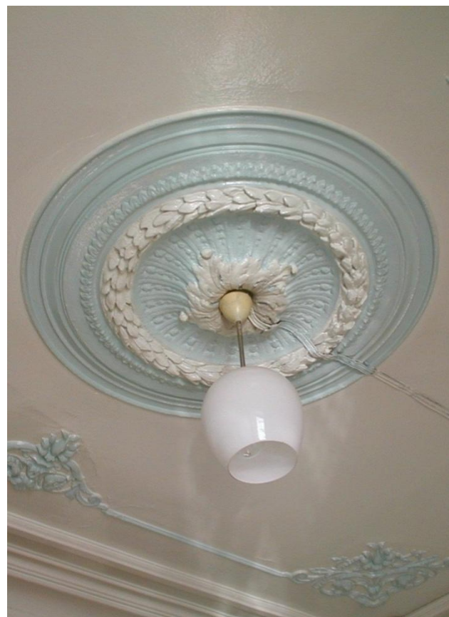
Видовые точки № 22. Фрагмент лепного декора. Розетка. (18.03.2002 г.)
