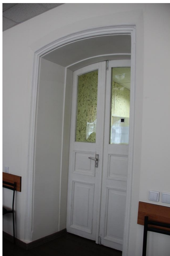
Видовые точки № 28. Деревянная филенчатая остекленная дверь.
