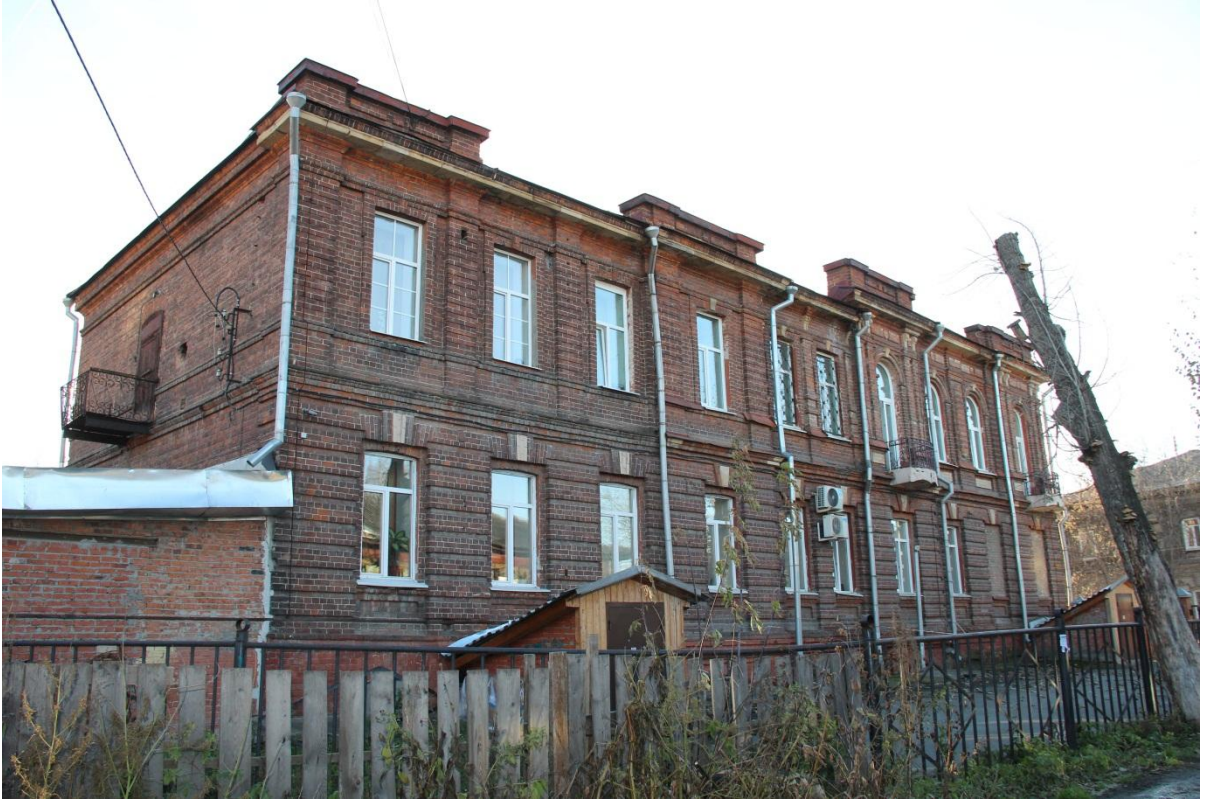
Видовая точка № 9. Северный фасад здания.
