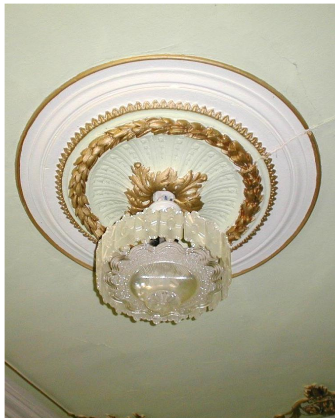
Видовые точки № 24. Фрагмент лепного декора. Розетка. (18.03.2002 г.)
