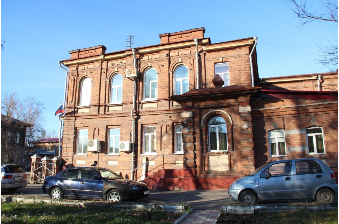
Видовая точка № 6. Южный фасад здания.
