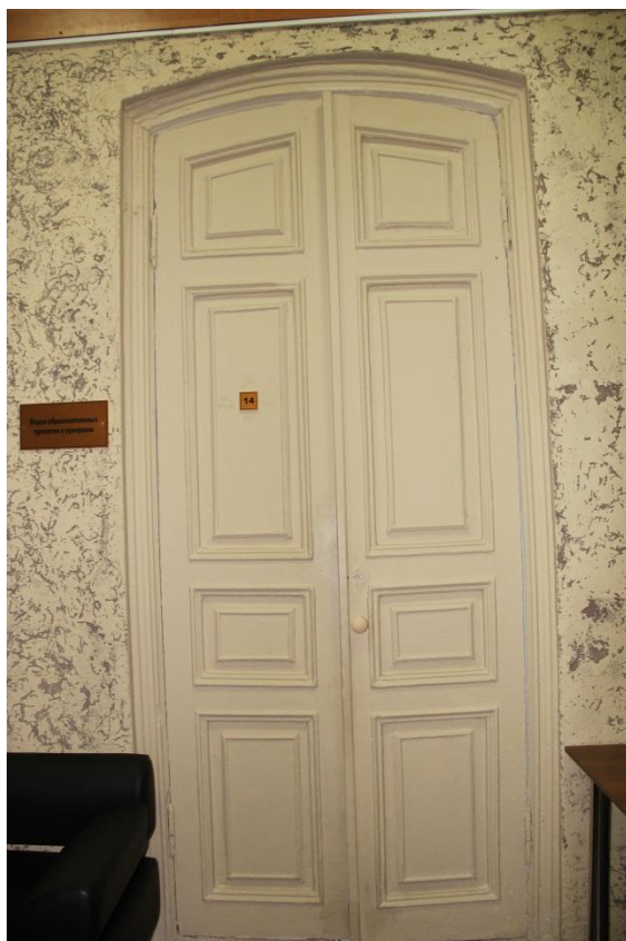
Видовая точка № 27. Деревянная филенчатая дверь.
