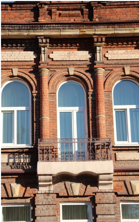
Видовая точка № 4. Балкон главного (западного) фасада.
