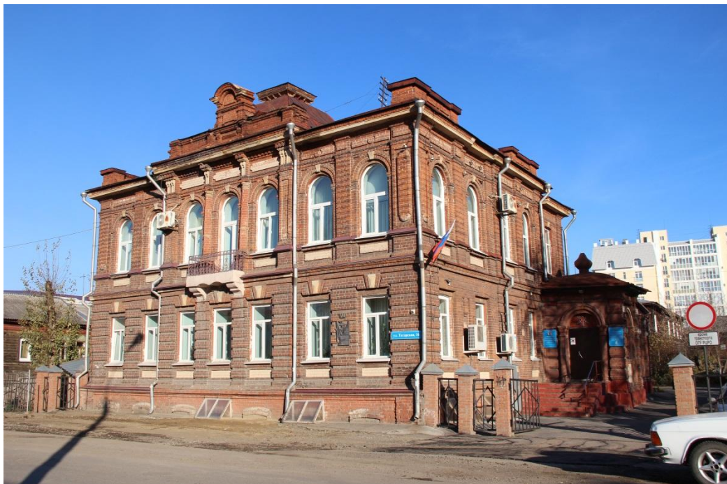
Видовая точка № 2. Общий вид здания с юго-западной стороны
