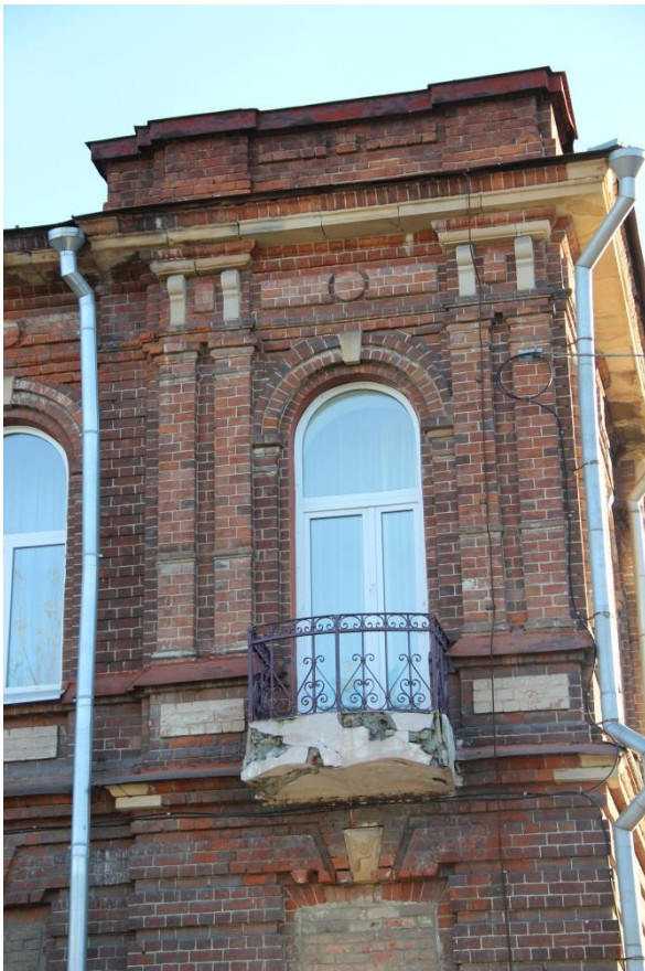
Видовая точка № 10. Балкон северного фасада.
