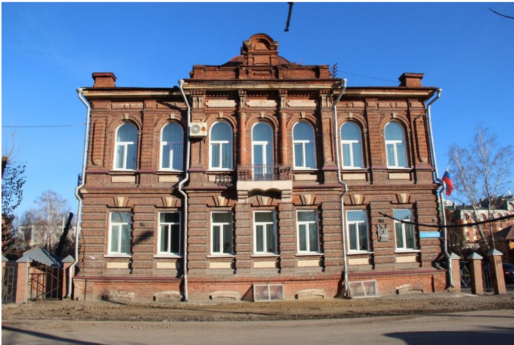
Видовая точка № 1. Главный фасад здания по ул. Татарской
