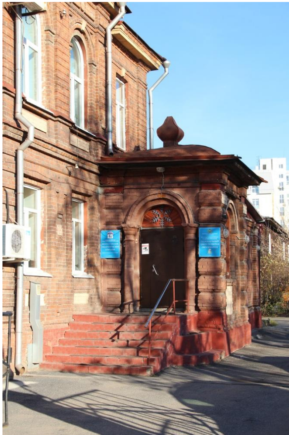
Видовая точка № 7. Главный вход в здание.
