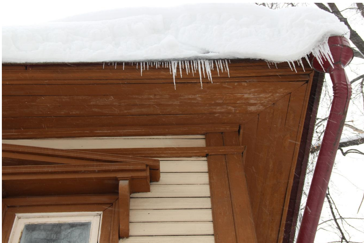
Видовая точка № 9. Карнизная часть дома.
