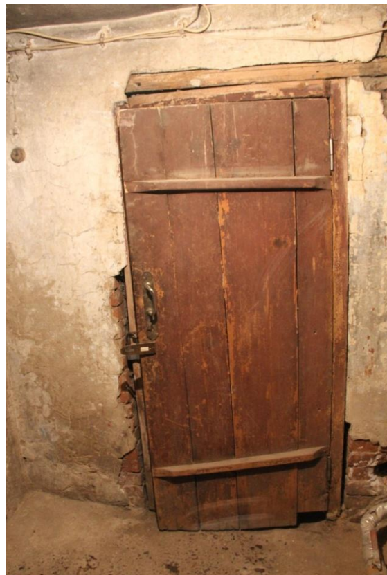
Видовая точка № 16. Внутренняя дверь подвала.
