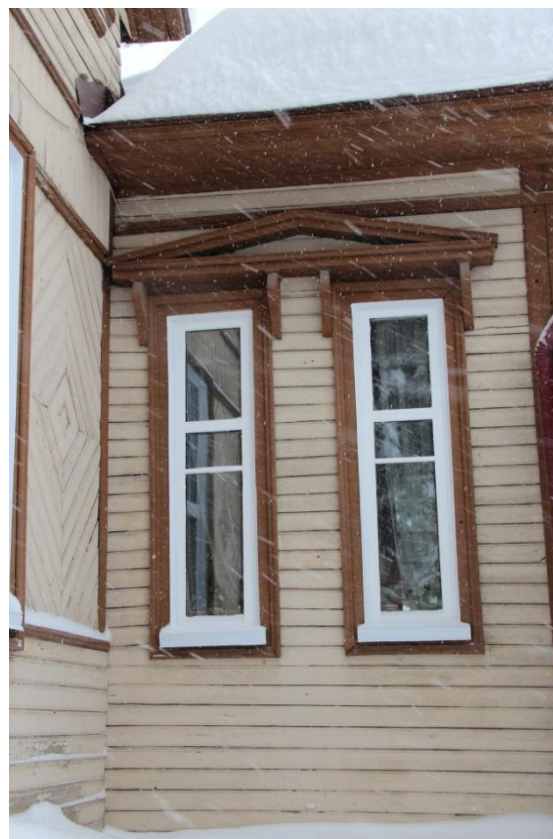
Видовая точка № 5. Наличник окон восточного фасада.
