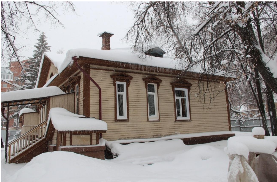
Видовая точка № 6. Западный фасад дома.
