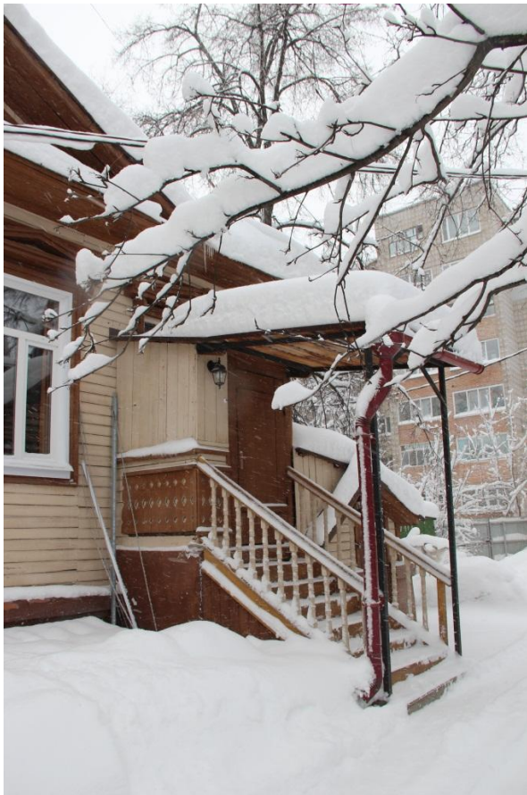
Видовая точка № 10. Крыльцо северного фасада.
