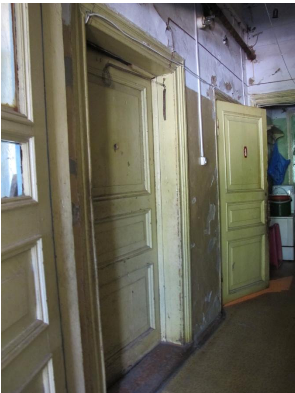
Видовая точка № 24. Деревянные филенчатые двери (фото: Леонтьевой Н.М., 21.08.2014)
