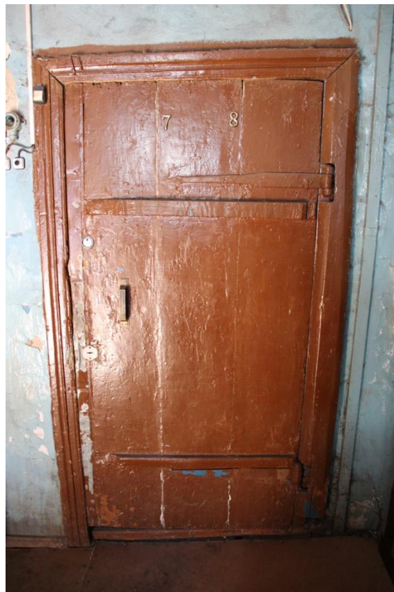
Видовая точка № 20. Дошчатая на шпонках дверь 1-го этажа (фото: Яблонской М.А., 02.04.2015)
