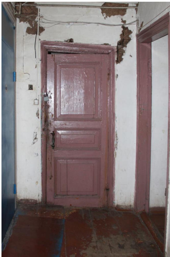
Видовая точка № 21. Деревянная филенчатая дверь в квартиру (фото: Ларовой Е.В., 26.10.2018)
