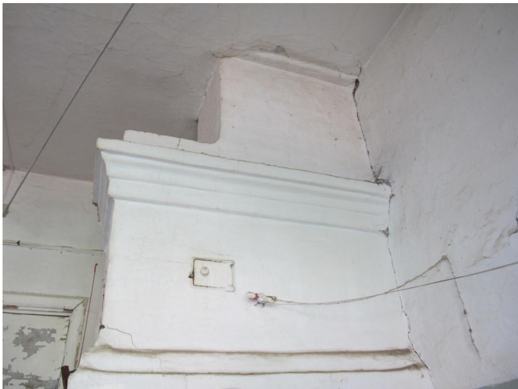
Видовая точка № 25. Кирпичная оштукатуренная печь (фото: Леонтьевой Н.М., 21.08.2014)
