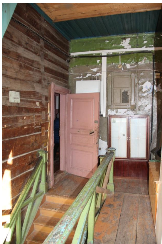
Видовая точка № 13. Деревянная лестница (вход со двора)
