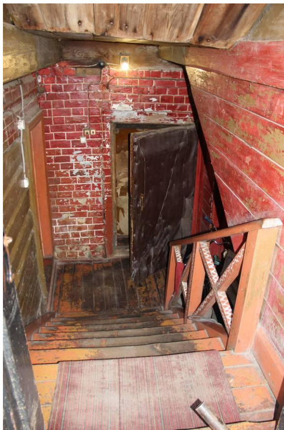
Видовая точка № 15. Вход в квартиру цокольного этажа
