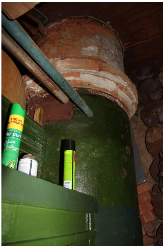
Видовая точка № 17. Круглая печь в металлическом футляре, (в пристройке). Верхняя часть печи.
