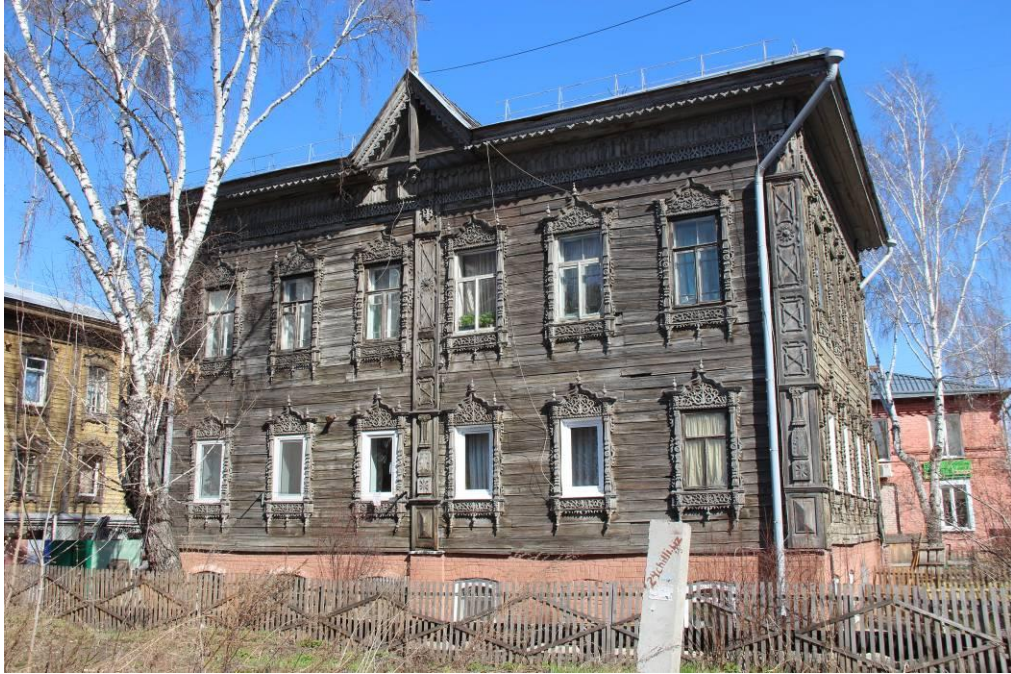
Видовая точка № 1. Южный фасад здания
