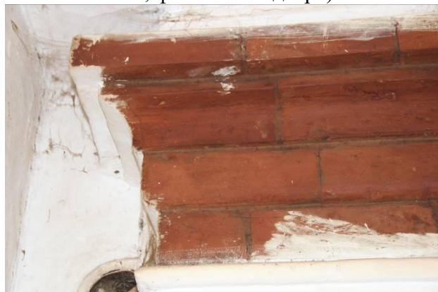
Видовая точка № 24. Фрагмент карниза печи
