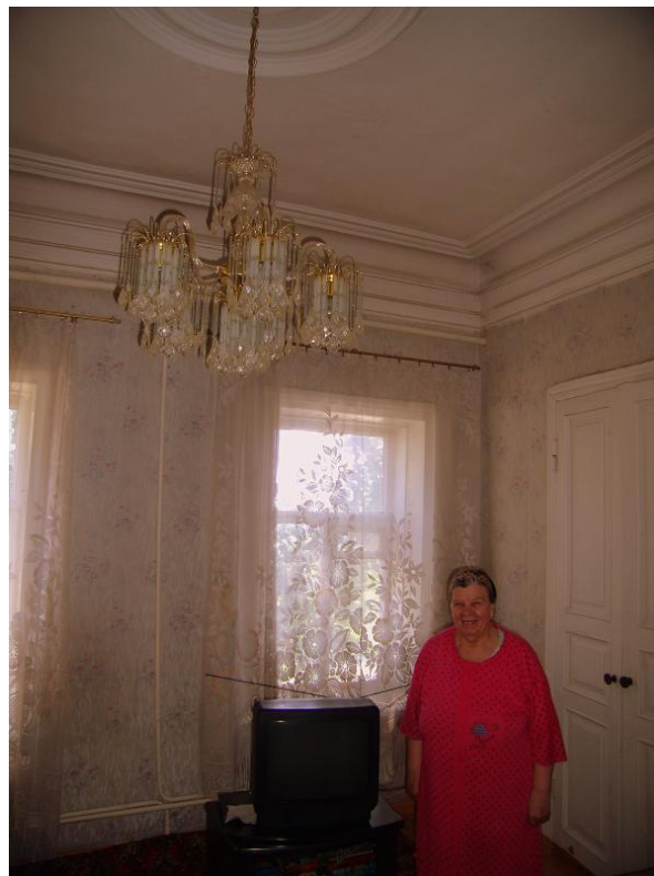
Видовая точка № 22. Фрагмент интерьера квартиры (потолочная розетка, профильные потолочно-стеновые тяги, филенчатая дверь)
