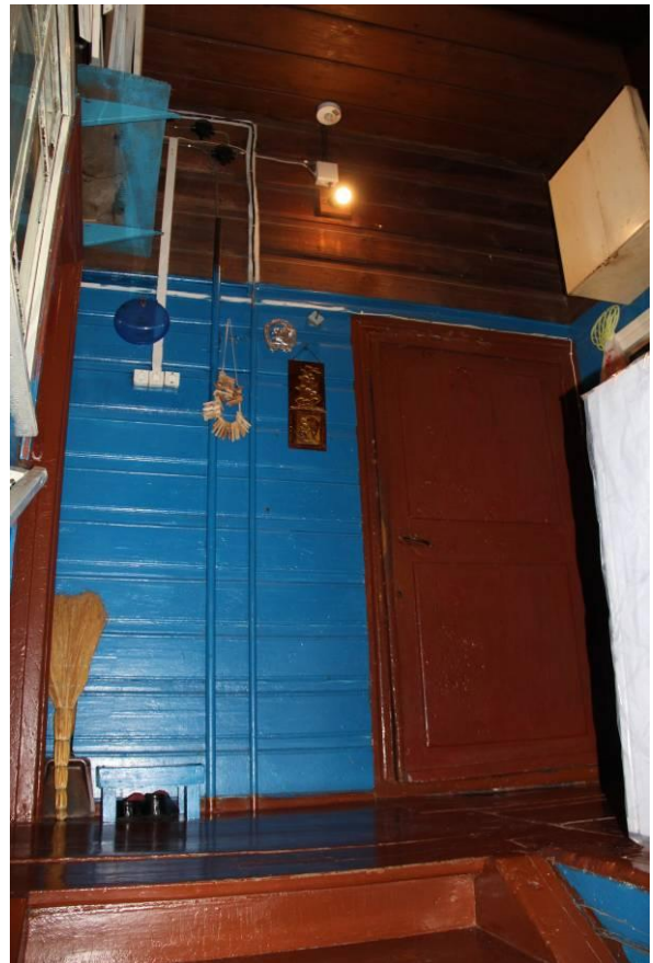
Видовая точка № 14. Вход в квартиру 1-го этажа, деревянная филенчатая дверь, обшивка стен из профильных досок
