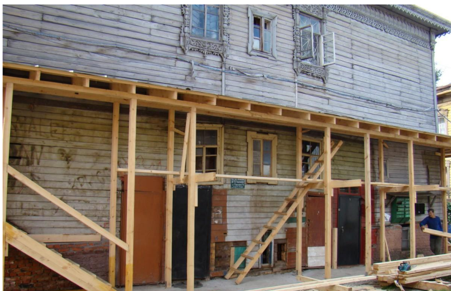
Видовая точка № 11. Фрагмент северного фасада пристройки
