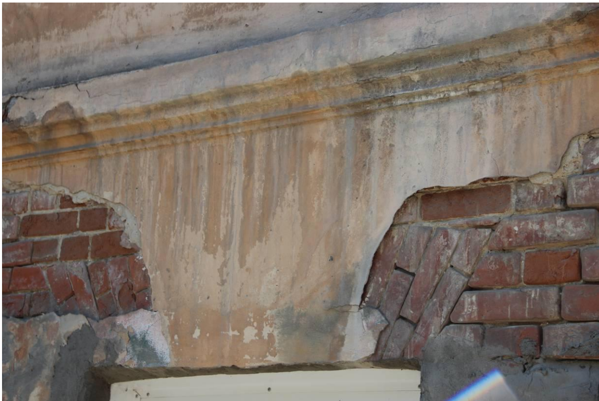
Видовая точка № 12 Фрагмент штукатурного декора главного фасада. Кирпичная перемычка оконного проема
