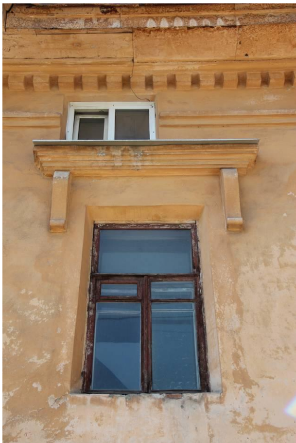
Видовая точка № 3 Окно 2-го этажа главного фасада
