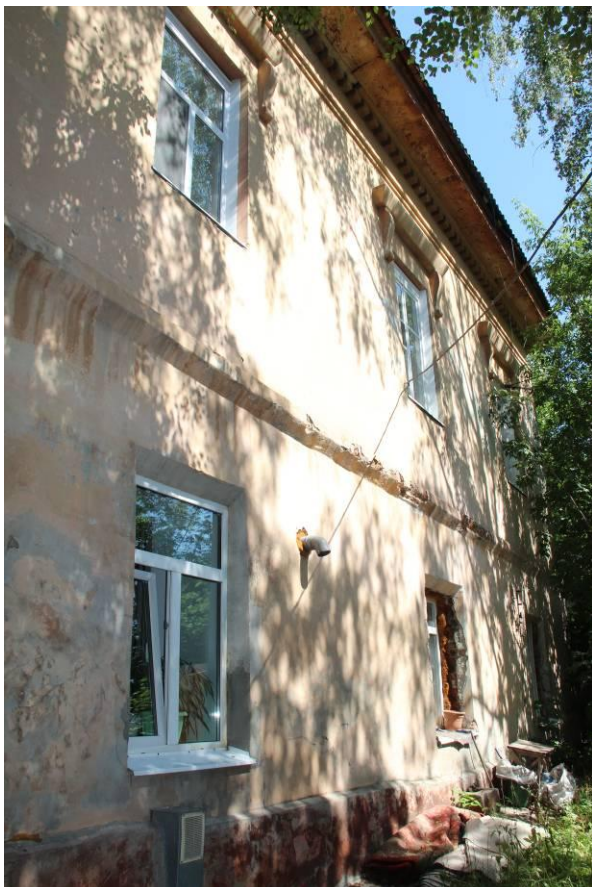
Видовая точка № 8 Южный фасад здания
