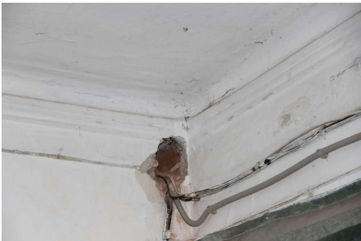
Видовая точка № 13 Фрагмент помещения 1-го этажа северной части здания. Профильные потолочно-стеновые штукатурные тяги
