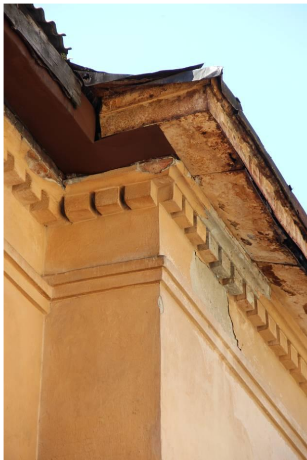
Видовая точка № 4 Фрагмент карниза ризалита северного фасада
