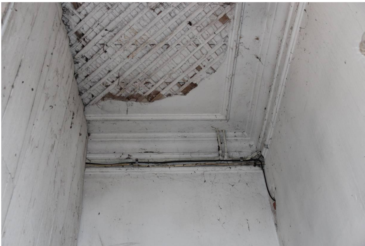
Видовая точка № 13 Профильные потолочно-стенные тяги в помещении парадной лестницы
