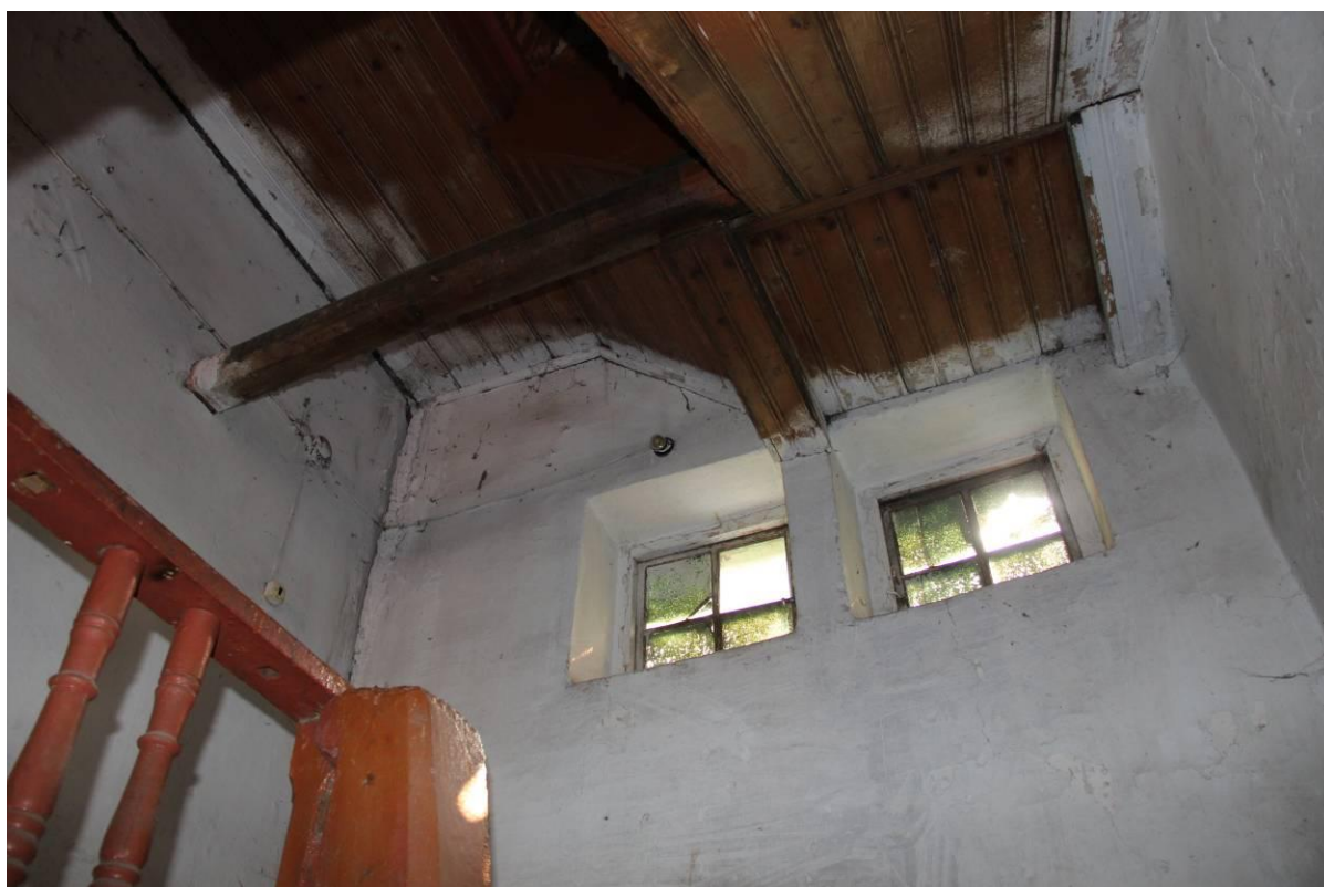
Видовая точка № 18 Помещение лестницы дворовой пристройки
