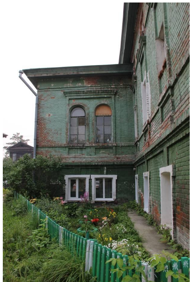
Видовая точка № 6 Фрагмент дворового фасада
