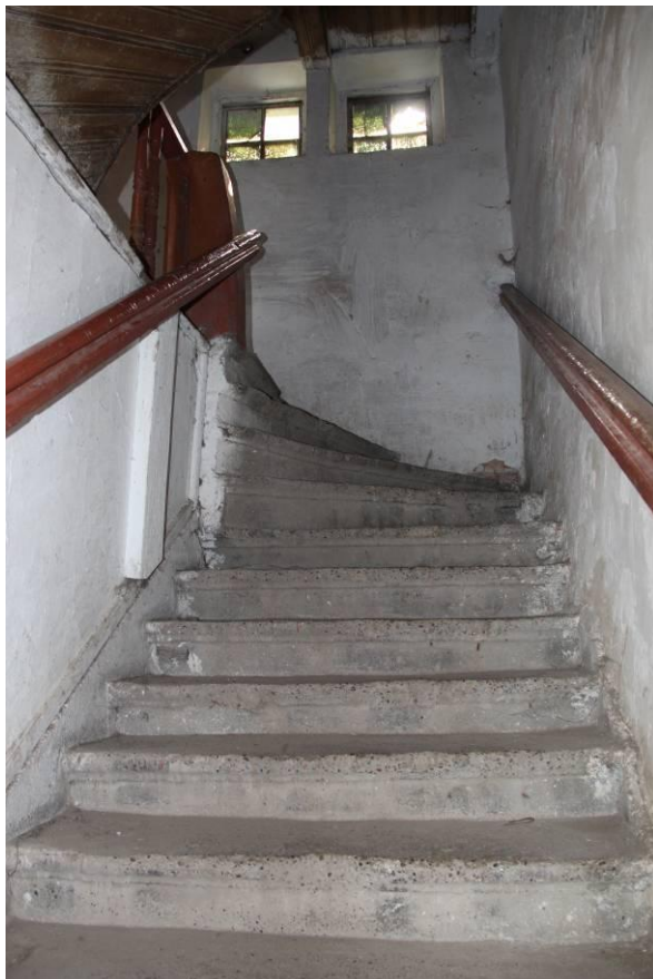
Видовая точка № 16 Пристройка. Лестница на 2-й этаж
