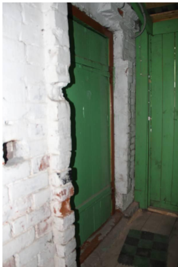
Видовая точка № 15 Деревянная дверь на шпонках и кованых навесах (1 этаж пристройки)
