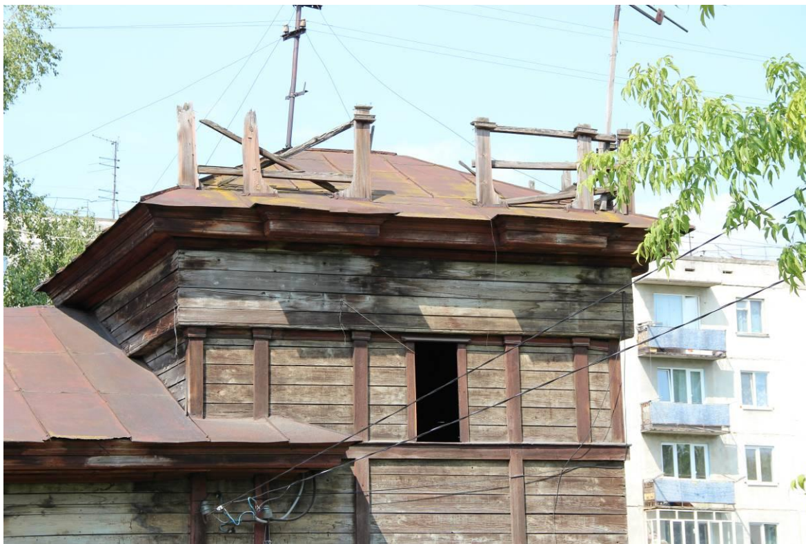
Видовая точка № 5. Фрагмент главного фасада. Угловая башня.
