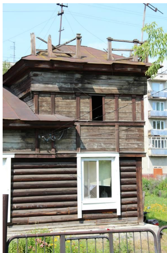
Видовая точка № 7 Фрагмент главного фасада. Угловая башня.
