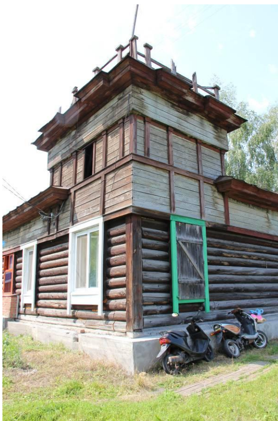
Видовая точка № 6 Северо-восточный угол здания. Угловая башня.
