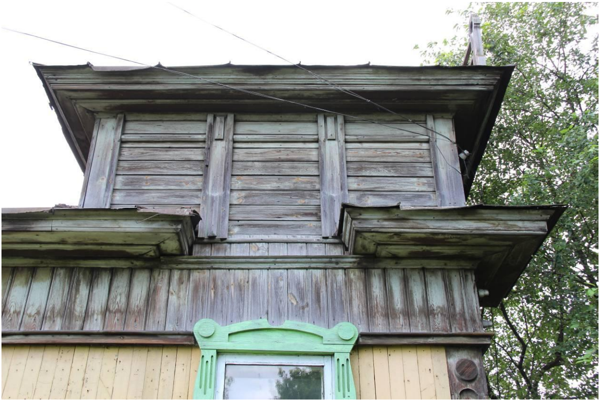
Видовая точка № 6 Фрагмент северного фасада. Угловая башня.
