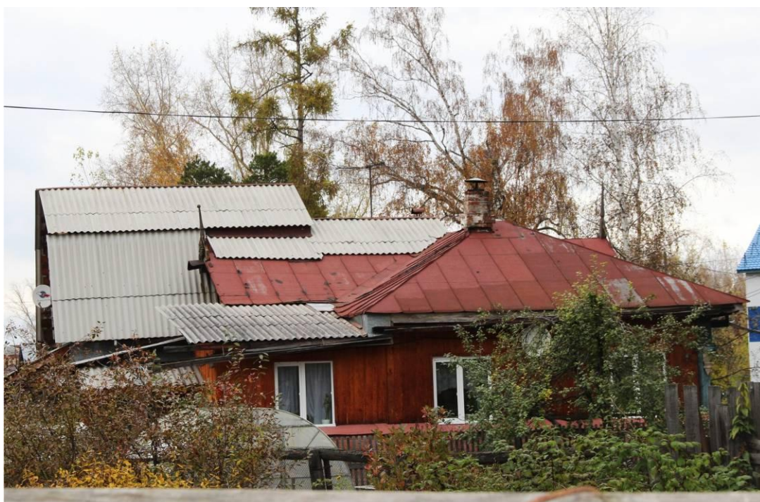
Видовая точка № 4 Южный фасад здания (2017 г.).
