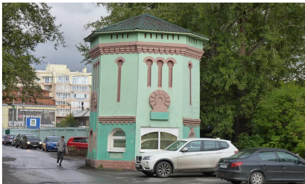
Видовая точка № 2. Общий вид башни с пр. Ленина. Западный фасад.
