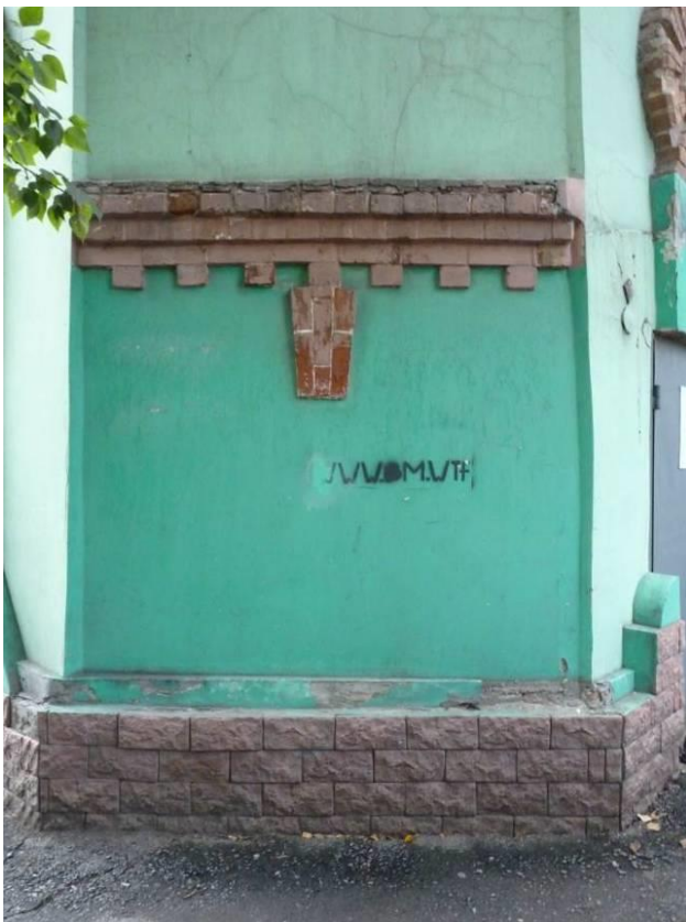
Видовая точка № 7. Профильный междуэтажный карниз с «сухариками»
