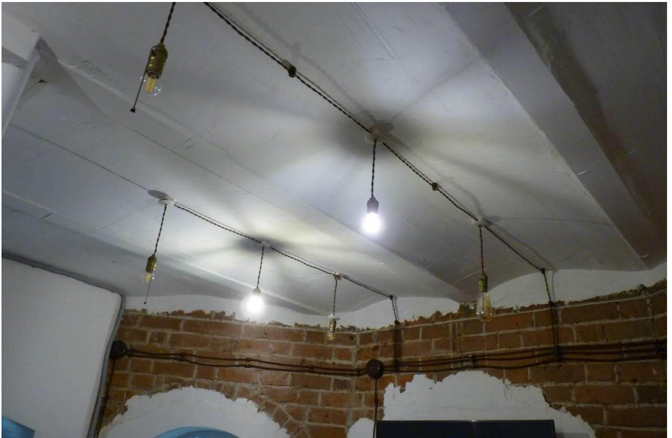
Видовая точка № 9. Фрагмент междуэтажного перекрытия (кирпичные своды по металлическим балкам)
