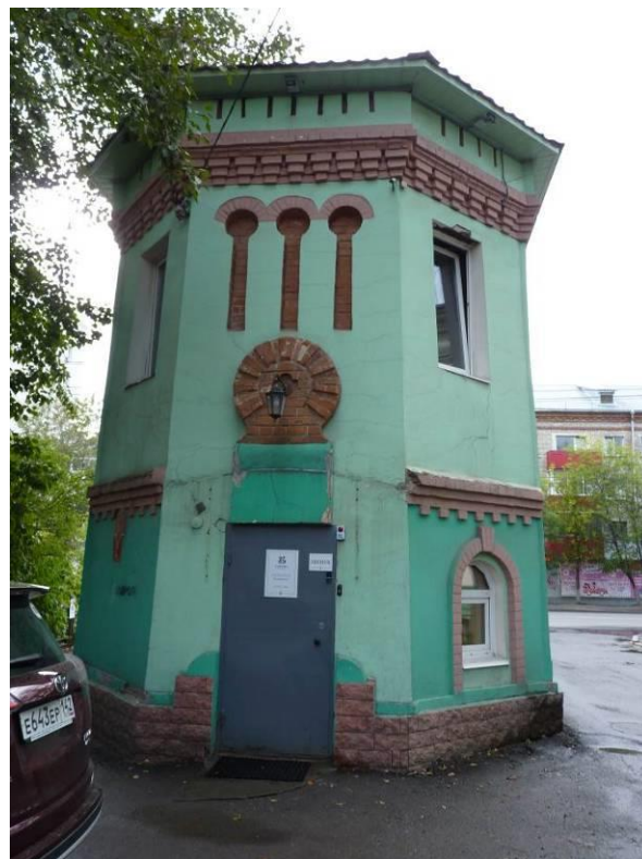
Видовая точка № 4. Вид башни с восточной стороны
