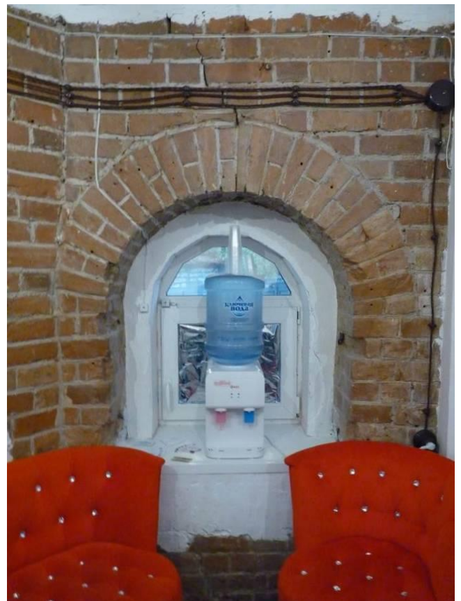
Видовая точка № 11. Арочное окно помещения 1-го этажа
