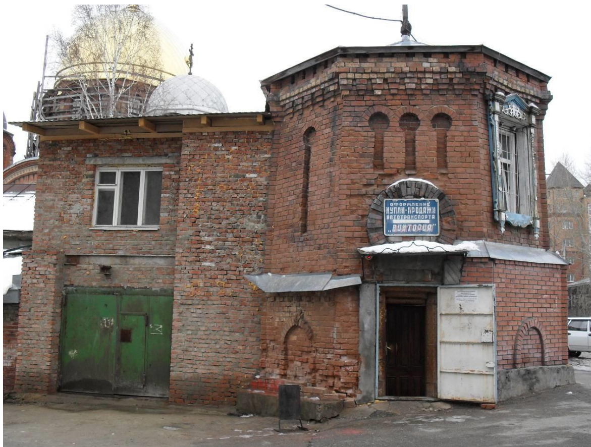
Видовая точка № 4. Южный фасад (2011 г.).
