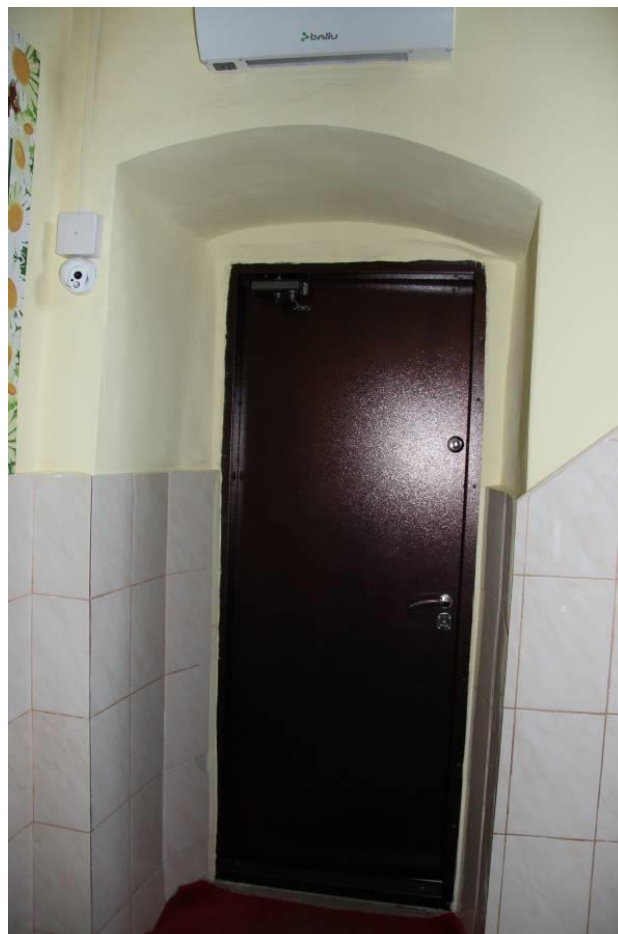
Видовая точка № 17 Дверной проем с лучковой перемычкой
