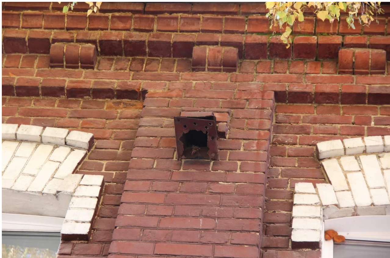
Видовая точка № 7. Фрагмент главного фасада здания. Вентиляционный пропуск
