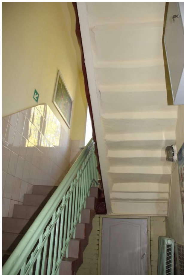
Видовая точка № 15 Лестница северо-западной части здания
