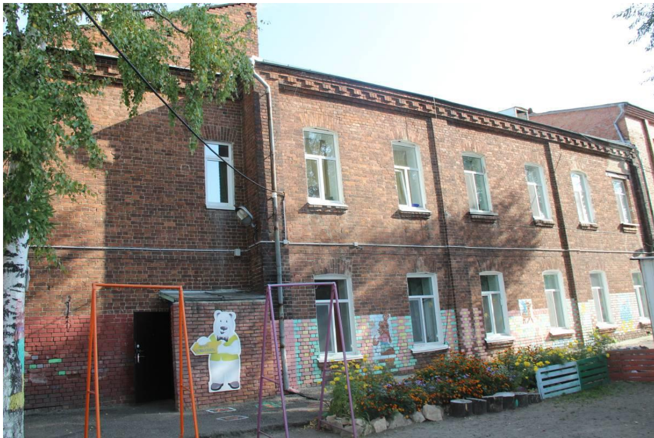
Видовая точка № 9. Дворовый (западный) фасад
