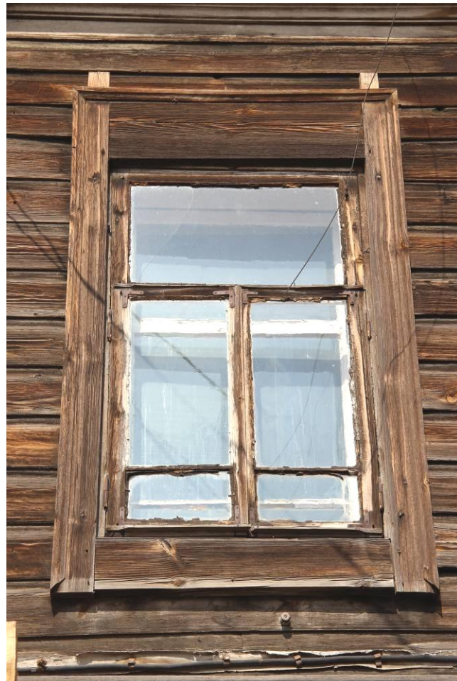
Видовая точка № 4. Деревянные рамы окна 2-го этажа
