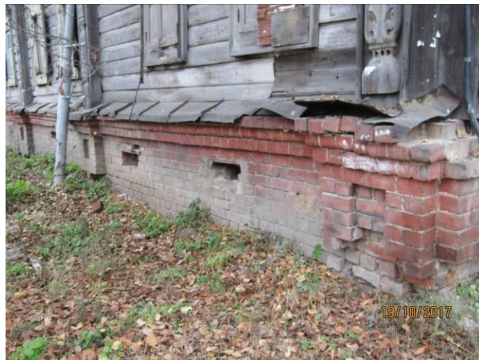
Видовая точка № 11 Цоколь с вентиляционными отверстиями северного фасада (2017 г.)
