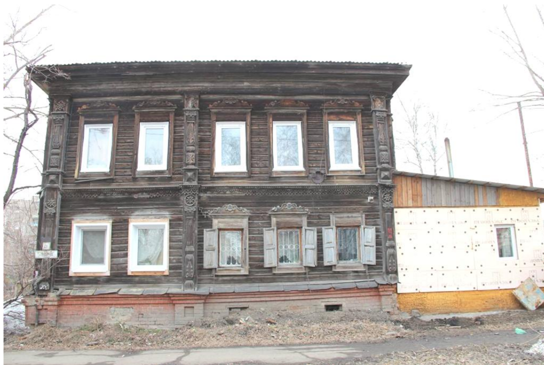
Видовая точка № 2. Главный западный фасад здания (08.04.2020 г.).
