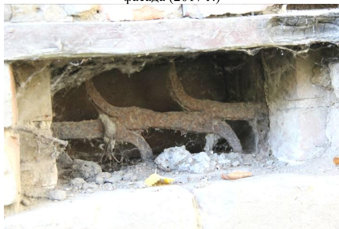
Видовая точка № 12 Вентиляционный продух подвала. Кованая решетка
