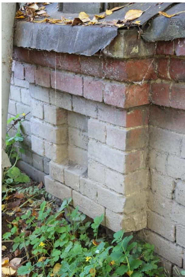
Видовая точка № 10 Фрагмент декора цоколя (2017 г.)
