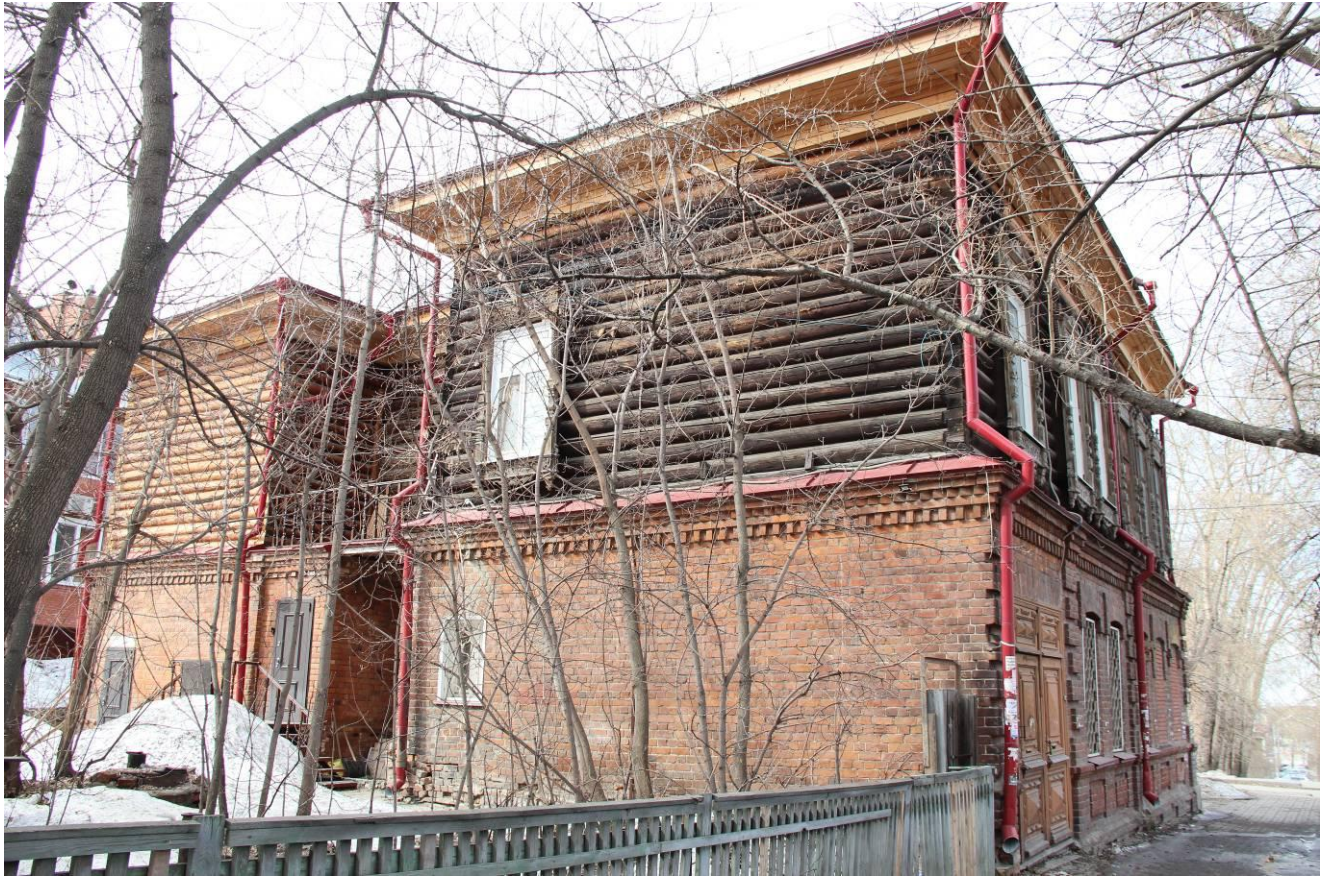
Видовая точка № 3. Дворовый (восточный) фасад (08.04.2020)
