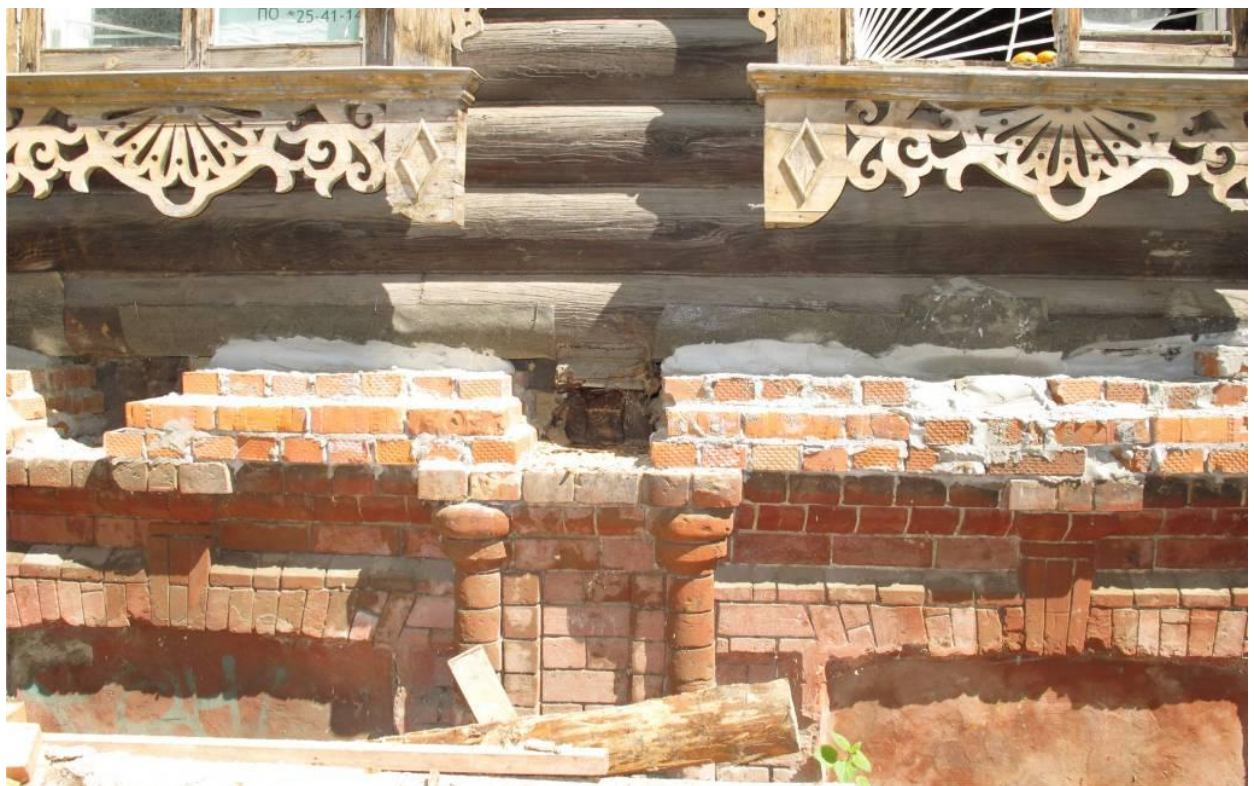
Видовая точка № 11. Фрагмент декора кирпичного цоколя главного фасада (до проведения ремонтных работ).
