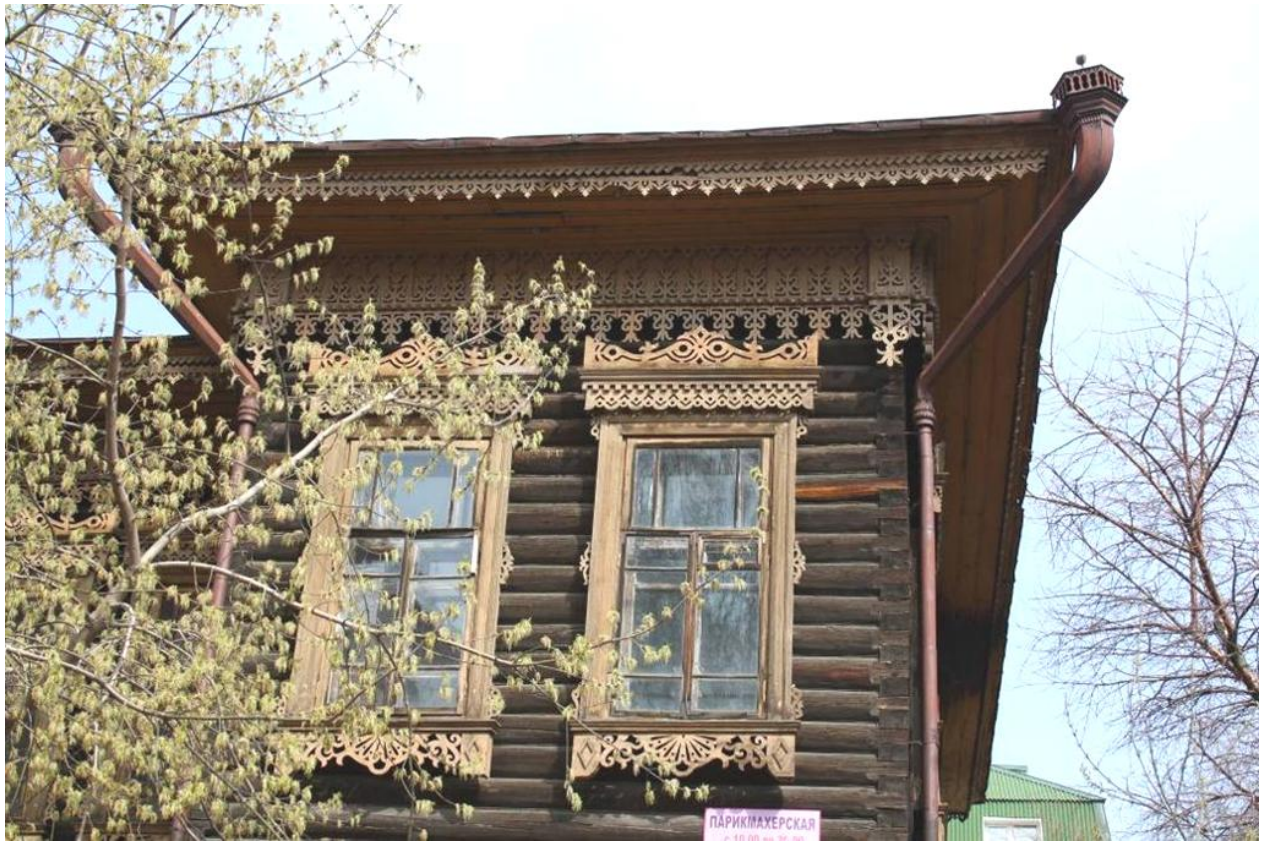
Видовая точка № 10. Фрагмент ризалита южного фасада (до проведения ремонтных работ).
