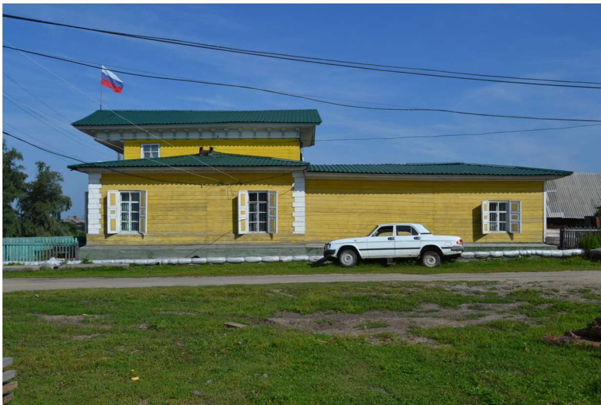
Видовая точка № 3. Фрагмент бокового фасада (ТГАСУ, 2017 г.)
