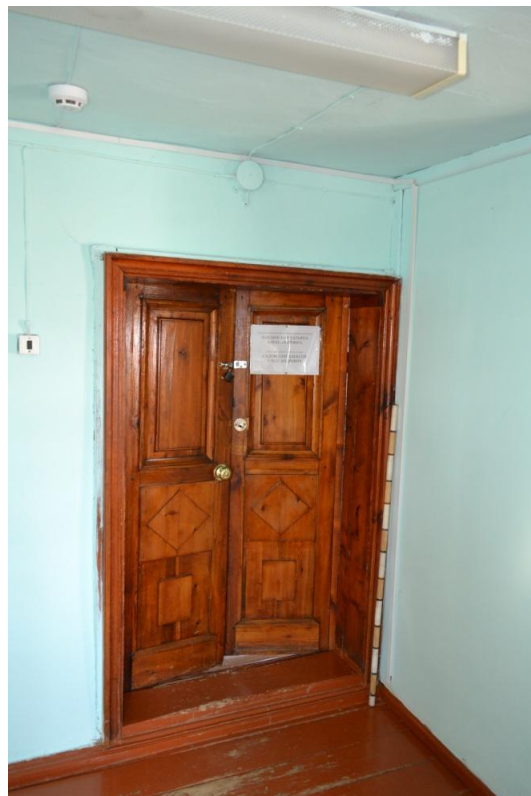
Видовая точка № 11. Дверь деревянная филенчатая (ТГАСУ, 2017 г.)
