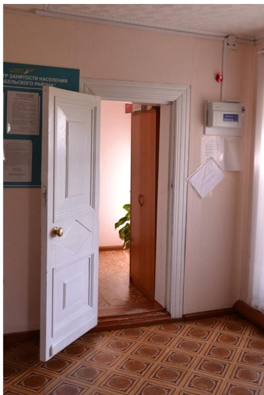
Видовая точка № 10. Дверь деревянная филенчатая (ТГАСУ, 2017 г.)
