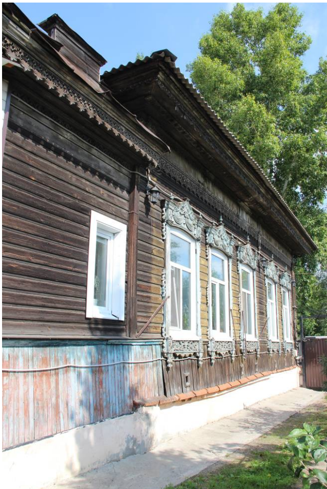
Видовая точка № 7. Боковой (восточный) фасад
