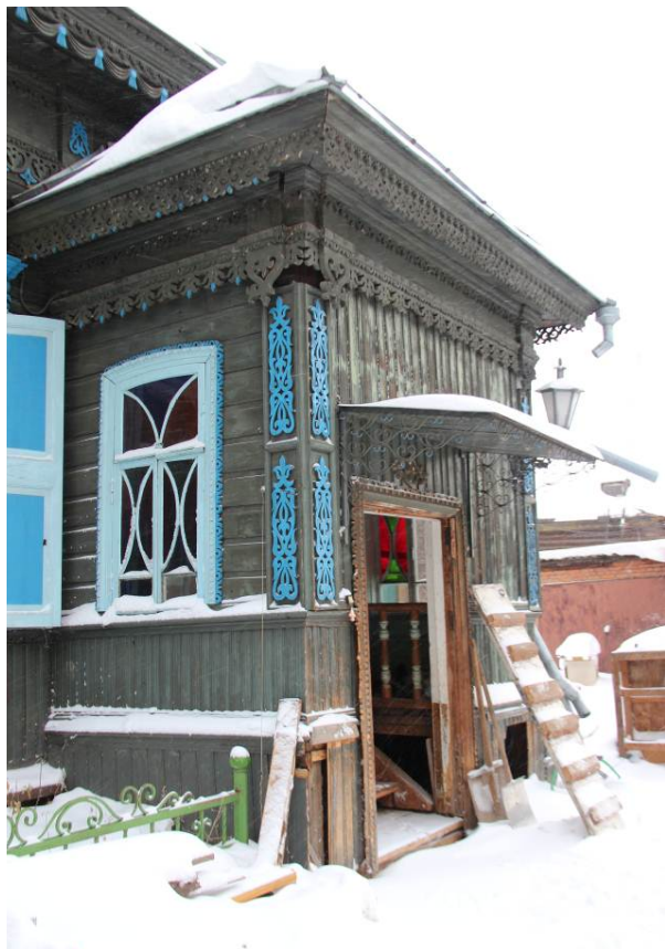
Видовая точка № 12. Тамбур входа западного фасада (2014 г.).
