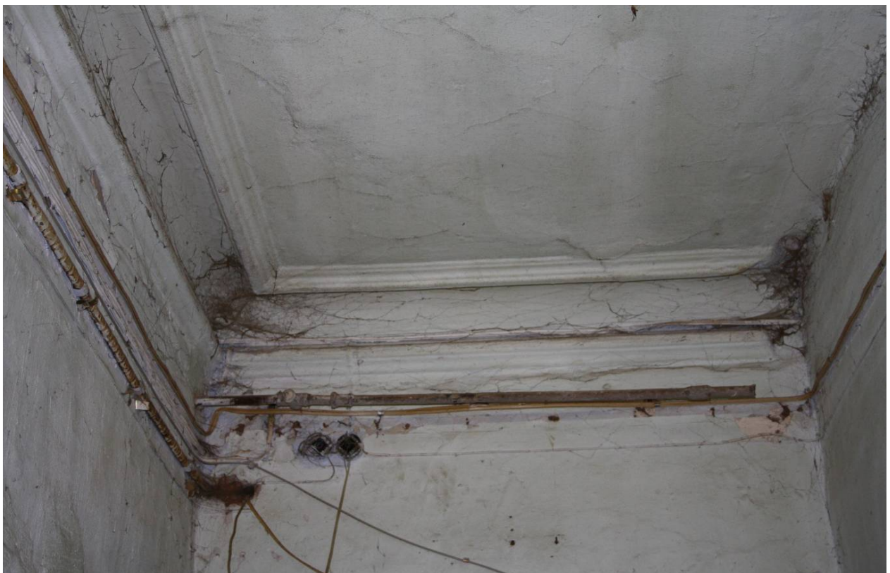
Видовая точка № 12. Профильные штукатурные тяги в отделке потолка коридора (фото: Фишко М.В., 2013 г.)
