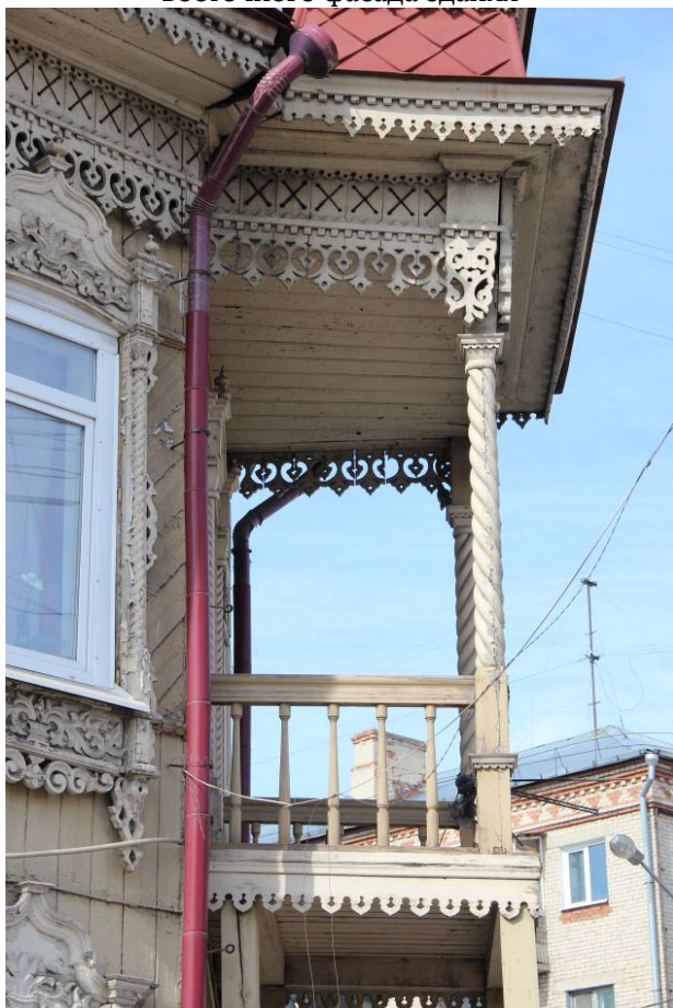
Видовая точка № 8. Угловой балкон
