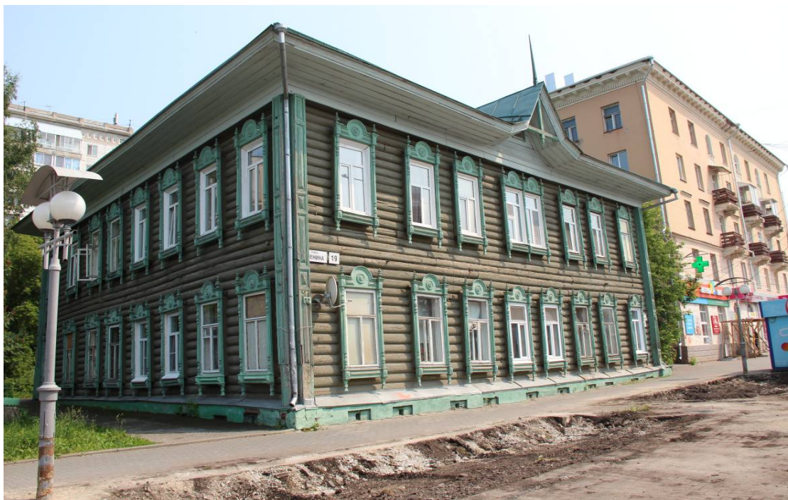
Видовая точка № 2. Вид здания с северо-западной стороны
