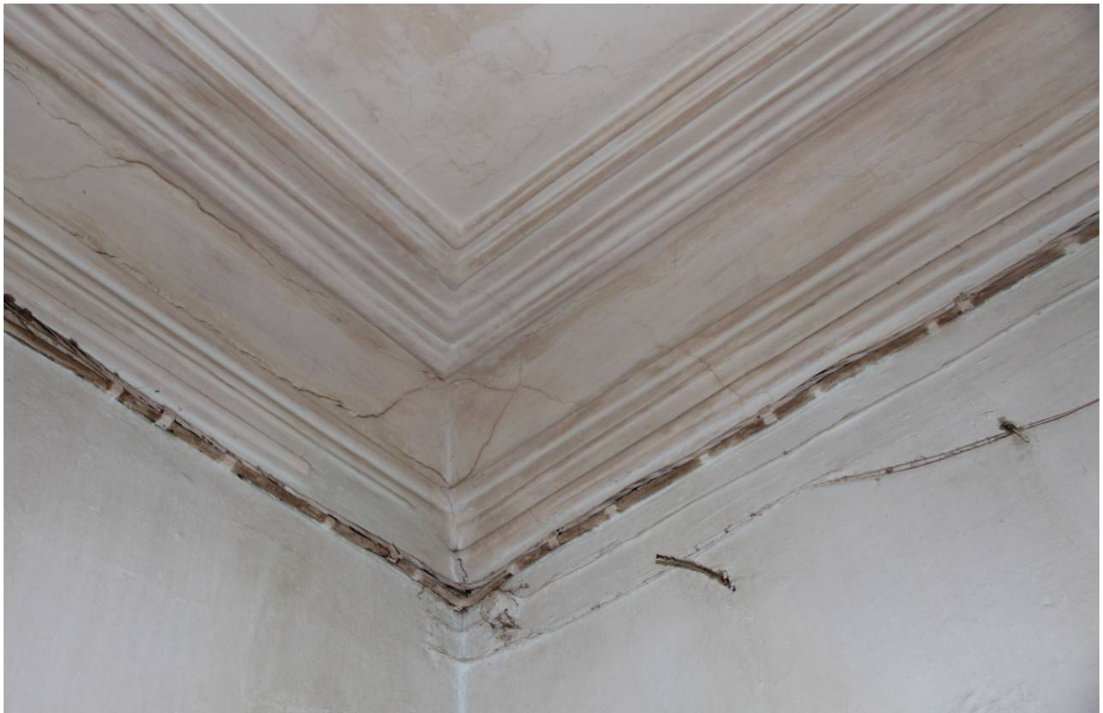
Видовая точка № 9. Профильные потолочно-стенные штукатурные тяги (фото: Яблонской М.А., 2015 г.)
