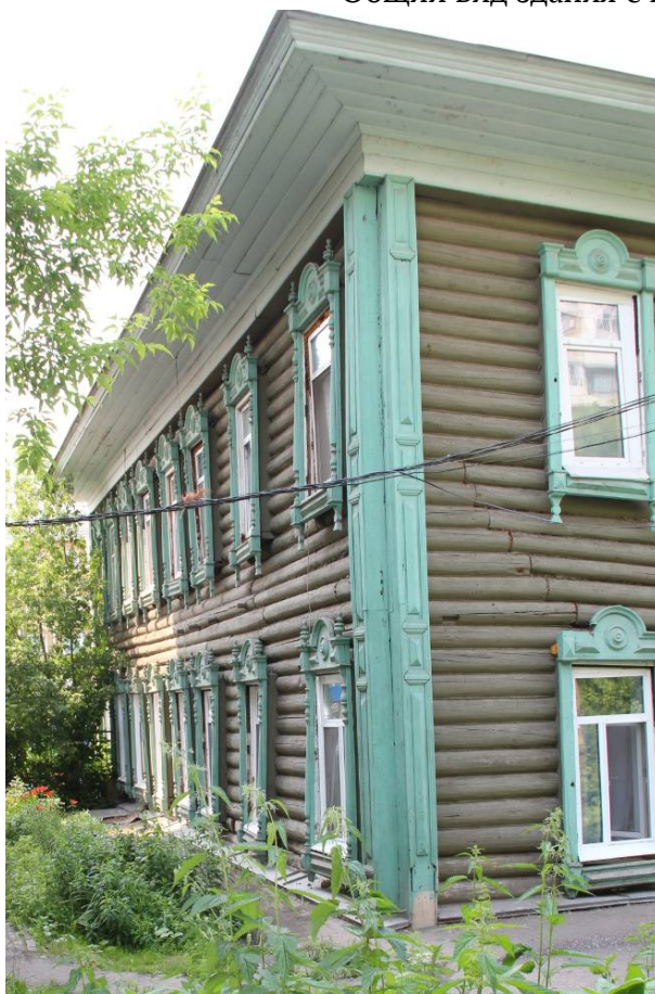
Видовая точка № 7. Юго-восточный угол дома. Угловые пилястры
