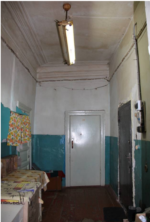
Видовая точка № 10. Коридор 2-го этажа с фрагментами штукатурного декора потолка (фото: Яблонской М.А., 2015 г.)
