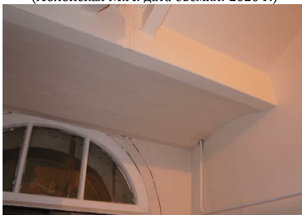
Видовая точка № 20. Кирпичный свод по металлическим балкам лестничной площадки (дата съемки: 2020 г.)
