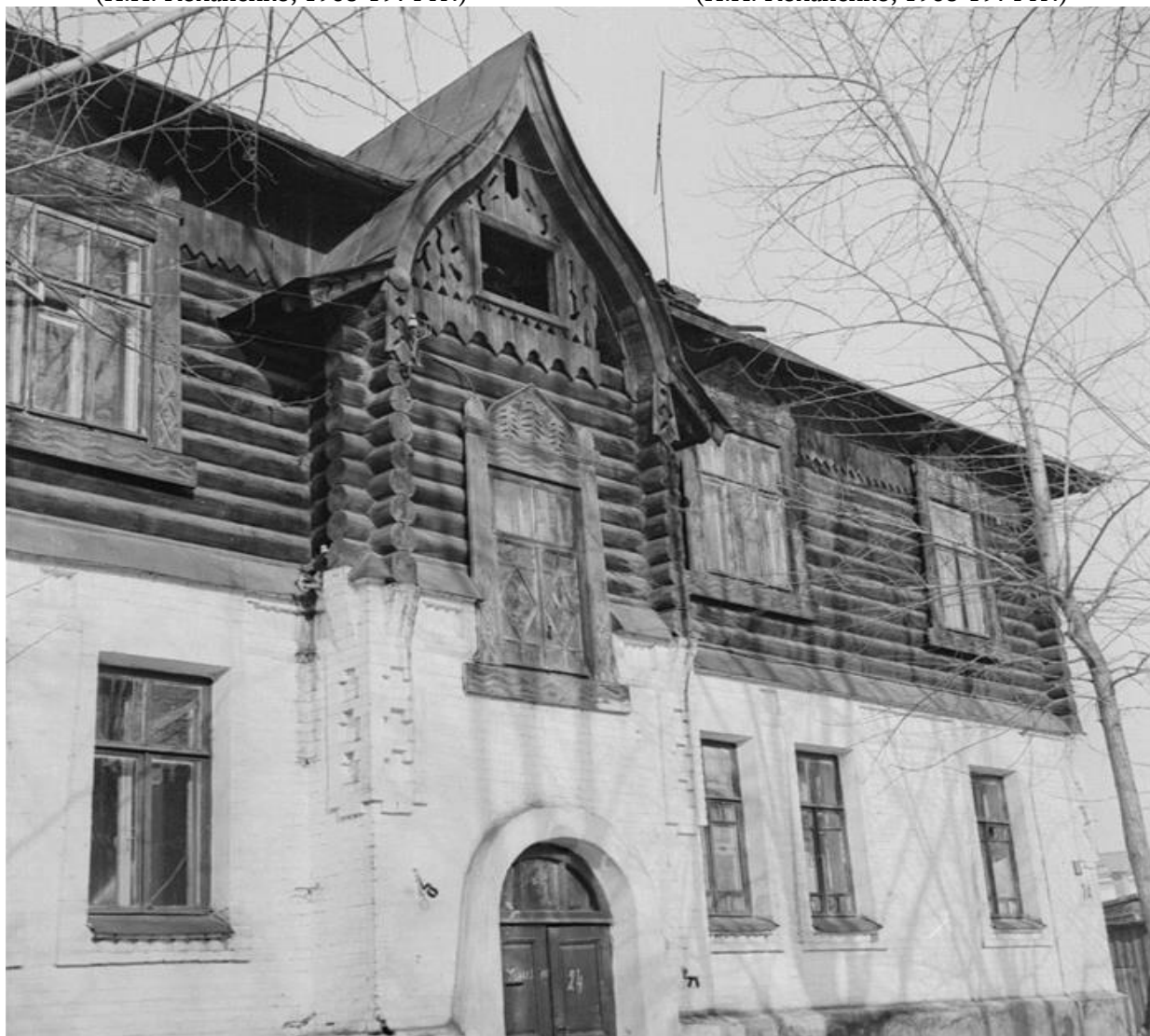
Видовая точка № 30. Восточный фасад. Историческая расстекловка заполнений оконных проемов (фото: П.Н. Коханенко, 1968-1974 гг.)
