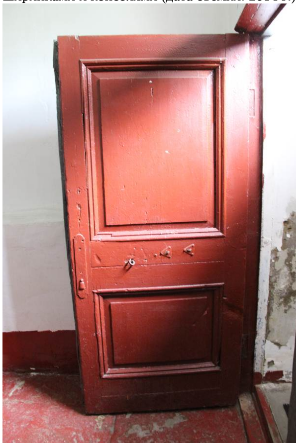
Видовая точка № 15. Деревянные филенчатые двери главного входа (Горбань К. Е., дата съемки: 2020 г.)
