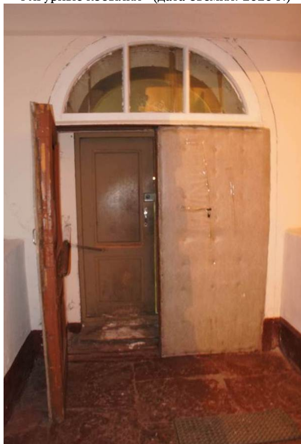
Видовая точка № 16. Двойные двери парадного входа с остекленной фрамугой (дата съемки: 2014 г.)
