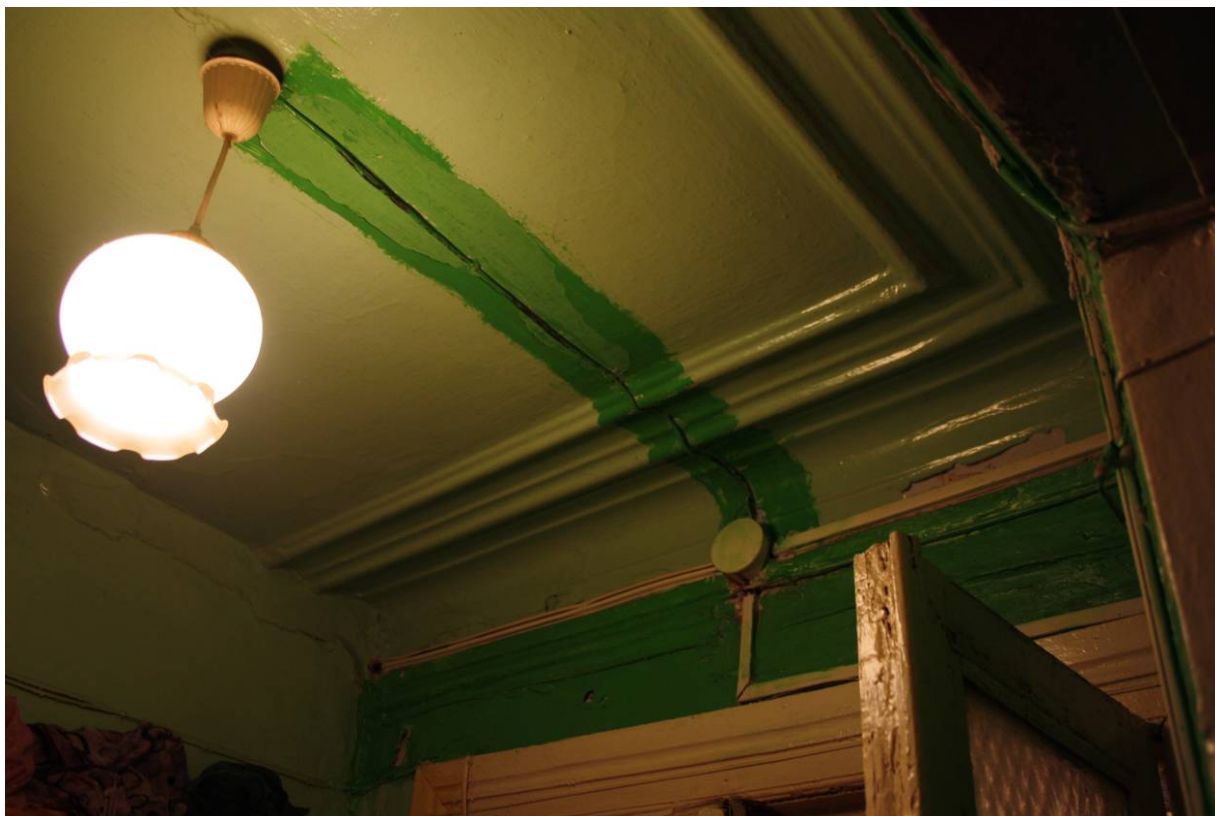
Видовая точка № 14 Квартира 1-го этажа. Потолочные тяги в отделке потолка помещения (Артюховский Г.Т., дата съемки: 15.06.2016 г.)
