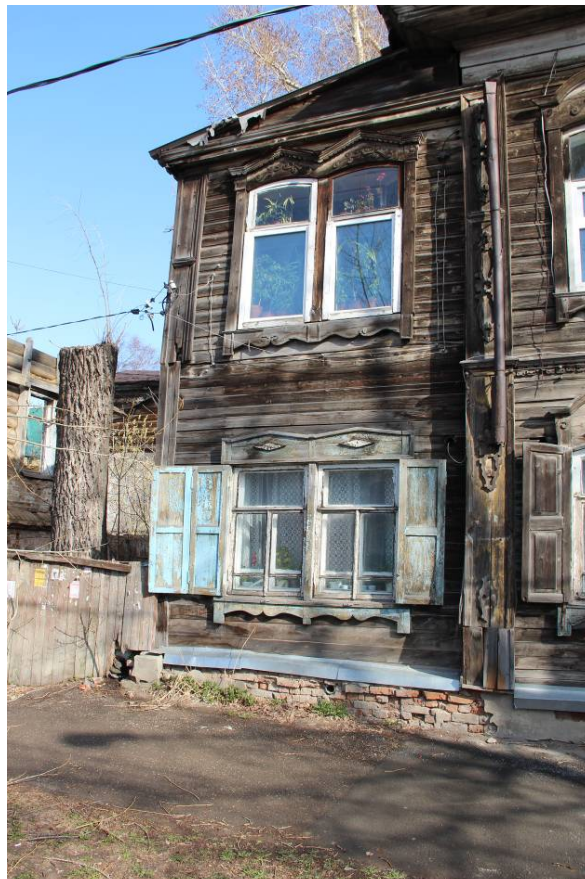
Видовая точка № 12 Фрагмент главного (южного) фасада.
