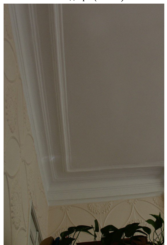
Видовая точка № 25. Штукатурные профилированные тяги в отделке потолка кабинета 1-го этажа
