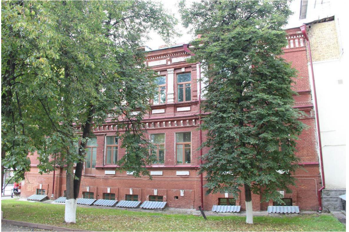
Видовая точка № 3. Восточный фасад. Общий вид здания
