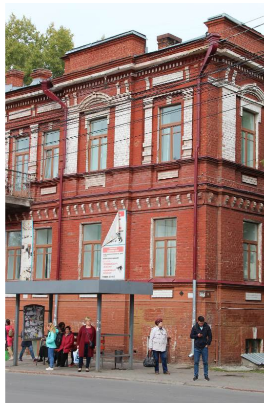
Видовая точка № 11. Юго-восточный угол здания. Ризалиты
