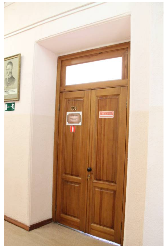
Видовая точка № 19. Профилированное обрамление откосов дверного проема (2 этаж)
