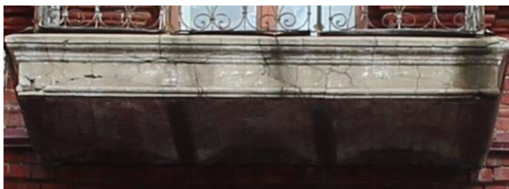
Видовая точка № 30. Кирпичные своды по металлическим балкам, профильные тяги на торцах балконной плиты
