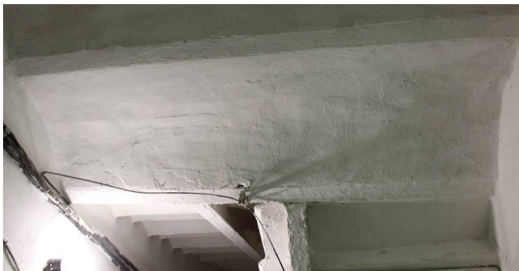
Видовая точка № 28. Кирпичные своды лестничной площадки (подвал)
