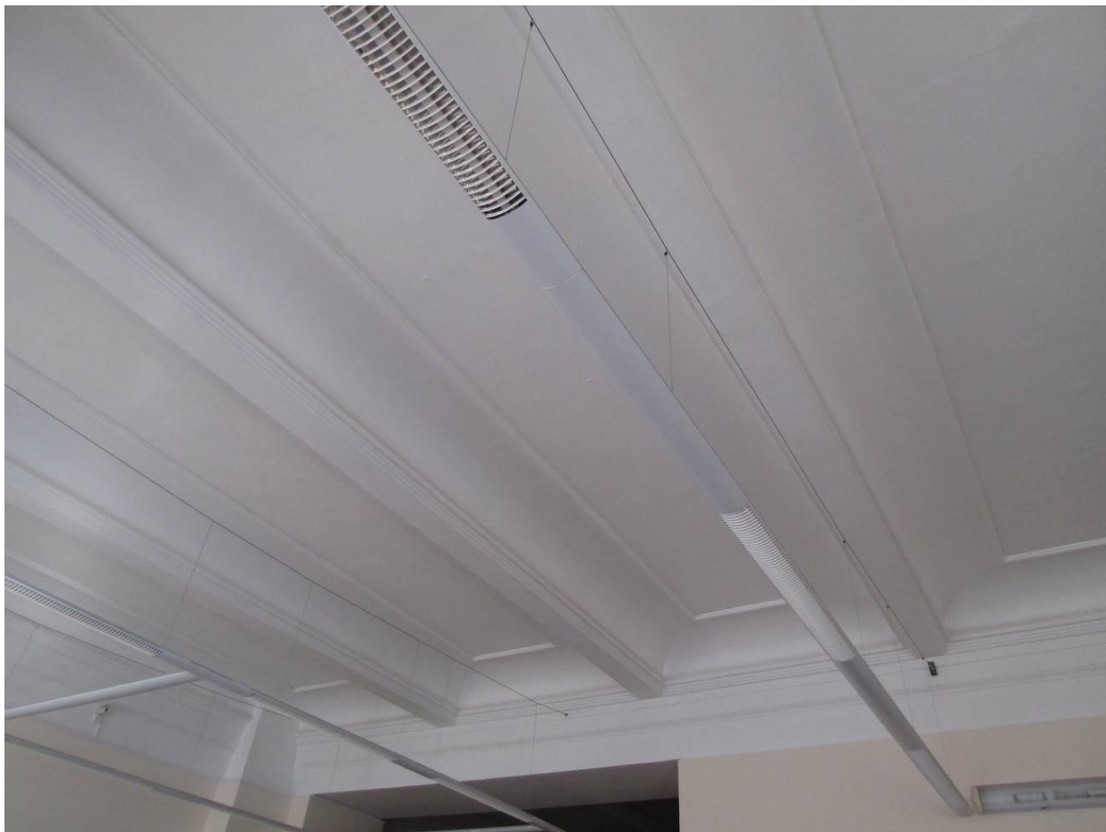
Видовая точка № 17. Профильный штукатурный декор бетонного перекрытия помещения 1-го этажа южного крыла здания (Артюховский Г.Т., 13.03.2020 г.)
