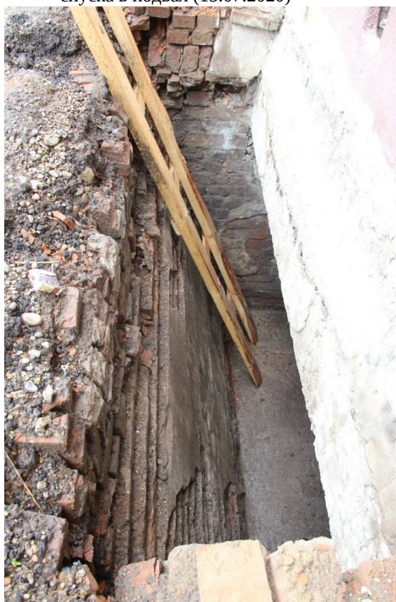
Видовая точка № 59. Приямок окна подвала южного дворового фасада (14.05.2020)
