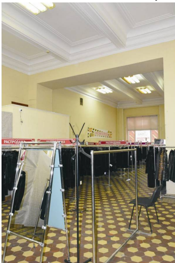
Видовая точка № 15. Фрагмент декора торгового зала южного крыла (ООО Электромонтаж, 2020 г.)
