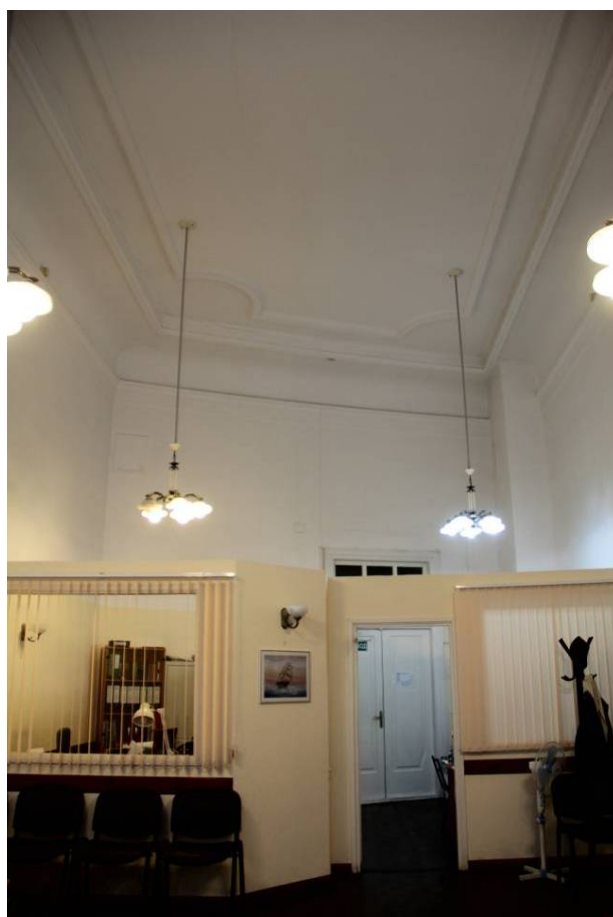
Видовая точка № 30. Общий вид помещения угловой части здания, декор потолка (19.11.2020)
