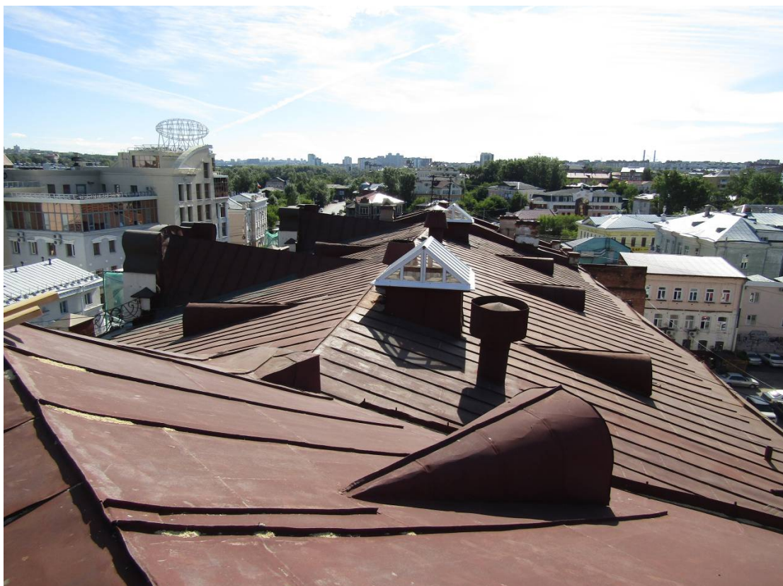
Видовая точка № 64. Крыша восточного крыла здания, световые фонари, слуховые окна (автор снимка: Артюховский Г.Т., дата съемки: 15.07.2020 г.)
