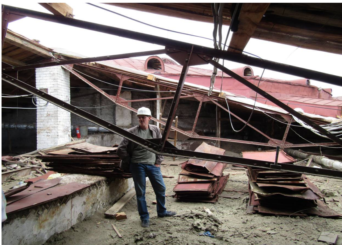
Видовая точка № 65. Металлические фермы стропильной конструкции южного крыла здания (автор снимка: Артюховский Г.Т., дата съемки: 09.06.2020 г.)
