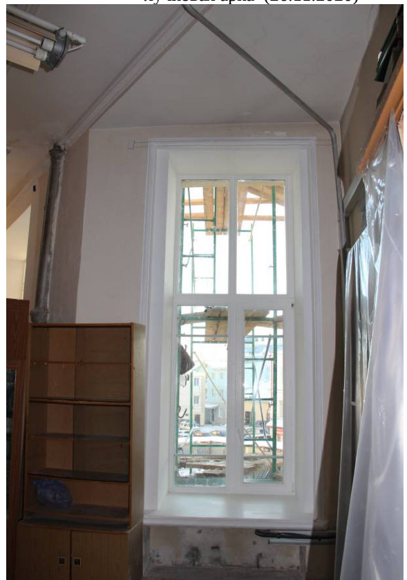
Видовая точка № 49. Профильное обрамление оконного проема (26.11.2020)
