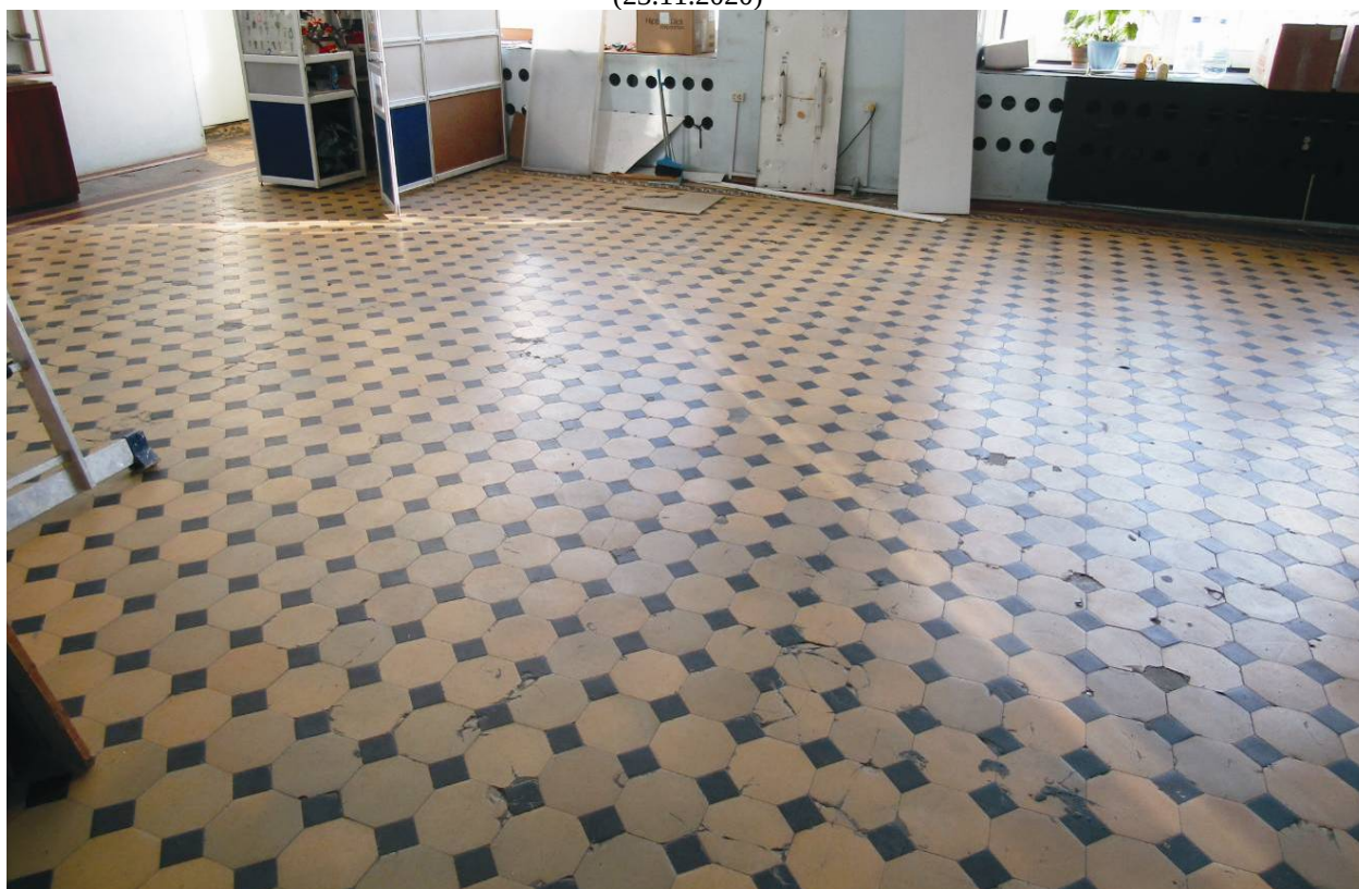
Видовая точка № 13. Покрытие пола торгового помещения 1-го этажа южного крыла здания из метлахской керамической плитки (30.10.2019)
