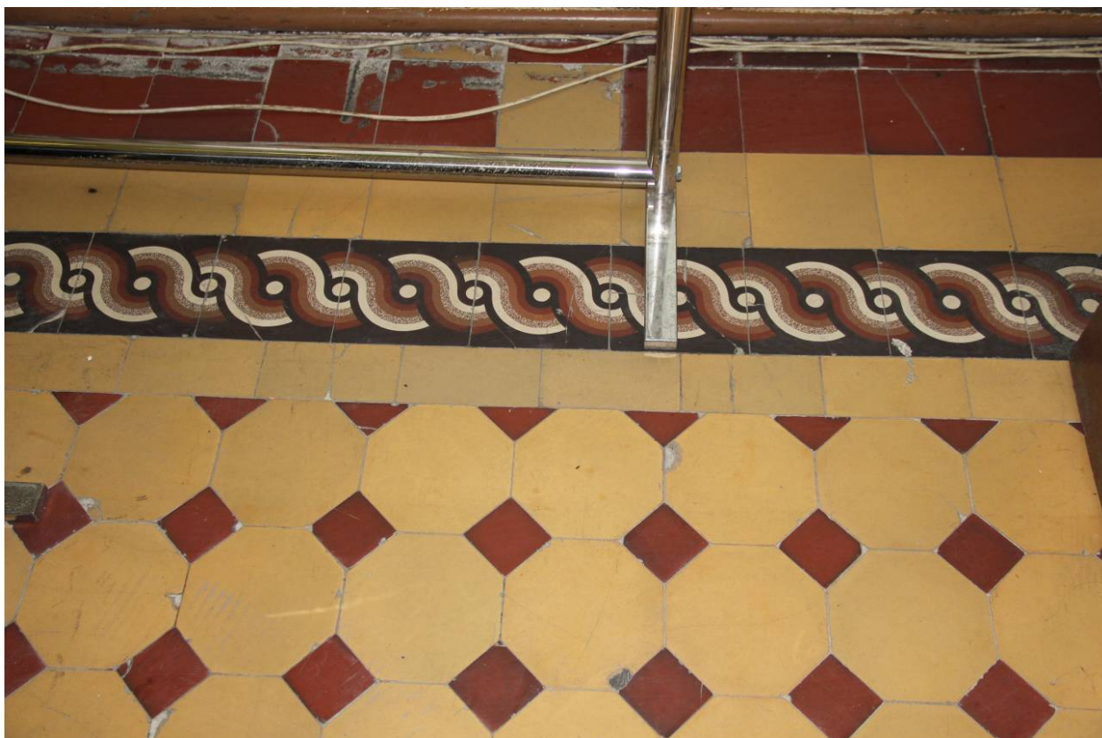
Видовая точка № 12. Метлахская керамическая плитка покрытия пола углового торгового помещения 1-го этажа (23.11.2020)
