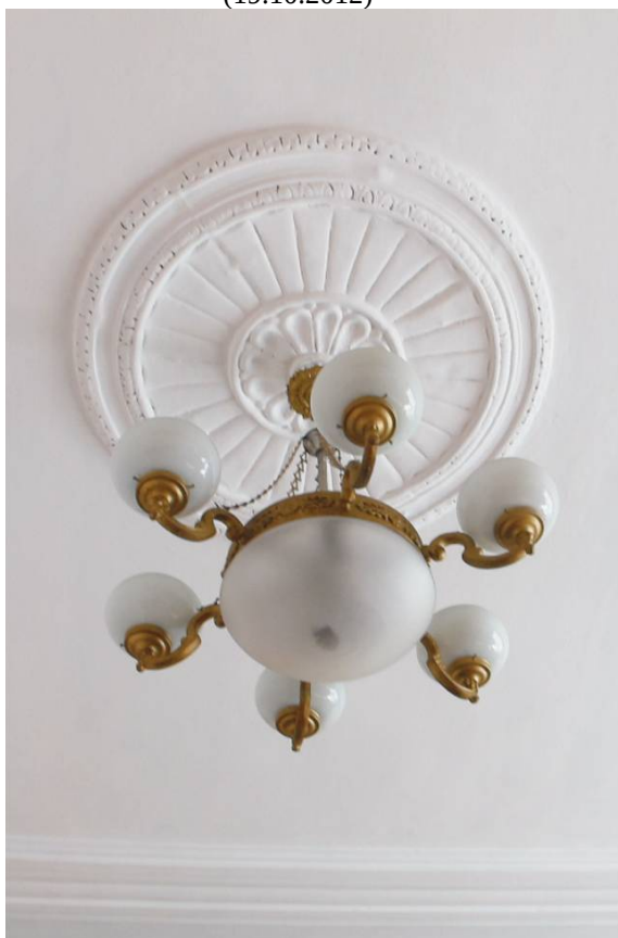
Видовая точка № 27. Потолочная розетка (19.10.2012)
