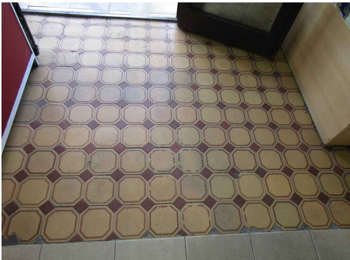
Видовая точка № 14. Покрытие пола торгового помещения 1-го этажа южного крыла здания из метлахской керамической плитки (30.10.2019)
