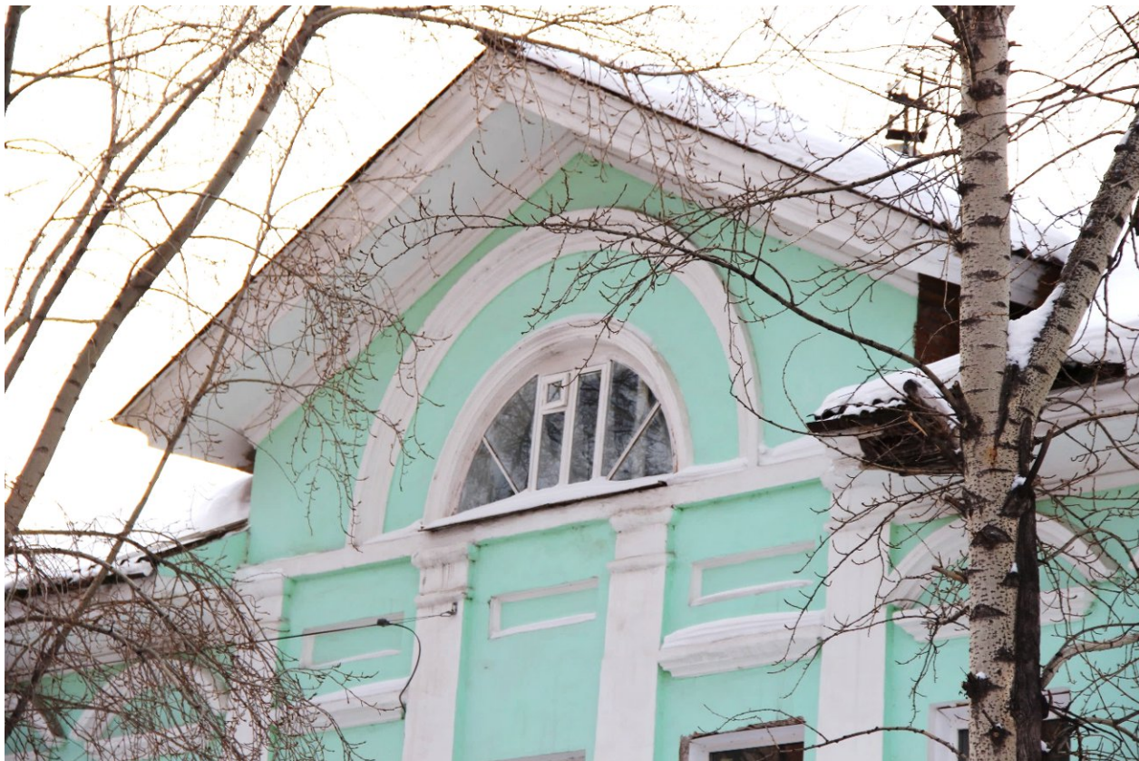
Видовая точка № 7 Фрагмент главного восточного фасада. Мезонин
