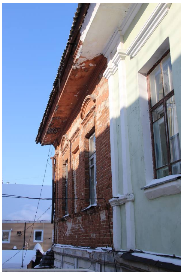
Видовая точка № 9 Фрагмент южного фасада
