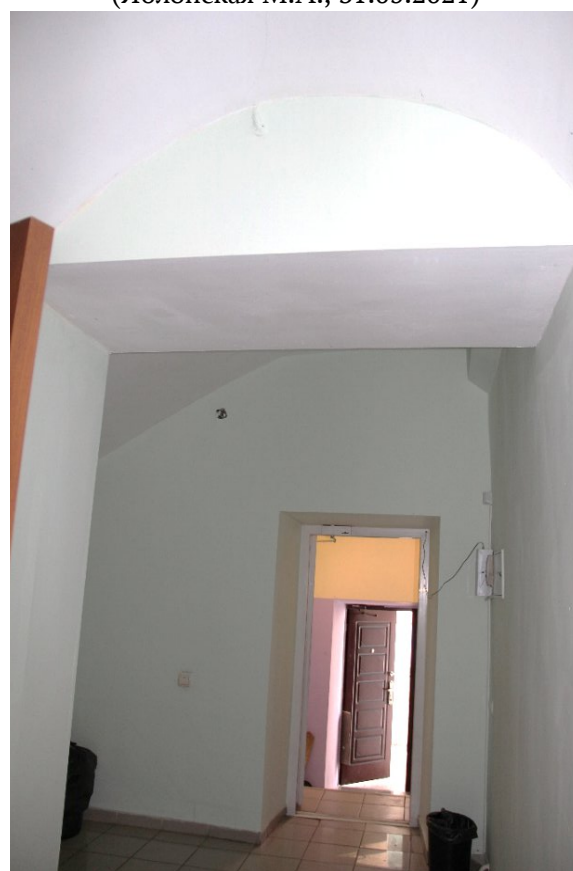
Видовая точка № 17 Общий вид помещения 1-го этажа (Рыжикова А.Ю., 2015 г.)
