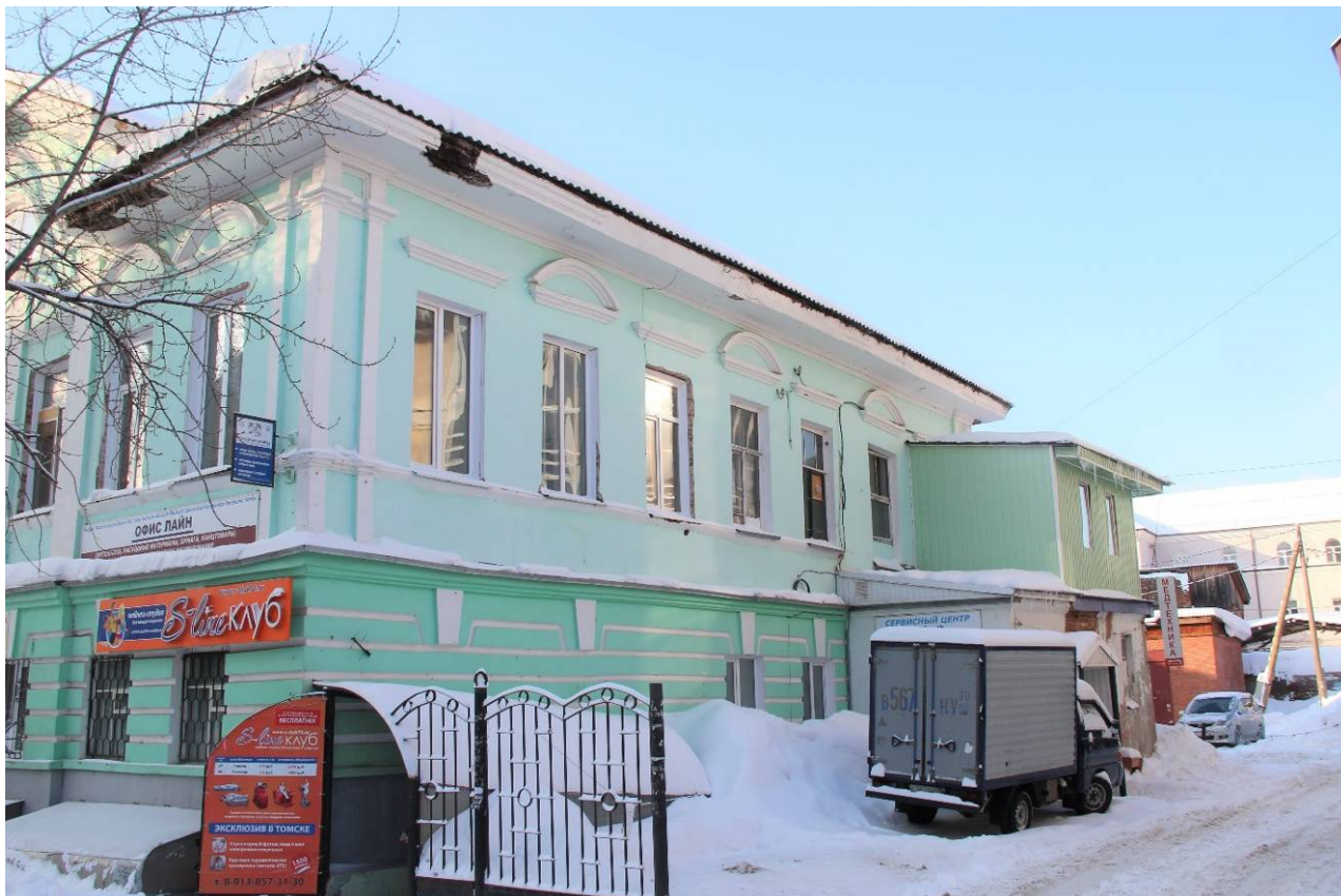
Видовая точка № 3. Северный фасад здания
