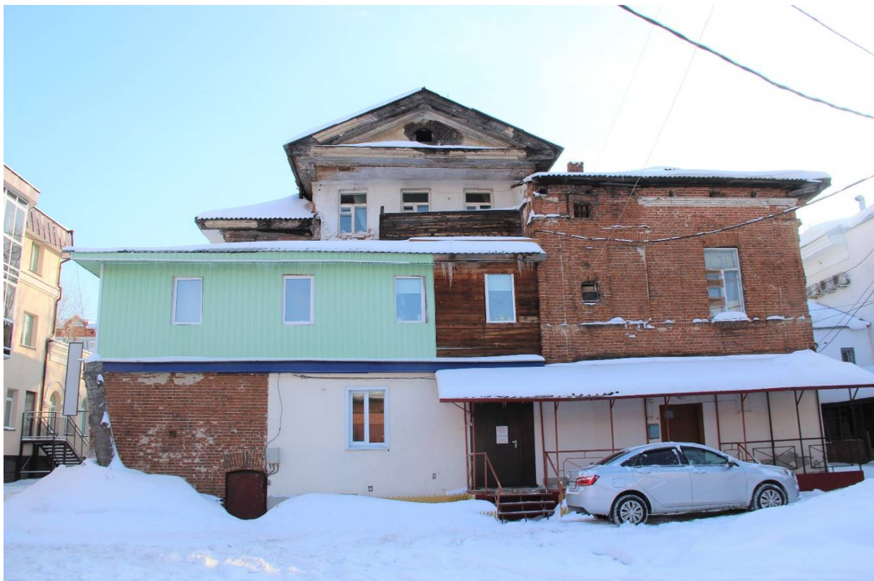
Видовая точка № 5 Западный дворовый фасад здания
