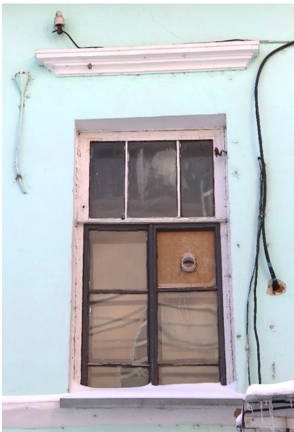
Видовая точка № 10 Окно 2-го этажа северного фасада
