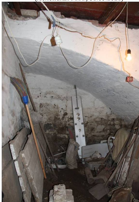
Видовая точка № 21 Кирпичная арка в помещении подвала (Яблонская М.А., 31.05.2021)
