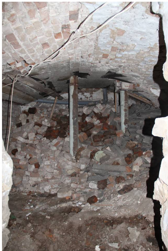
Видовая точка № 19 Помещение подвала с кирпичным сводом (Яблонская М.А., 31.05.2021)
