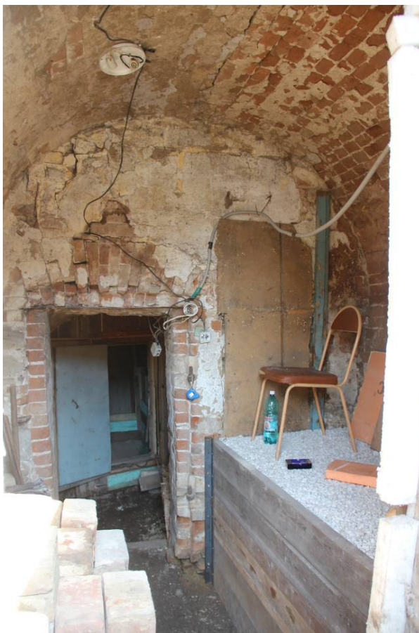
Видовая точка № 18 Помещение входа в подвал с кирпичным сводом (Яблонская М.А., 31.05.2021)
