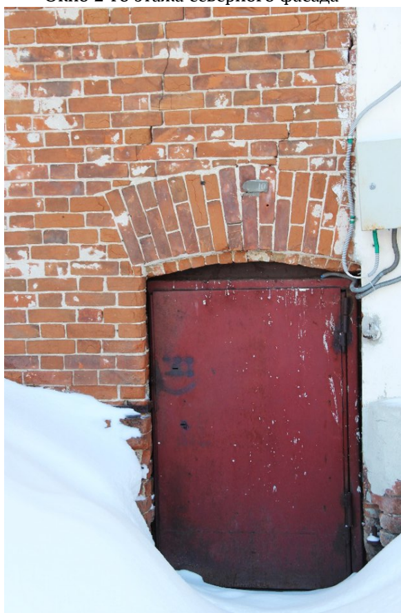
Видовая точка № 12 Дверной проем с лучковой перемычкой западного фасада (вход в подвал)
