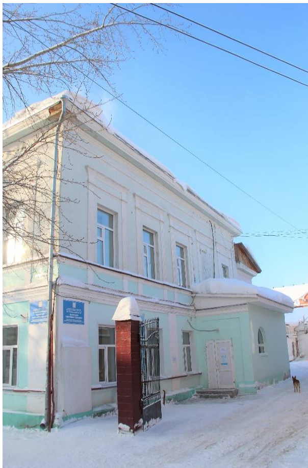
Видовая точка № 5. Боковой северный фасад здания
