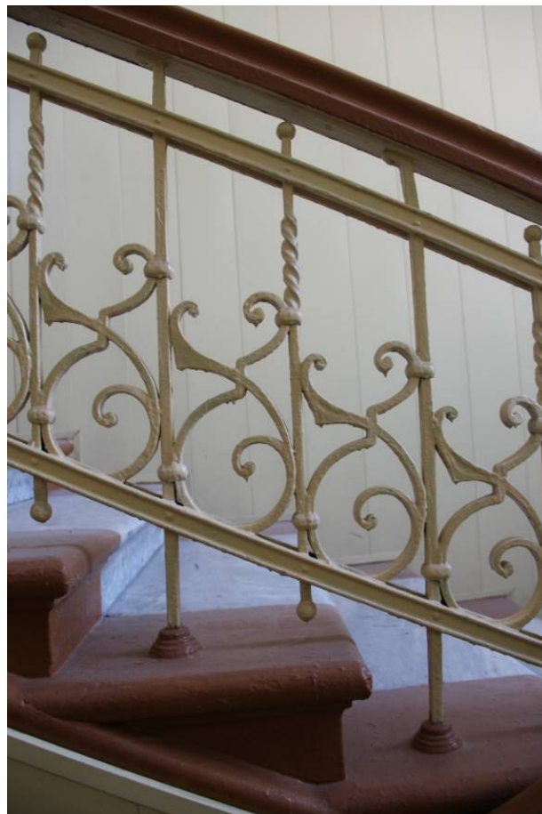
Видовая точка № 13. Фрагмент кованого ограждения лестницы (Рыжикова А.Ю., 2015 г.)
