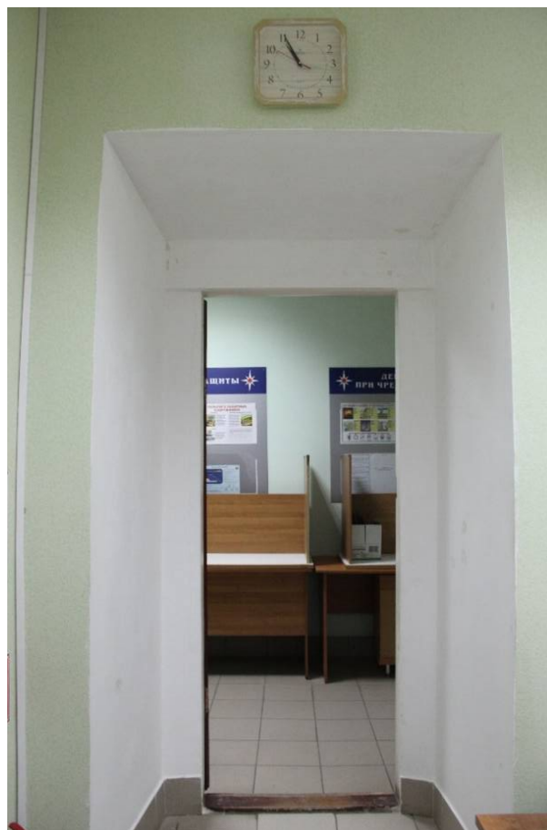
Видовая точка № 18. Дверной проем помещения 1-го этажа
