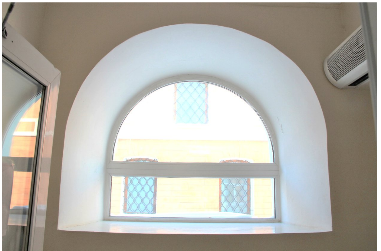
Видовая точка № 9. Арочное окно входного тамбура
