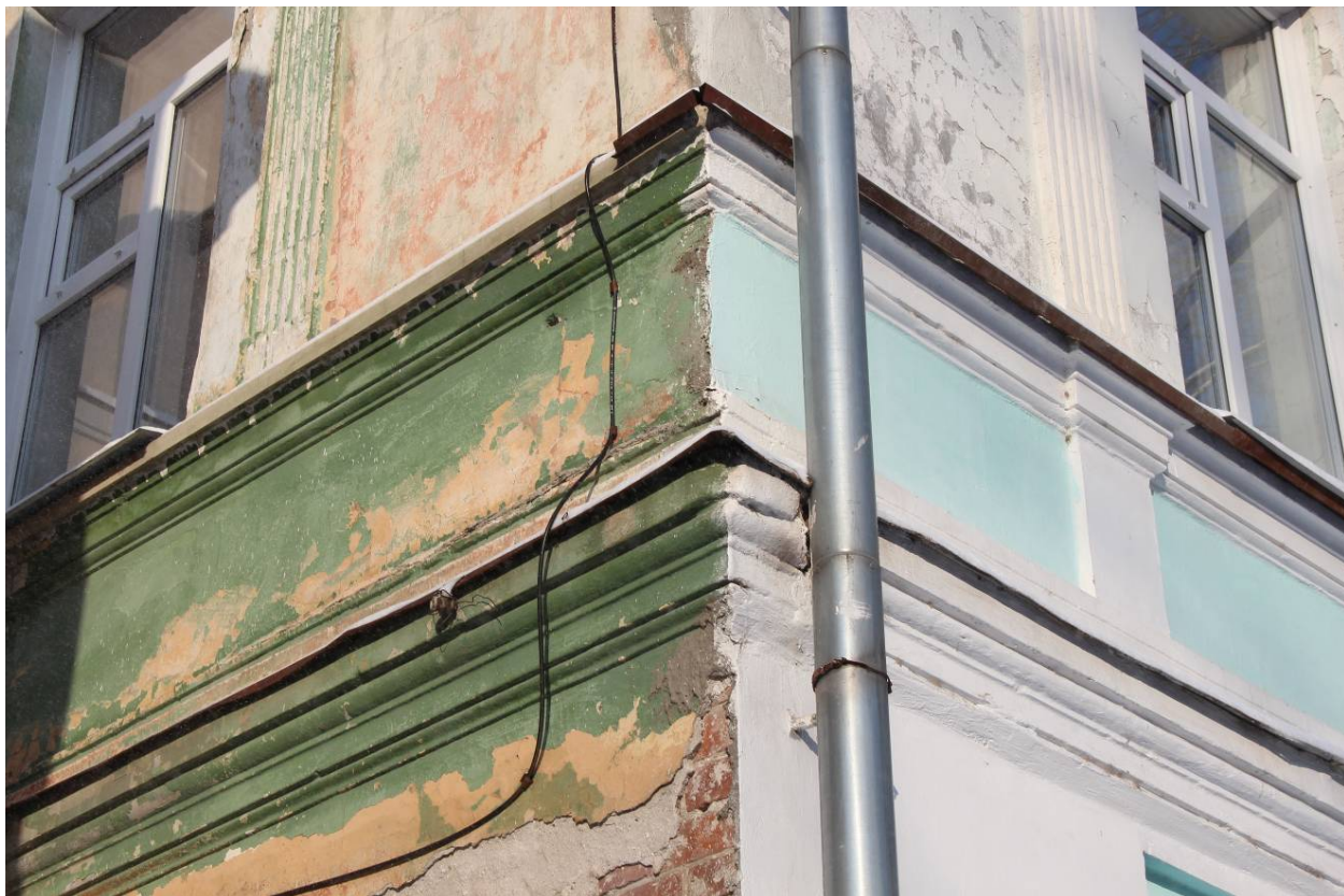
Видовая точка № 4. Юго-восточный угол здания, профильные штукатурные тяги междуэтажного пояса
