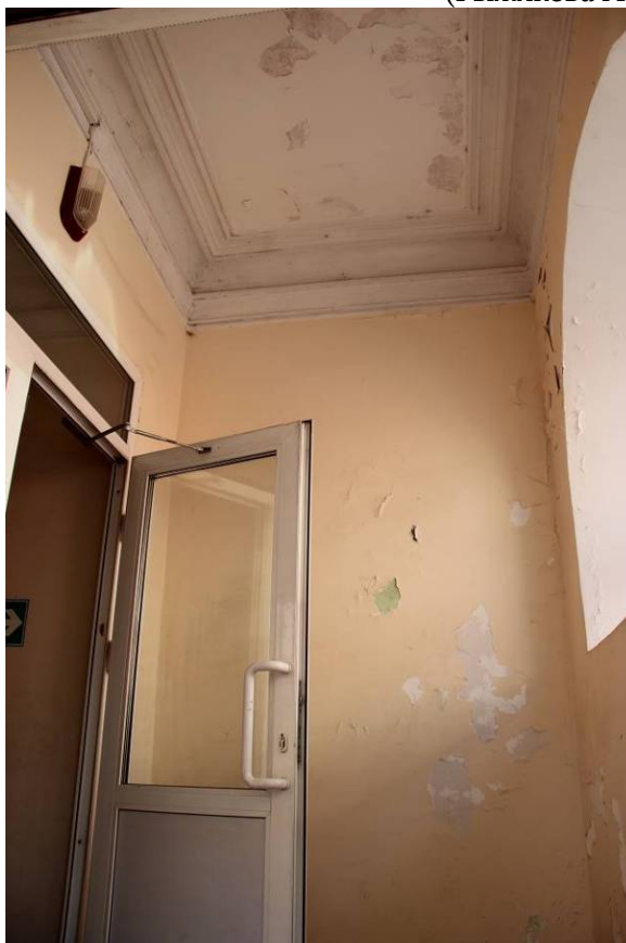
Видовая точка № 26. Общий вид входного тамбура (до ремонта) (Рыжикова А.Ю., 29.06.2015)
