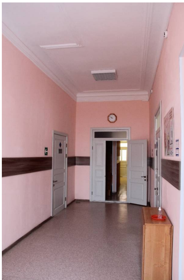
Видовая точка № 17. Общий вид коридора 2-го этажа
