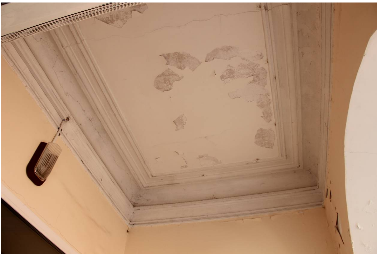
Видовая точка № 25. Профильный штукатурный декор потолка входного тамбура (Рыжикова А.Ю., 29.06.2015)
