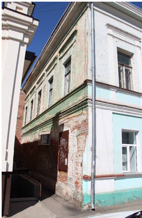
Видовая точка № 6. Боковой южный фасад здания
