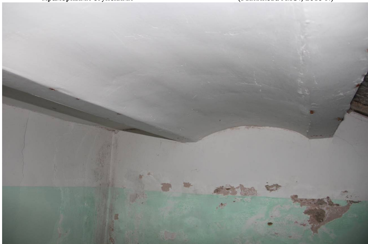
Видовая точка № 14. Кирпичные своды по металлическим балкам в конструкции лестничной площадки (Рыжикова А.Ю., 2015 г.)
