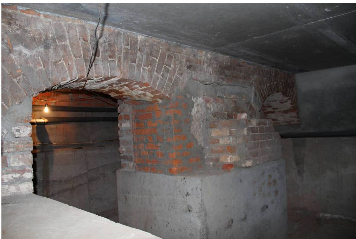
Видовая точка № 29. Арки подвальной части здания с кирпичными лучковыми перемычками (Рыжикова А.Ю., 29.06.2015)
