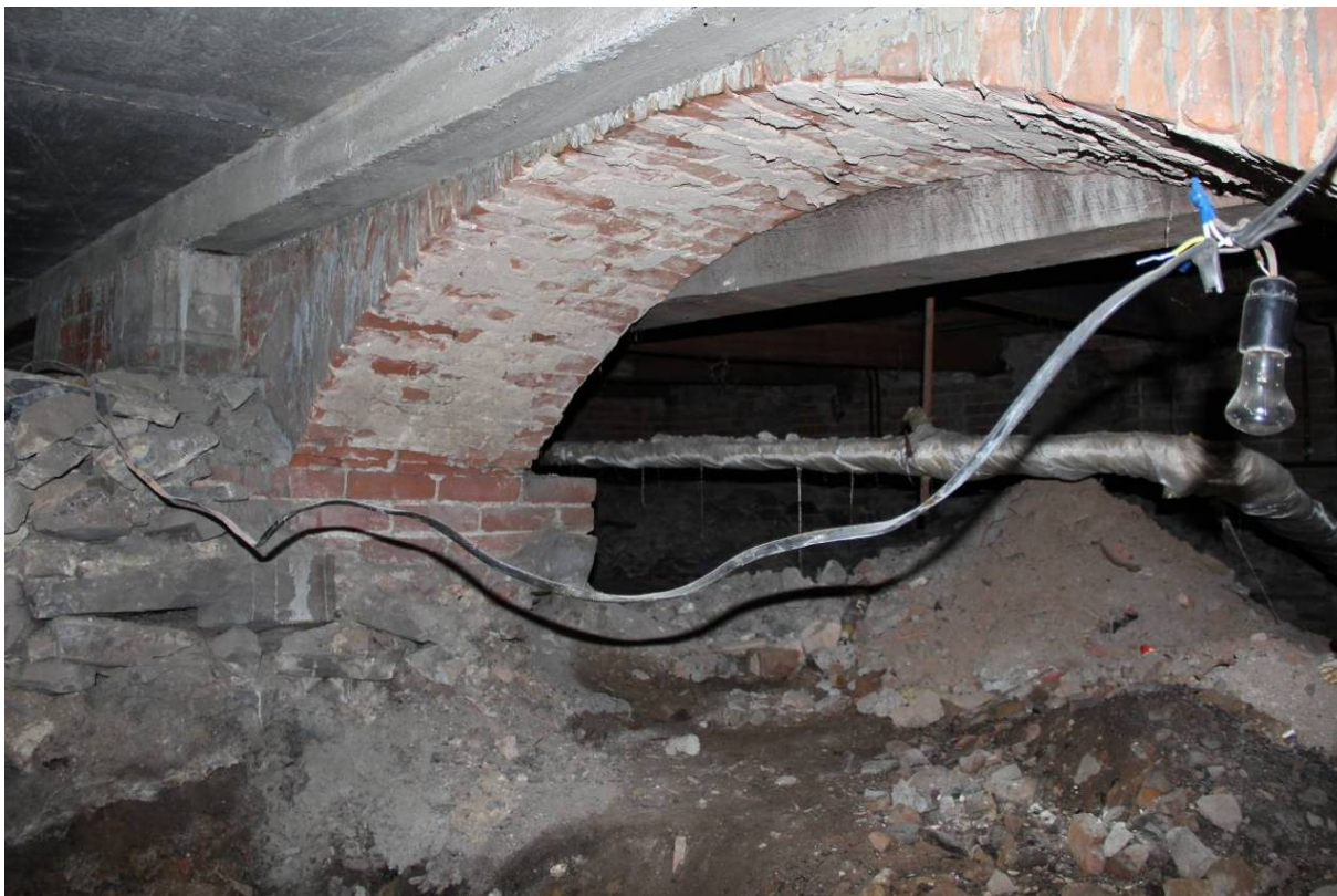
Видовая точка № 28. Арки подвальной части здания с кирпичными лучковыми перемычками (Рыжикова А.Ю., 29.06.2015)
