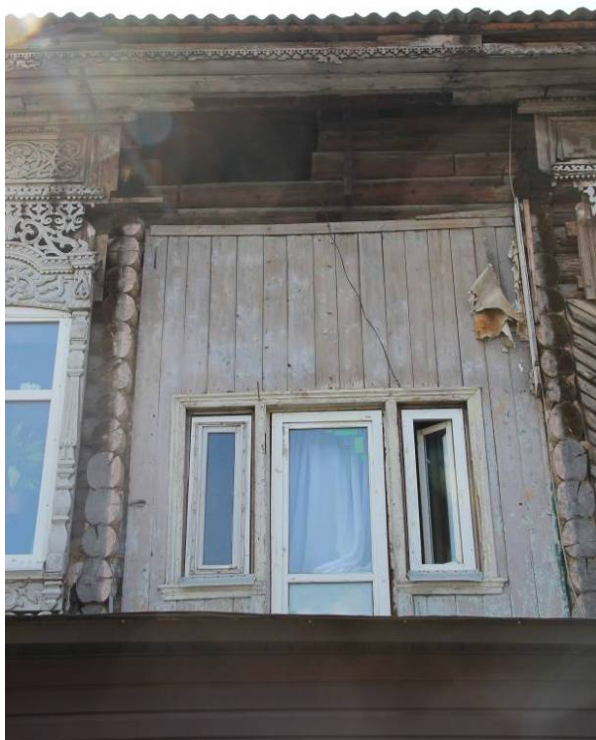
Видовая точка № 15. Фрагмент северного фасада, место примыкания утраченного веранды-эркера
