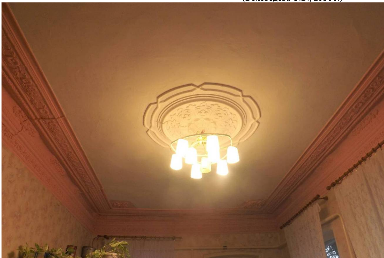
Видовая точка № 19. Фрагмент помещения с элементами лепного декора потолка (профильные потолочно-стеновые тяги с цветочным лепным декором, потолочная розетка) (Воловодова О.В., 2014 г.)
