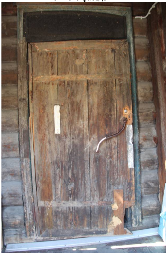
Видовая точка № 13. Деревянная дверь с фрамугой дворового фасада (Лырова Е.В., 16.05.2019 г.)
