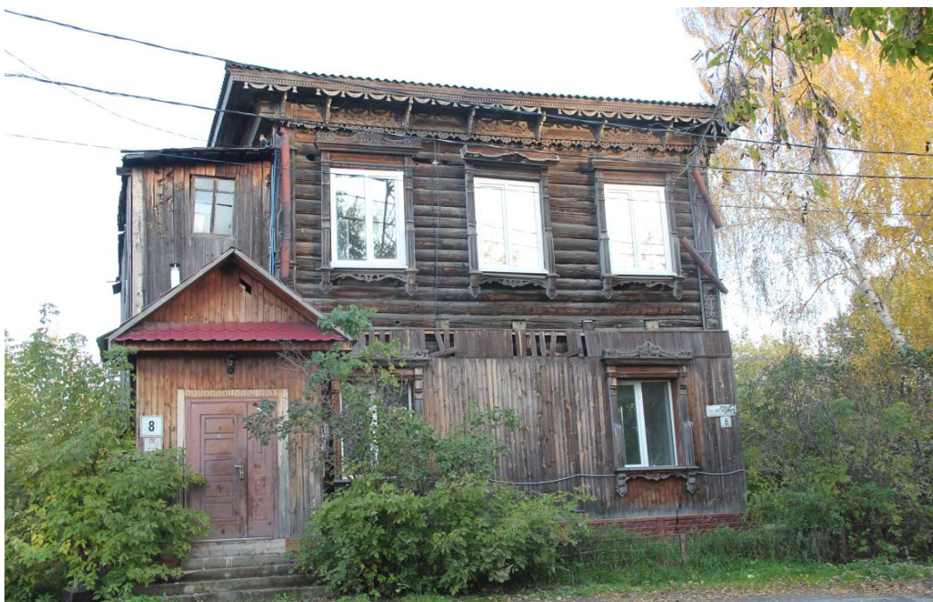
Видовая точка № 2. Главный западный фасад
