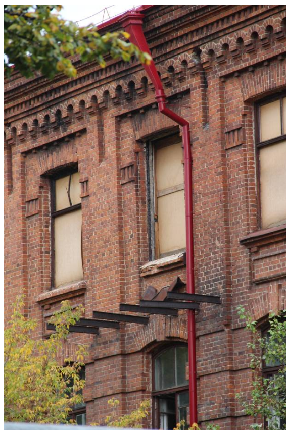
Видовая точка № 77 Местоположение и фрагменты конструкций балкона южного фасада (дата съемки: 21.09.2021)
