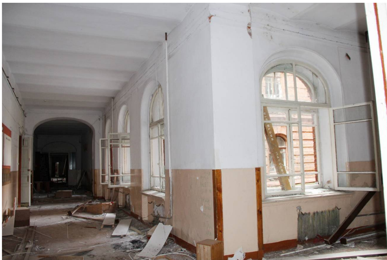
Видовая точка № 46 Коридор 1-го этажа (дата съемки: 23.09.2014)
