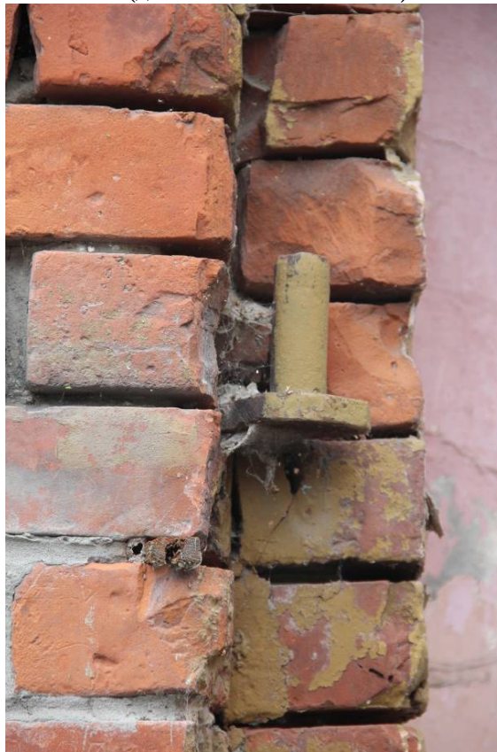
Видовая точка № 79 Металлический подстав на столбе каменной ограды (дата съемки: 21.09.2021)
