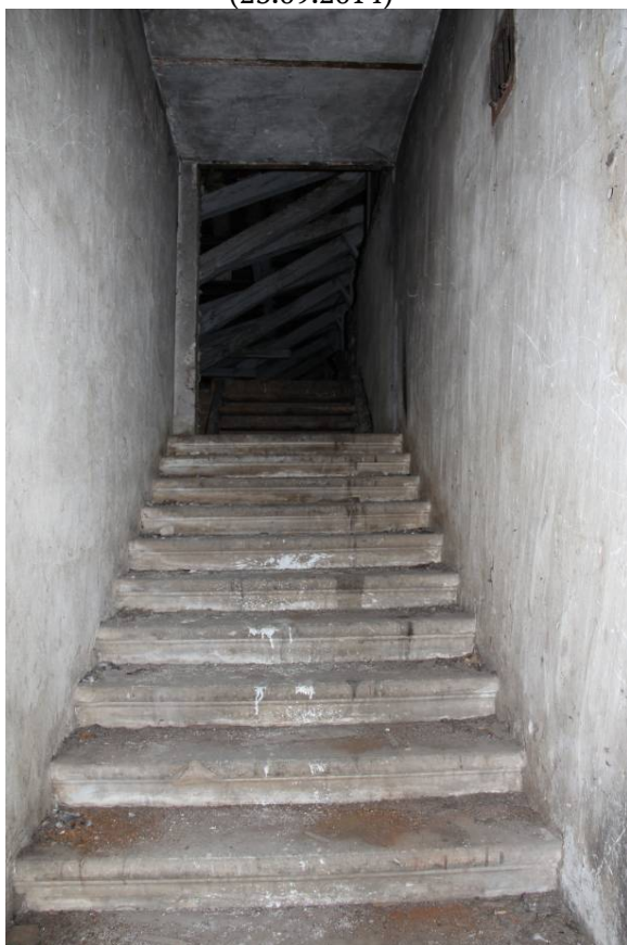
Видовая точка № 66 Лестница из песчаника на чердаке (дата съемки: 23.09.2014)
