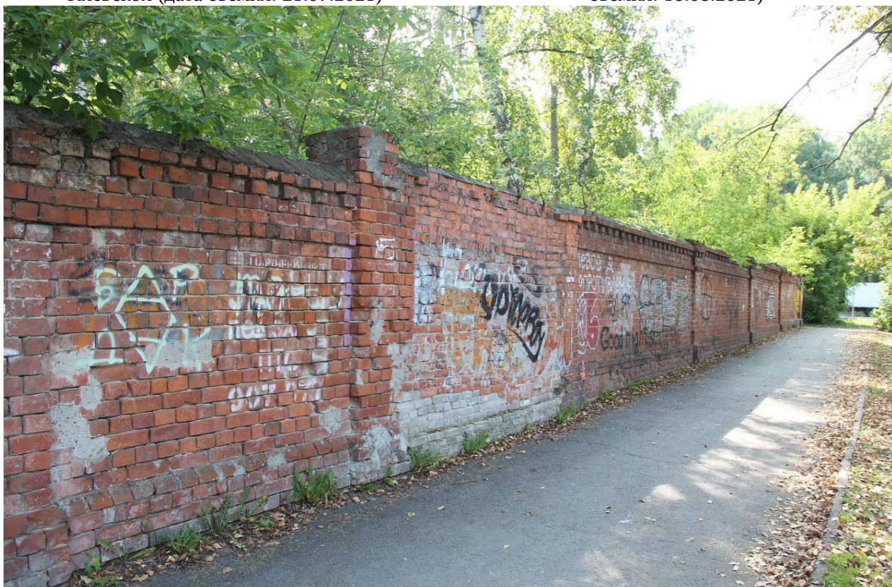
Видовая точка № 82 Фрагмент каменной ограды территории по ул. Тверской с участком, заложеным поздним кирпичом (дата съемки: 18.08.2021)
