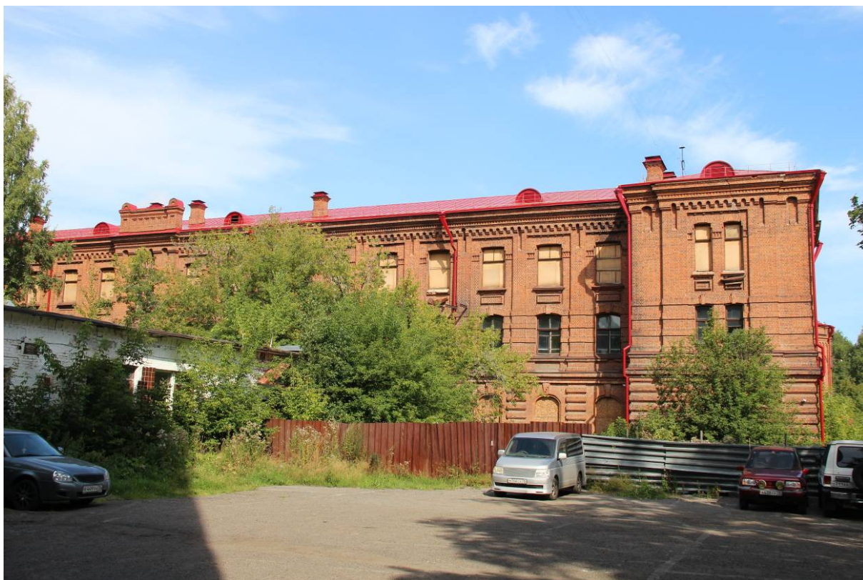
Видовая точка № 9 Общий вид южного фасада (дата съемки: 18.08.2021)
