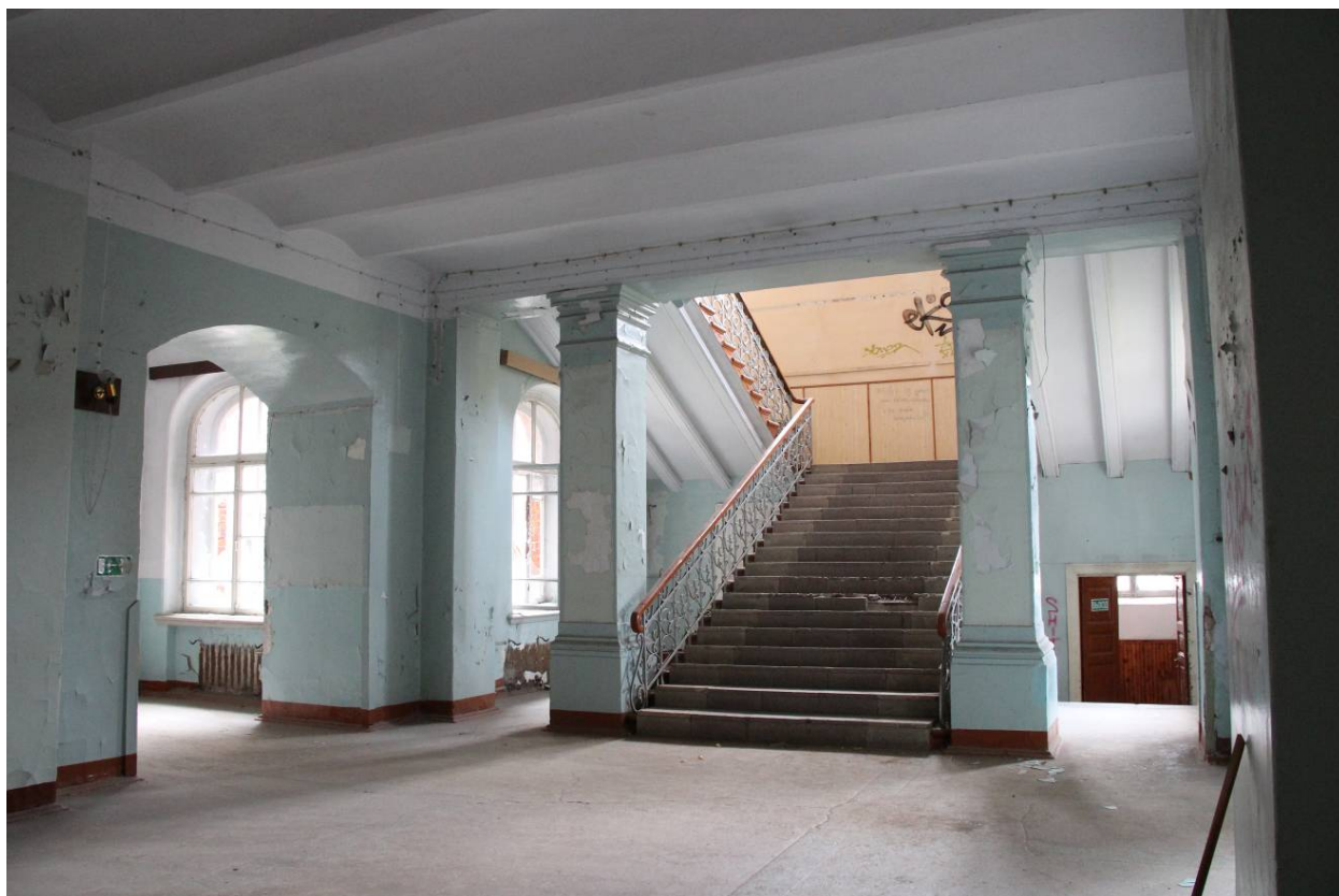
Видовая точка № 26 Парадная лестница (дата съемки: 23.09.2014)
