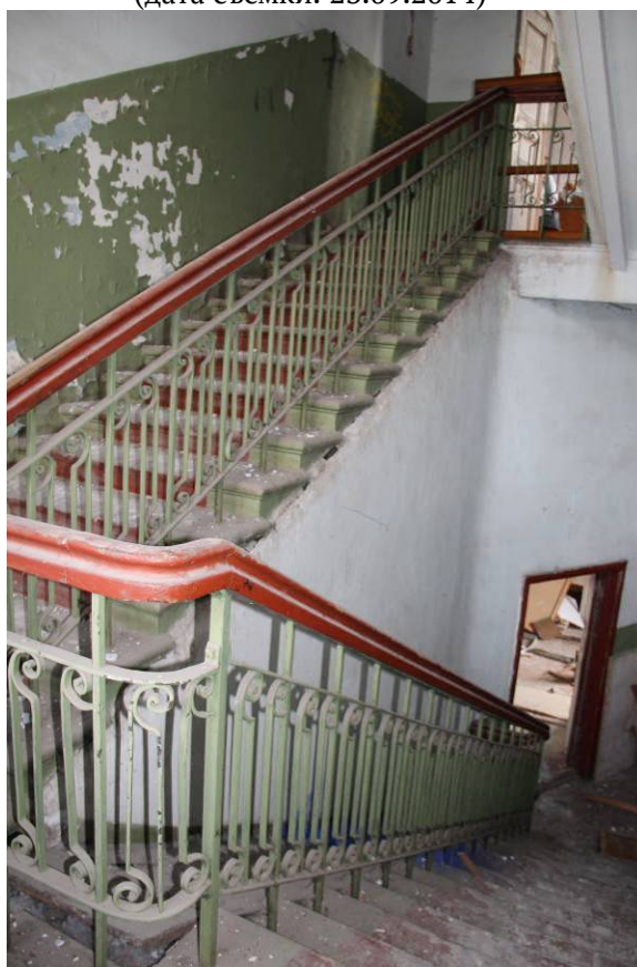
Видовая точка № 62 Лестница ризалита северо-западного дворового объема (дата съемки: 23.09.2014)
