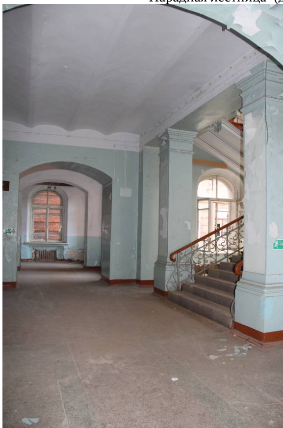
Видовая точка № 27 Вид на боковой коридор 1-го этажа (дата съемки: 23.09.2014)
