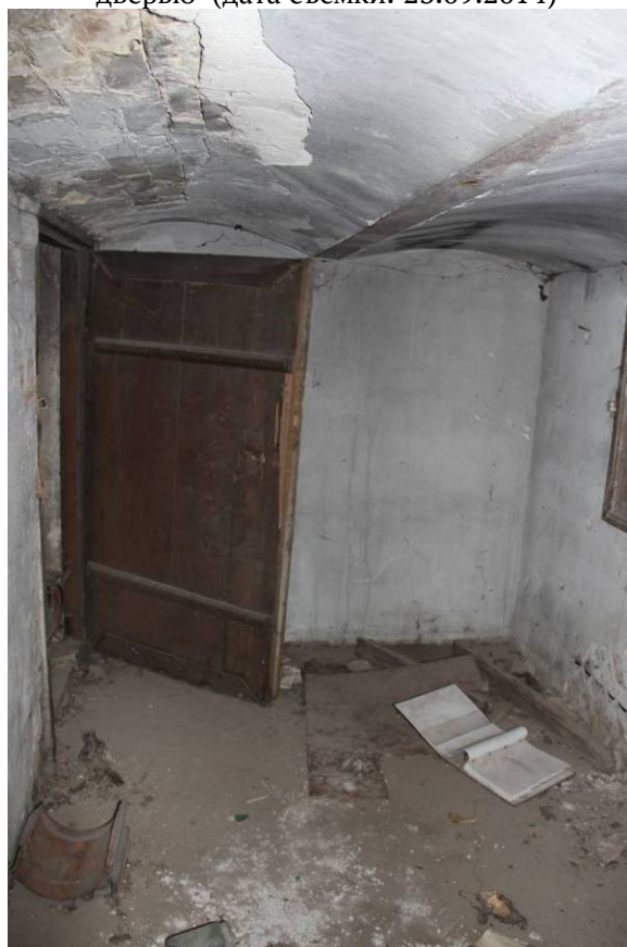
Видовая точка № 67 Выход на чердак, кирпичный свод перекрытия (23.09.2014)
