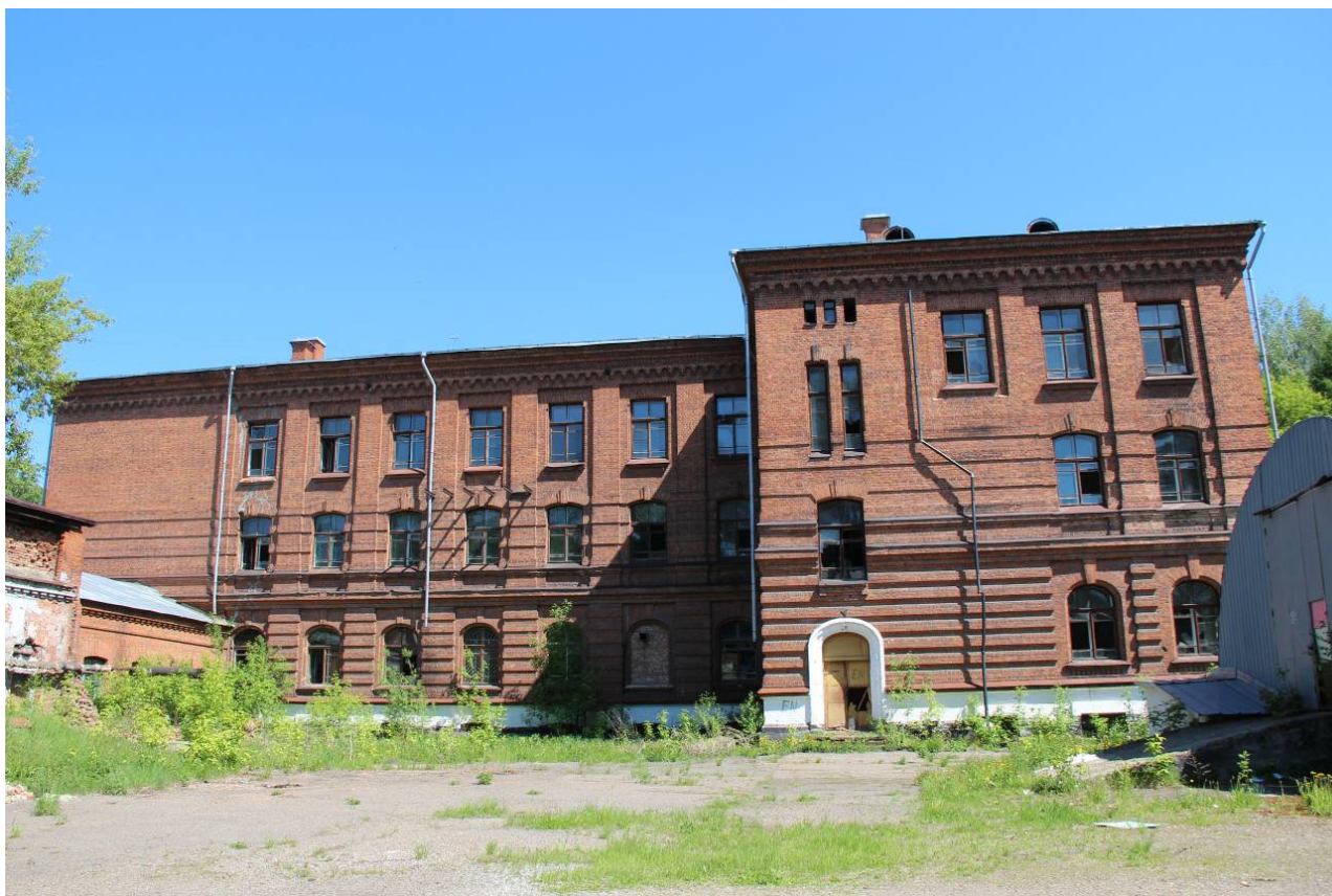
Видовая точка № 14 Торцевой фасад южного крыла здания (дата съемки: 23.09.2014)
