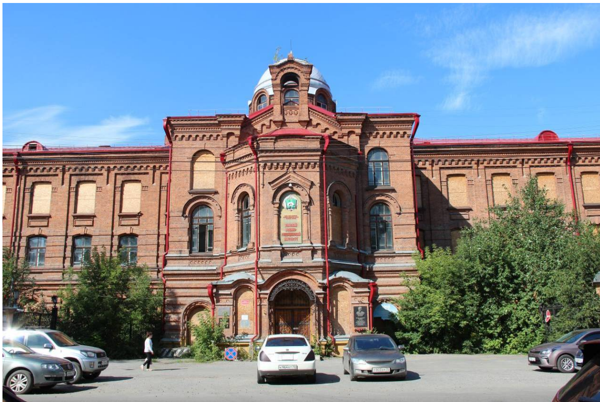
Видовая точка № 3 Фрагмент главного восточного фасада. Центральный ризалит с апсидой домово́й церкви и парадным входом (дата съемки: 18.08.2021)
