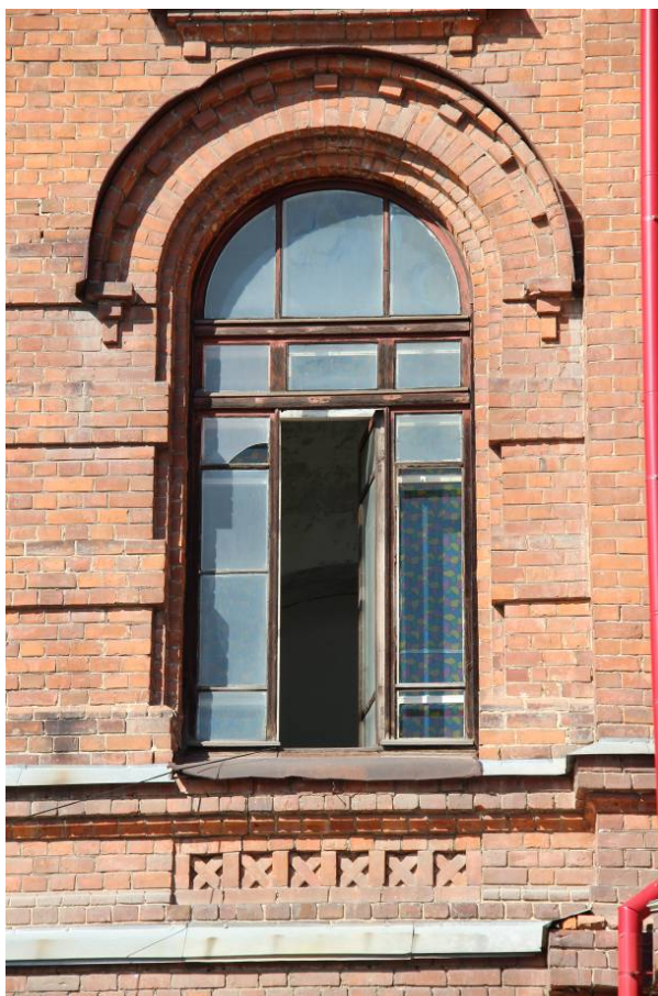
Видовая точка № 6 Окно 2-го этажа центральной части главного фасада (дата съемки: 18.08.2021)
