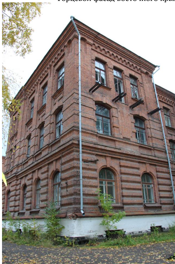
Видовая точка № 21 Северо-восточный угол здания (дата съемки: 23.09.2014)
