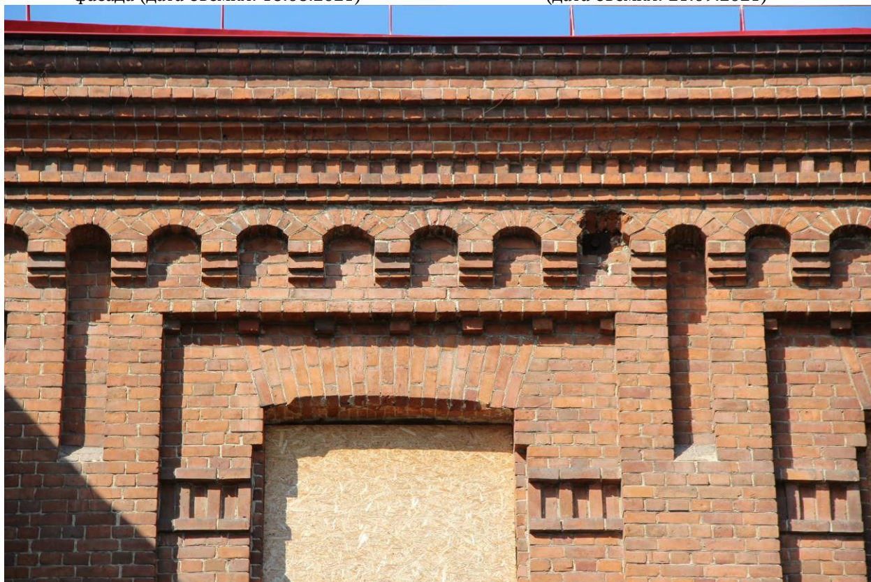
Видовая точка № 8 Фрагмент карниза главного восточного фасада (дата съемки: 18.08.2021)
