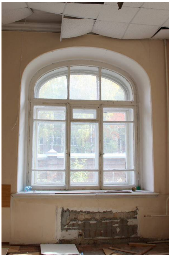
Видовая точка № 57 Окно 1-го этажа с деревянными рамами и скобяной фурнитурой (дата съемки: 23.09.2014)
