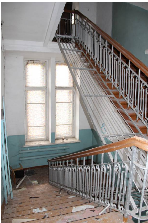
Видовая точка № 64 Лестница северо-западного дворового объема (23.09.2014)
