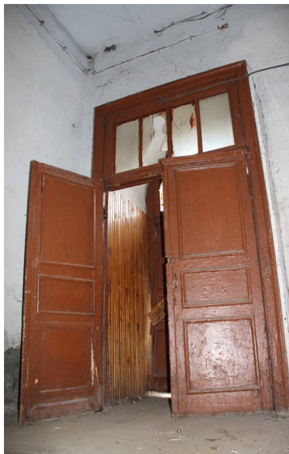
Видовая точка № 24 Вход южного фасада с тамбуром в толщине стены (дата съемки: 23.09.2014)
