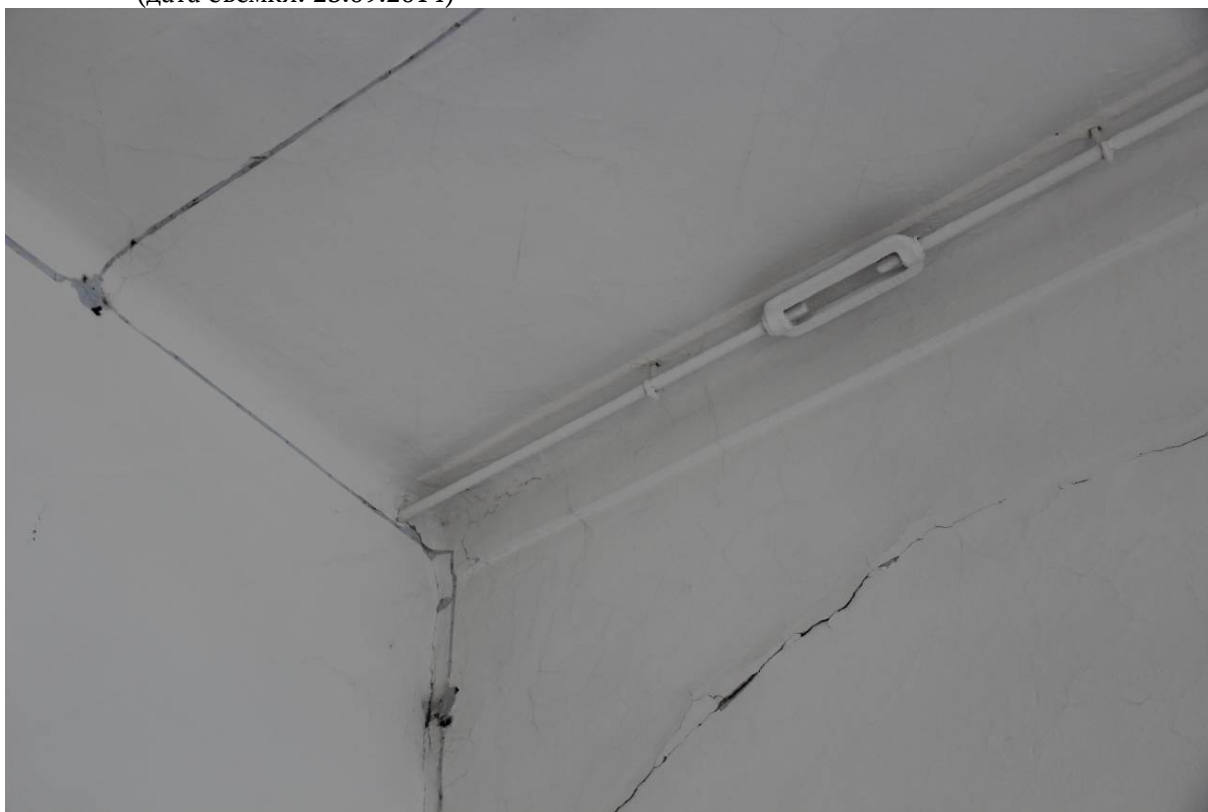
Видовая точка № 59 Металлические связи в помещении 3-го этажа (дата съемки: 23.09.2014)
