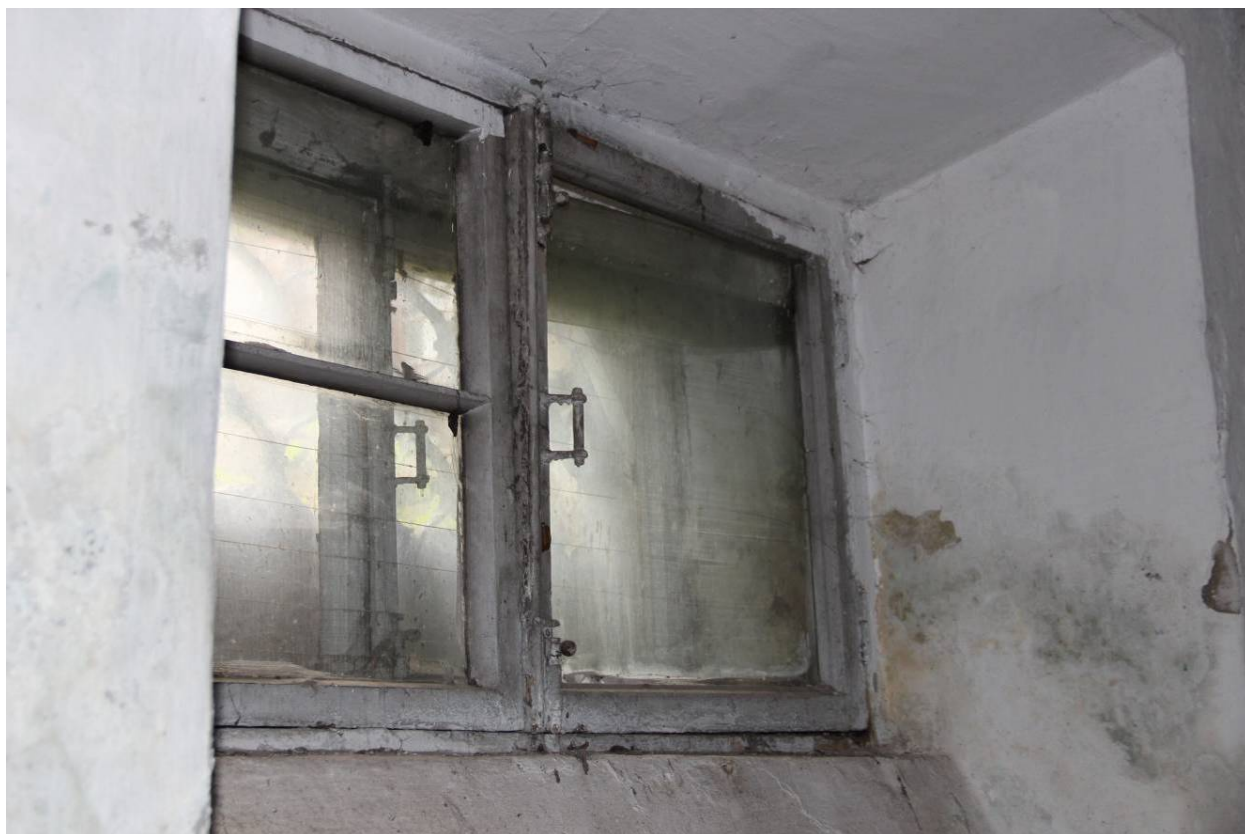
Видовая точка № 74 Окно подвала с деревянным заполнением и металлической фурнитурой (дата съемки: 23.09.2014)
