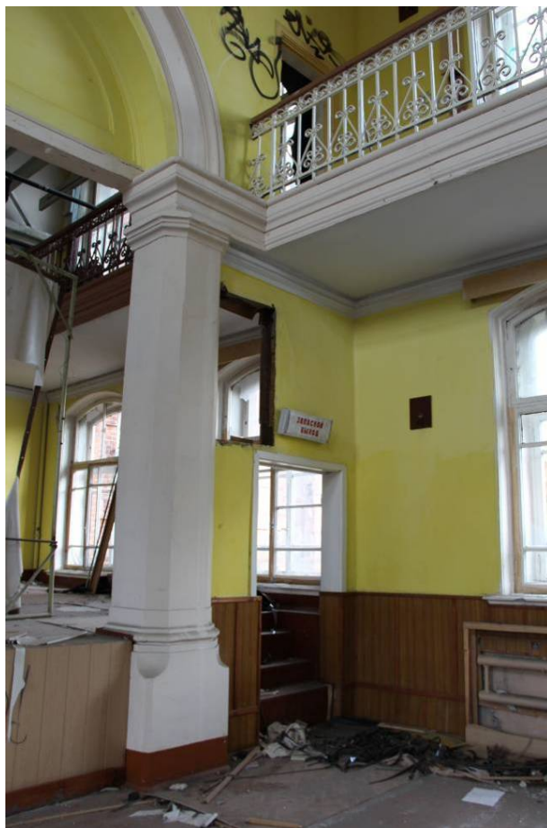
Видовая точка № 42 Парадный зал 2-го этажа (дата съемки: 23.09.2014)
