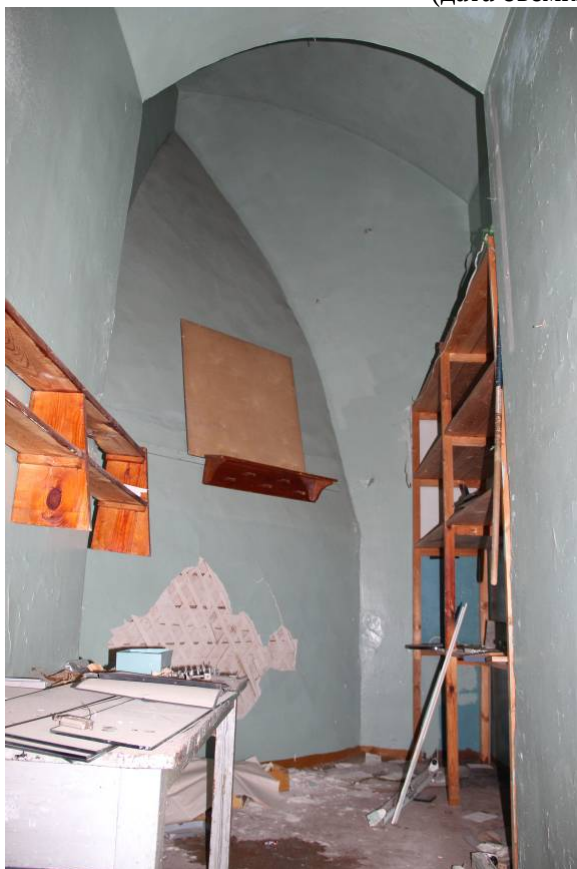
Видовая точка № 38 Кирпичный свод в угловой части купольного перекрытия церкви (3 этаж) (дата съёмки: 23.09.2014)
