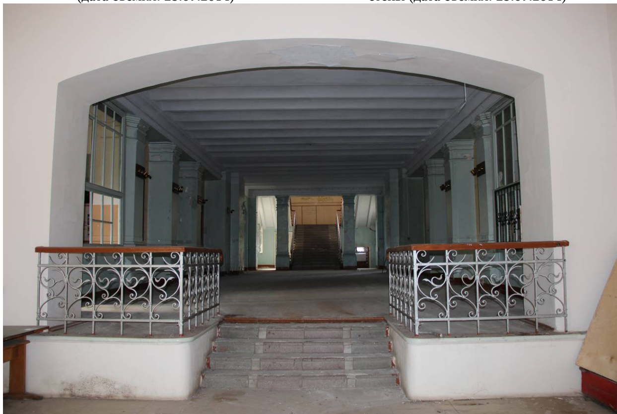
Видовая точка № 25 Помещение вестибюля 1-го этажа (парадный вход) (дата съемки: 23.09.2014)
