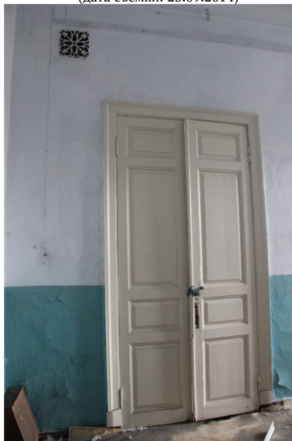
Видовая точка № 56 Деревянная филенчатая дверь помещения 3-го этажа (дата съемки: 23.09.2014)
