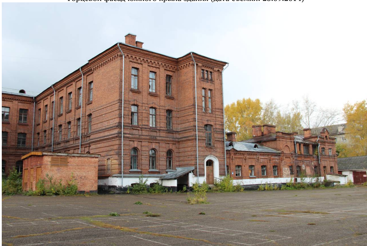
Видовая точка № 15 Фрагмент дворового северного фасада (дата съемки: 23.09.2014)
