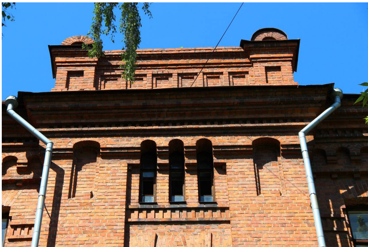
Видовая точка № 12 Фрагмент центрального ризалита южного фасада с аттиком (дата съемки: 05.06.2015)
