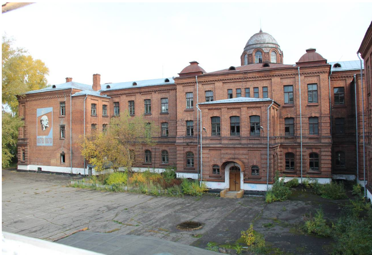
Видовая точка № 18 Фрагмент дворового западного фасада (дата съемки: 23.09.2014)
