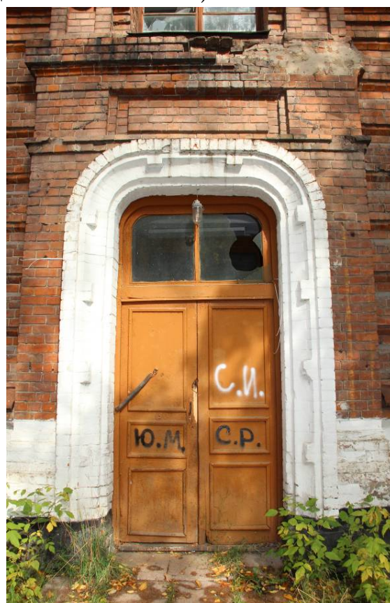
Видовая точка № 11 Дверной проем южного фасада (дата съемки: 23.09.2014)
