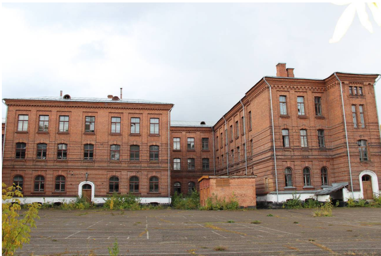
Видовая точка № 16 Фрагмент дворового северного фасада (дата съемки: 23.09.2014)
