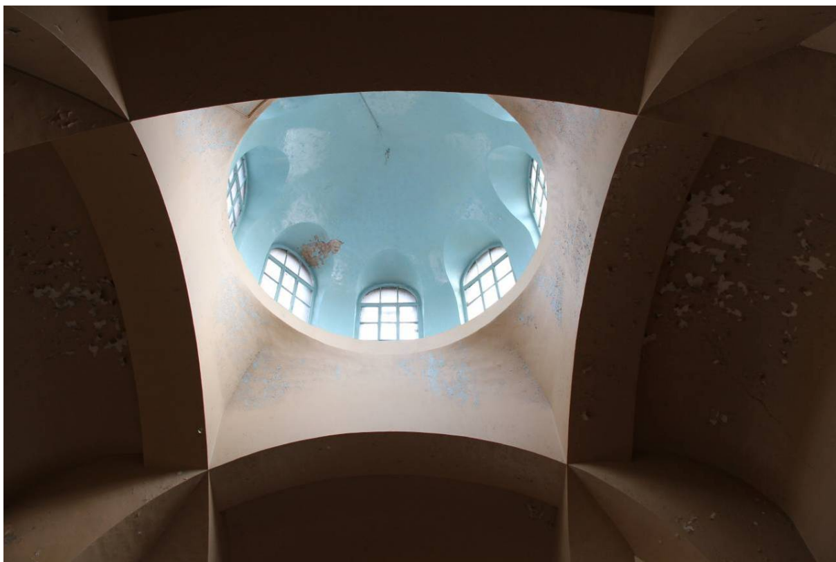
Видовая точка № 31 Конструкции свода домово́й церкви, световой барабан (дата съёмки: 23.09.2014)
