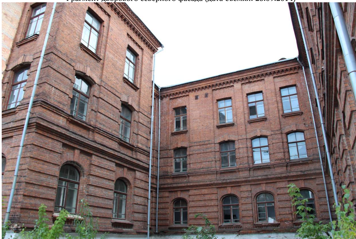
Видовая точка № 17 Фрагмент дворового северного фасада (дата съемки: 23.09.2014)
