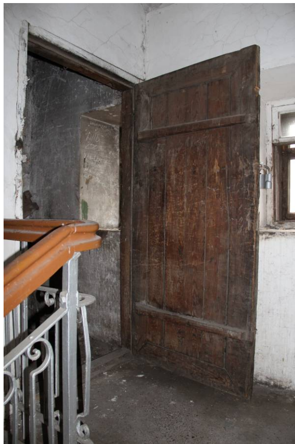
Видовая точка № 65 Вход на чердак с деревянной по шпонках дверью (дата съемки: 23.09.2014)
