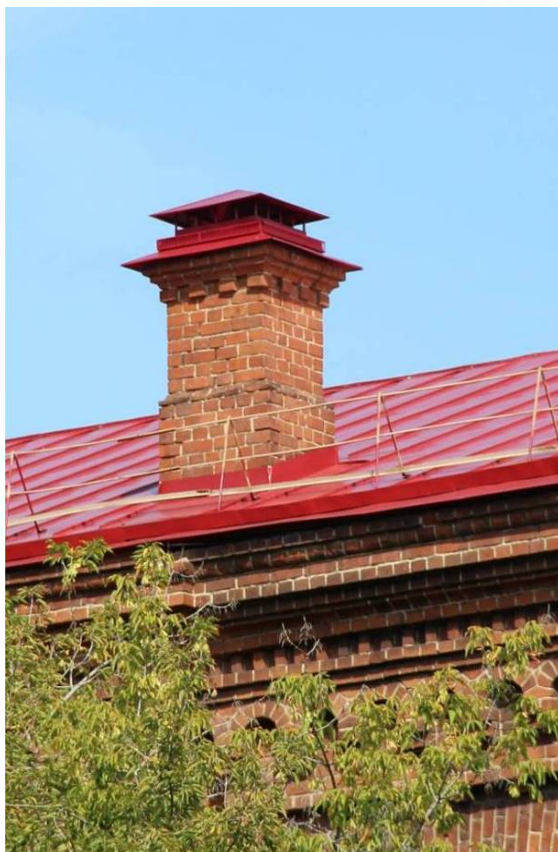
Видовая точка № 76 Печная труба (дата съемки: 18.08.2021)
