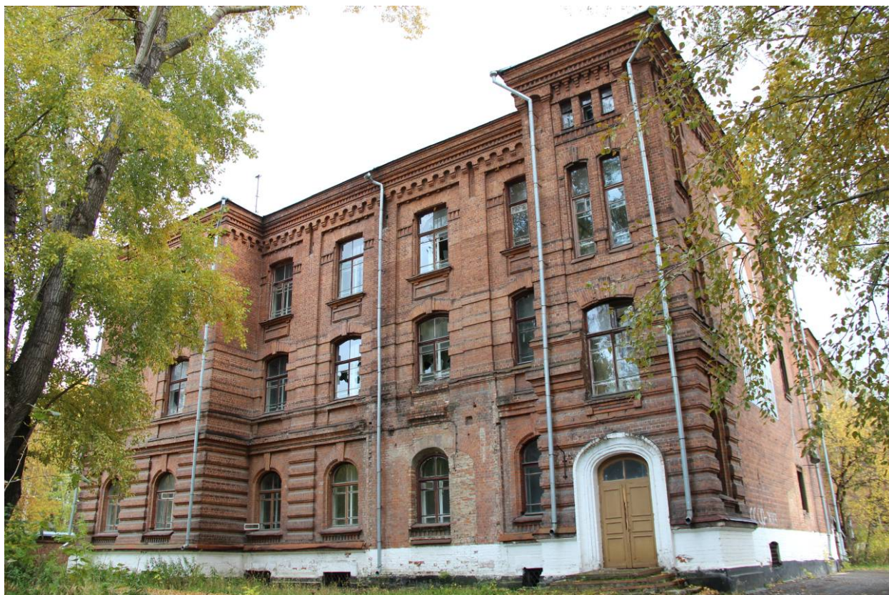
Видовая точка № 20 Торцевой фасад восточного крыла здания (дата съемки: 23.09.2014)
