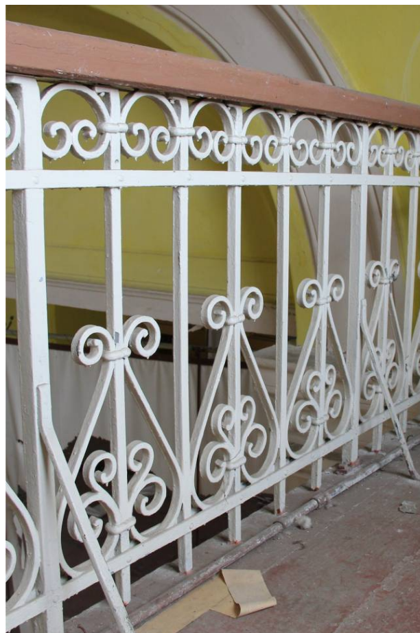
Видовая точка № 43 Фрагмент решетки ограждения балкона парадного зала (3 этаж) (дата съемки: 23.09.2014)
