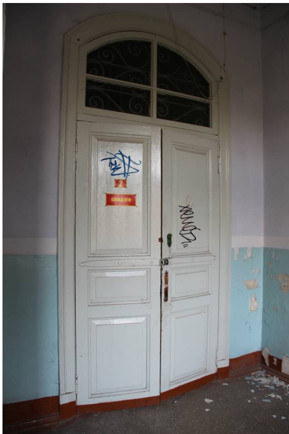
Видовая точка № 53 Дверь с остекленной фрамугой в помещение 1-го этажа (дата съемки: 23.09.2014)
