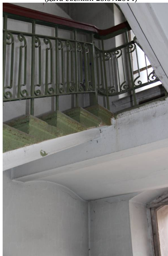
Видовая точка № 63 Кирпичный свод в конструкции лестничной площадки (дата съемки: 23.09.2014)
