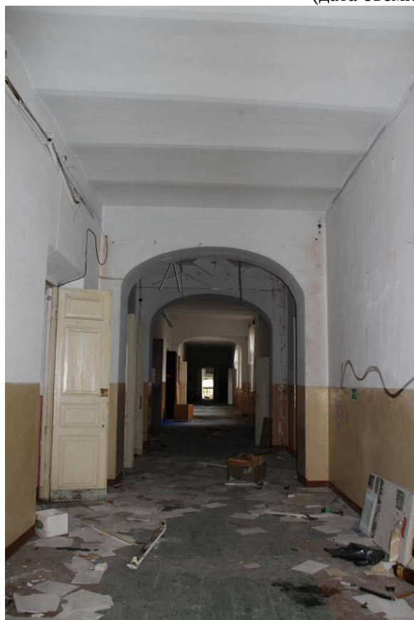
Видовая точка № 51 Общий вид коридора 2-го этажа (дата съемки: 23.09.2014)
