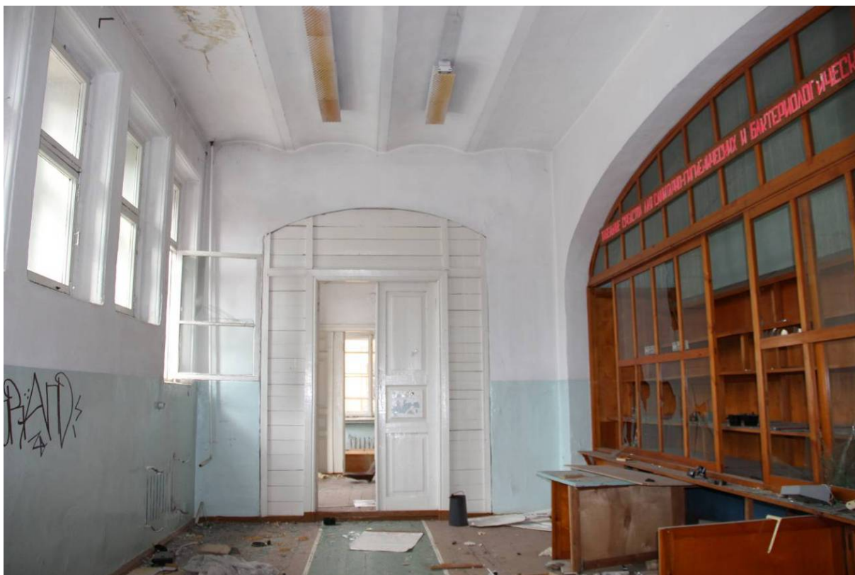
Видовая точка № 37 Помещение 3-го этажа, с правой стороны арка выхода на хоры домово́й церкви (дата съёмки: 23.09.2014)
