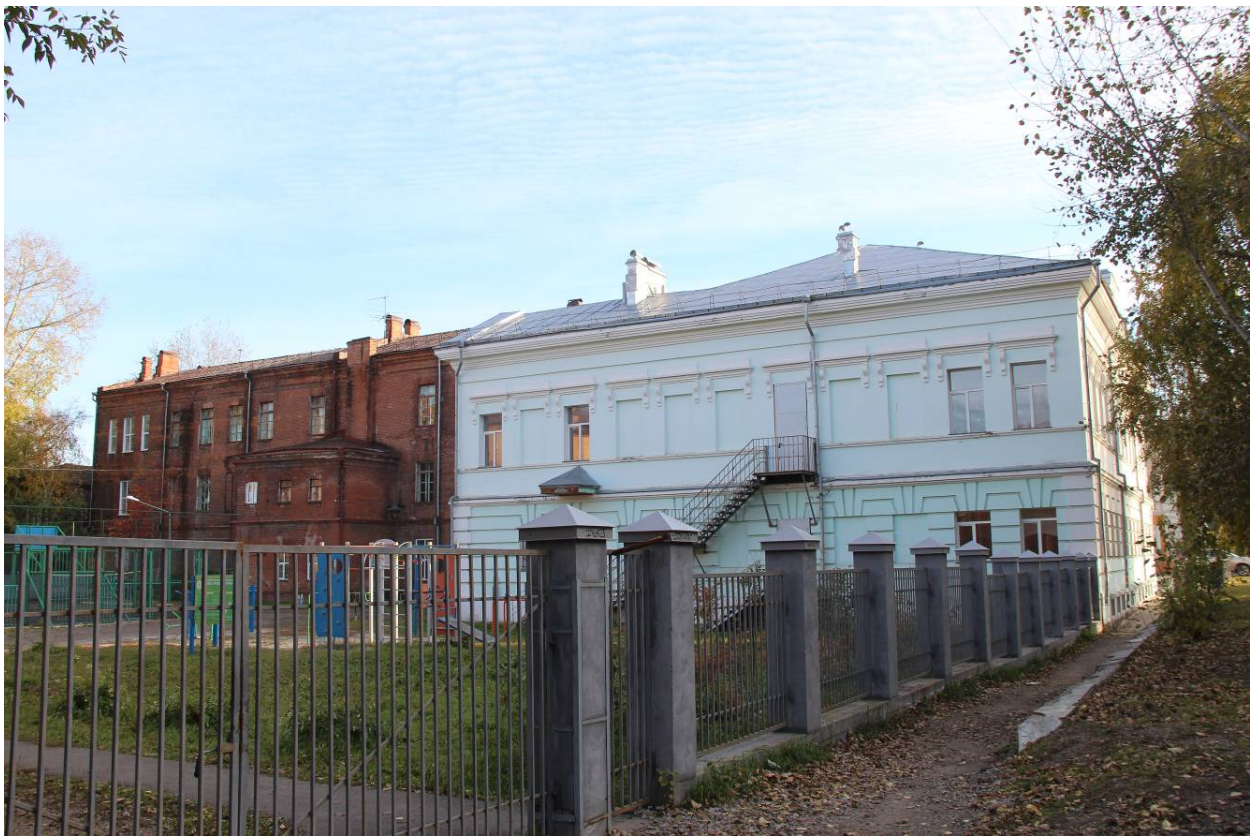
Видовая точка № 5 Северный фасад здания
