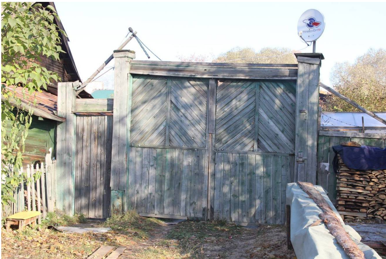
Видовая точка № 6. Деревянные ворота, вид с пер. Красного Пожарника
