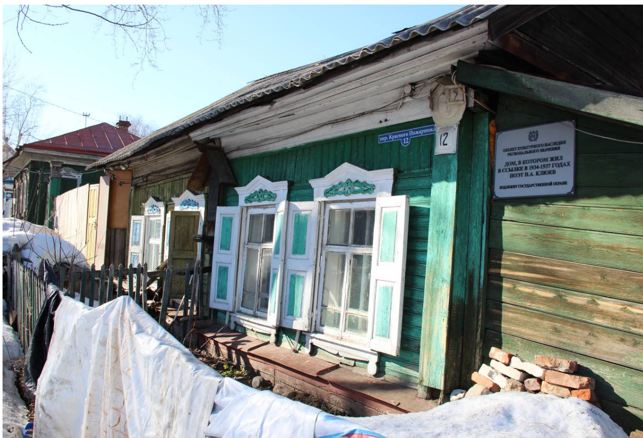
Видовая точка № 7. Главный южный фасад (Рыжикова А.Ю., 06.04.2015 г.)
