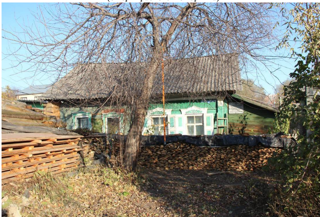
Видовая точка № 2. Главный южный фасад здания
