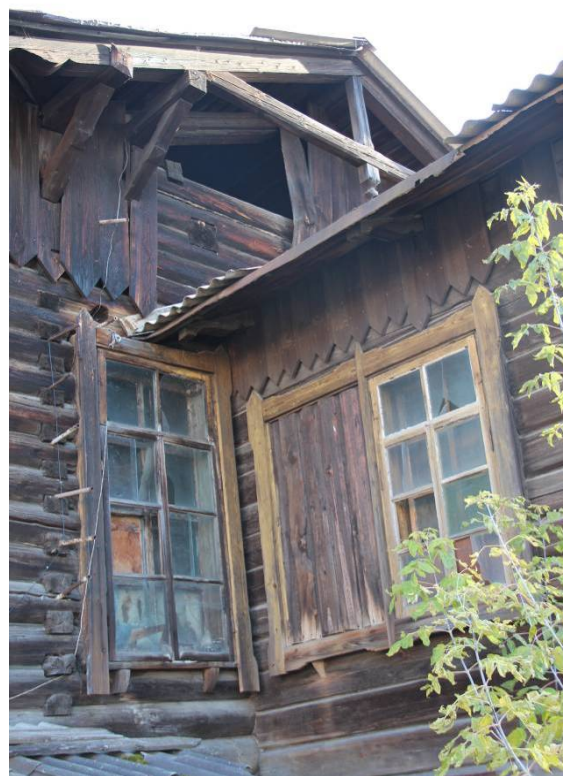
Видовая точка № 5. А. Иванова ул., 2а. Фрагмент центральной части главного фасада
