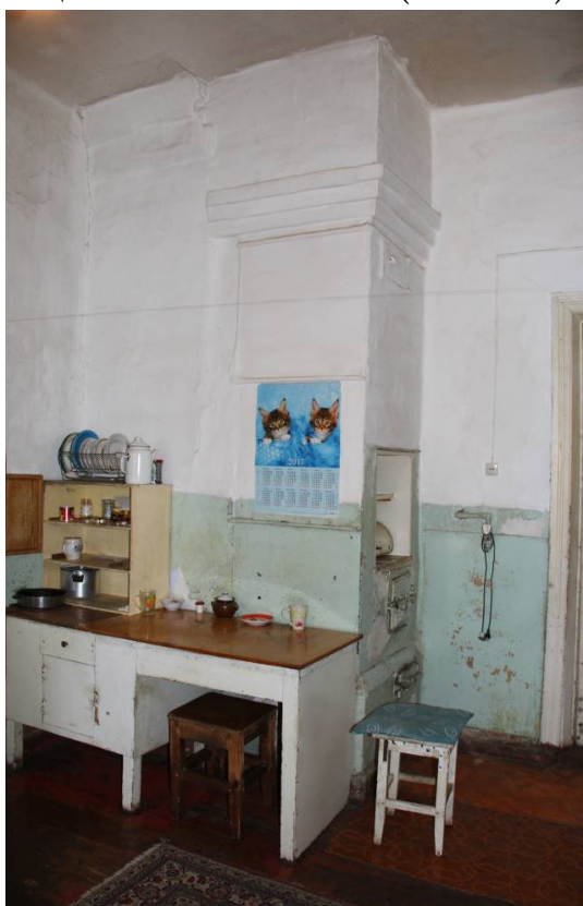
Видовая точка № 32. А. Иванова ул., 2/1. Печь в квартире 2-го этажа (28.04.2016)
