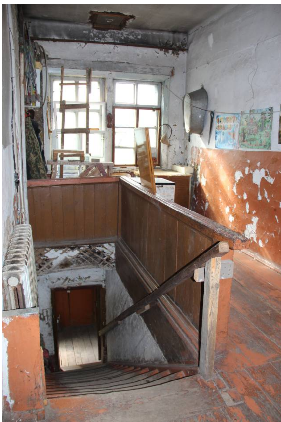
Видовая точка № 30. А. Иванова ул., 2/1. Общий вид помещения лестничного блока (28.04.2016)
