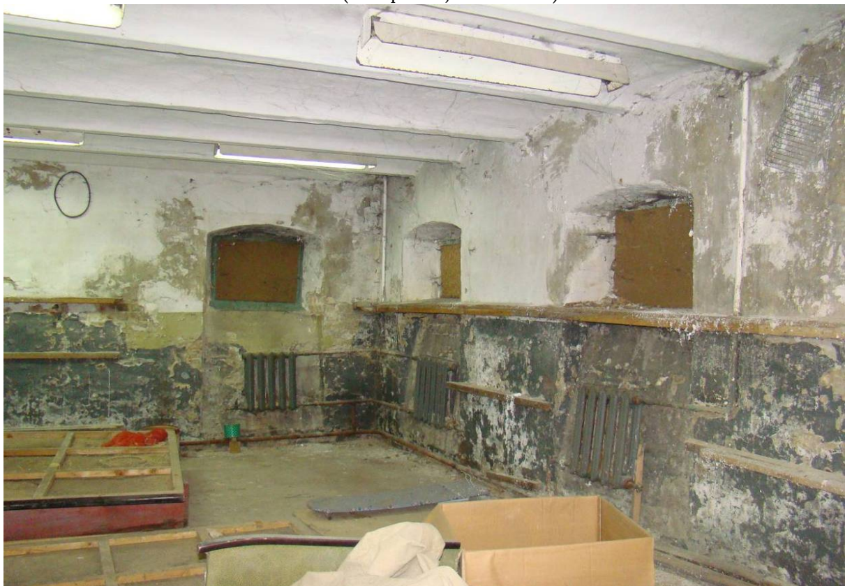
Видовая точка № 35 А. Иванова ул., 2/1. Общий вид помещения подвала с перекрытием из кирпичных сводов (Вакер И.С., 11.12. 2012)
