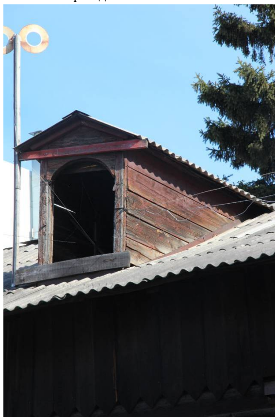
Видовая точка № 12. А. Иванова ул., 2а. Слуховое окно со стороны западного фасада
