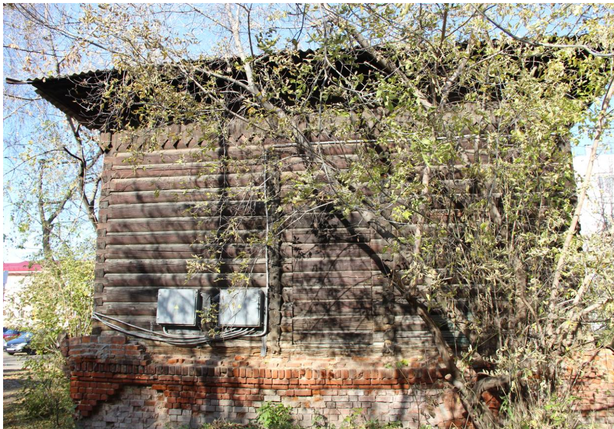
Видовая точка № 10. А. Иванова ул., 2а. Южный фасад
