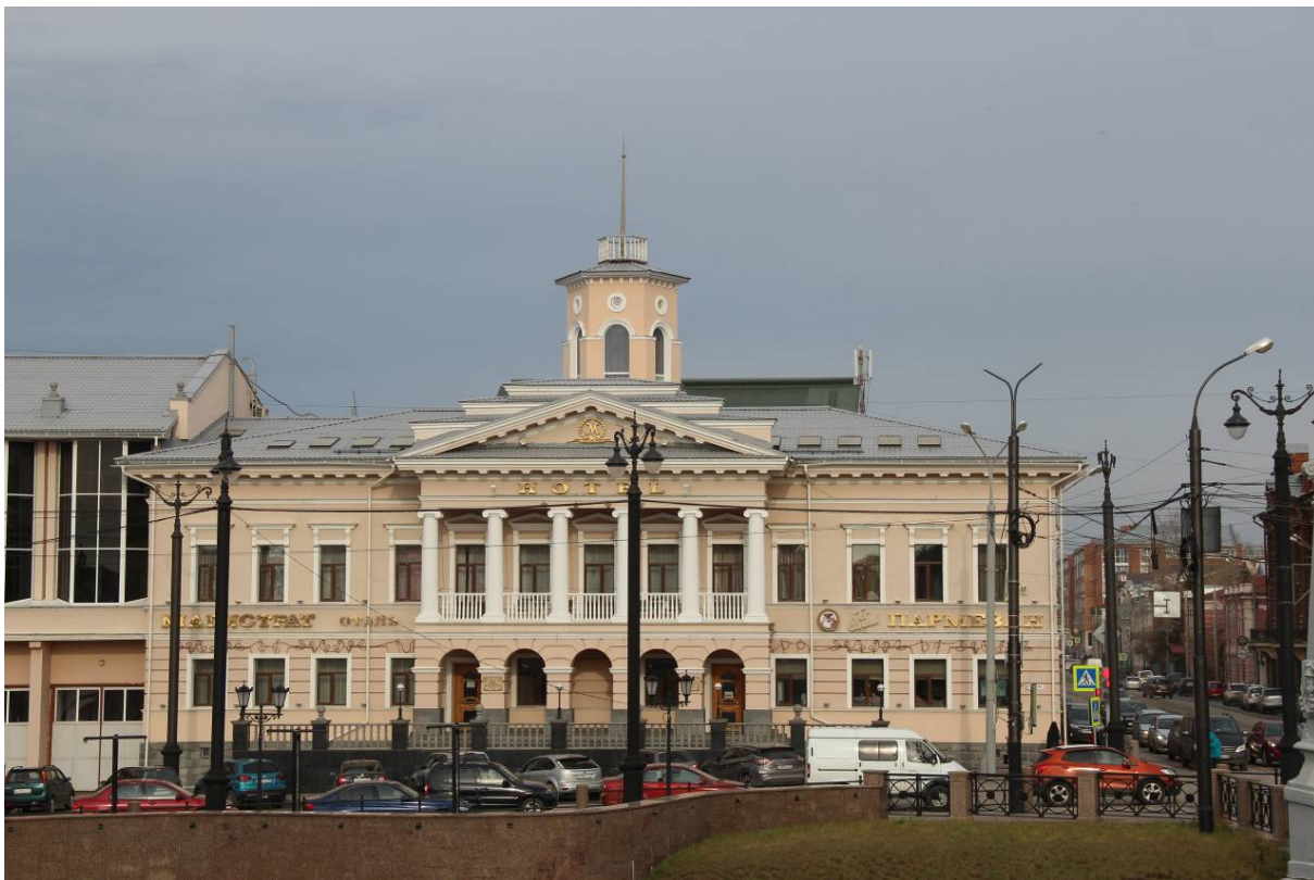
Видовая точка № 5. Главный южный фасад здания
