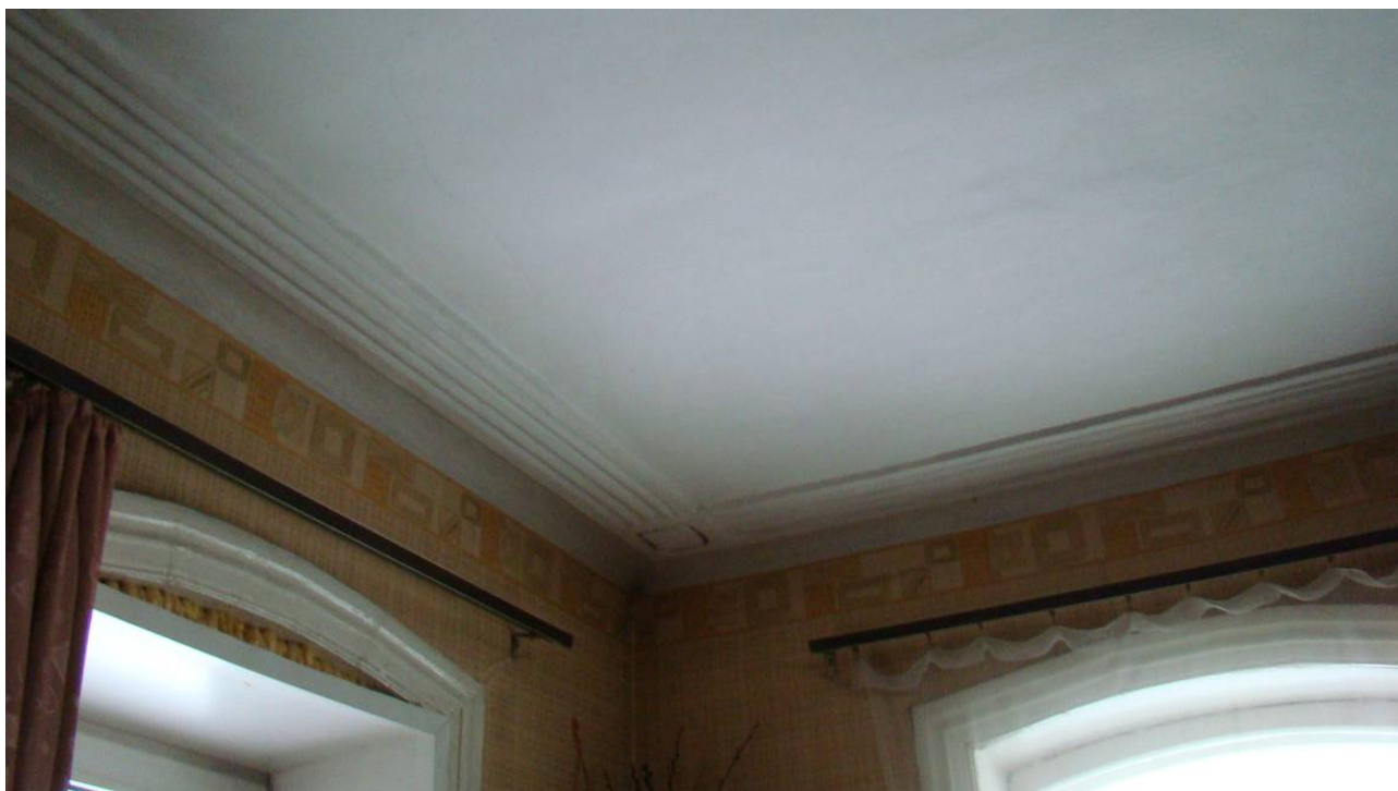
Видовая точка № 19. Профильные штукатурные потолочные тяги, деревянные оконные коробки с профильным обрамлением проема (Вакер И.С., 27.11.2014 г.)
