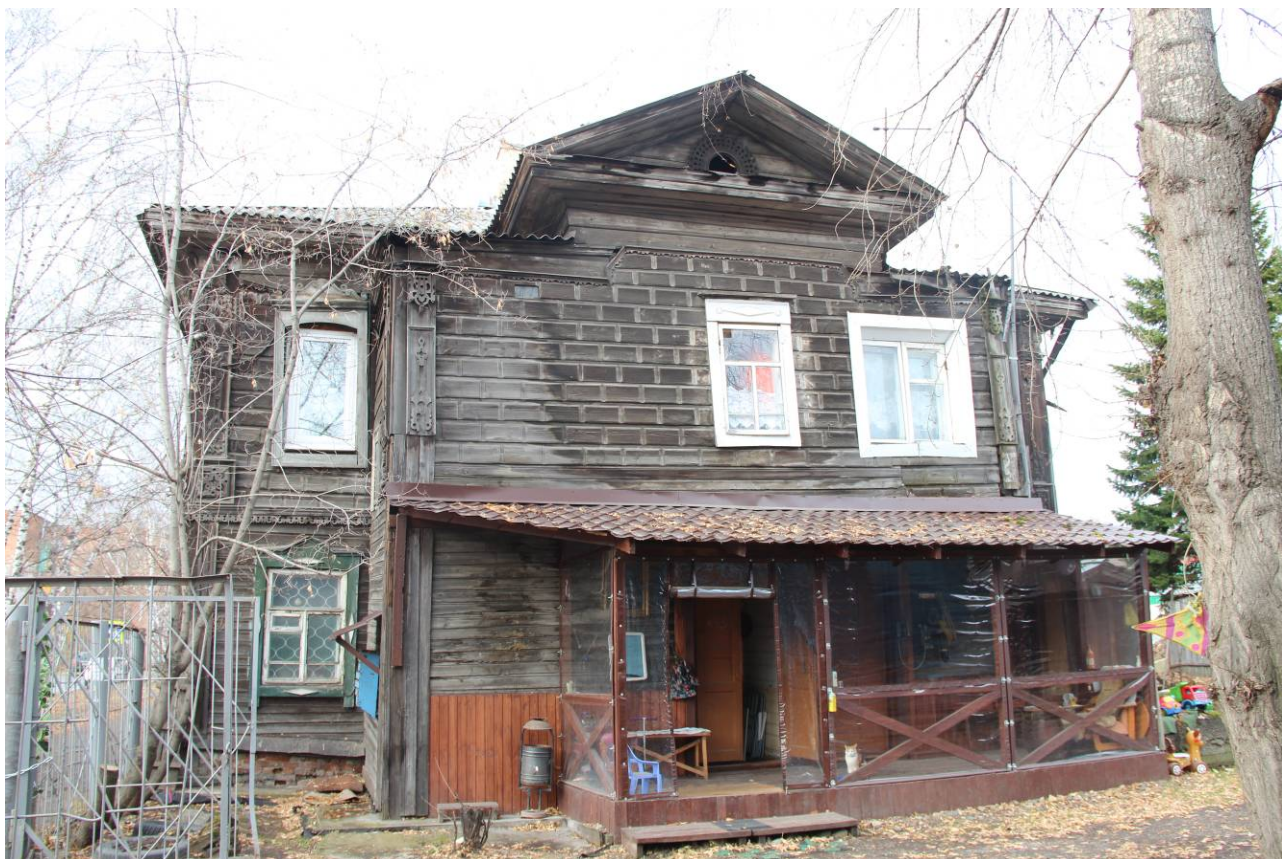
Видовая точка № 3. Боковой восточный фасад дома
