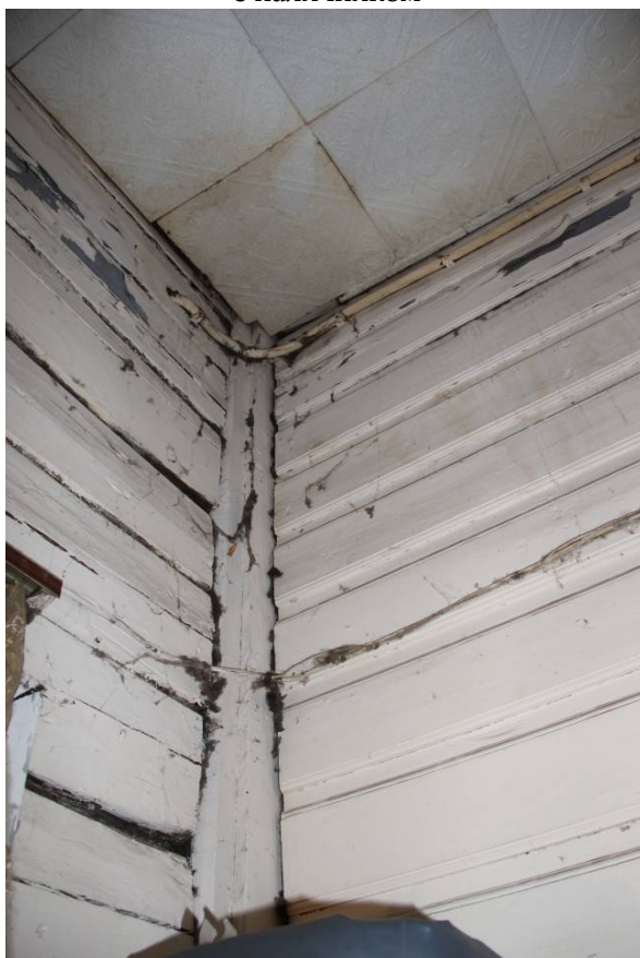
Видовая точка № 13. Стена пристройки из окантованных брёвен, профильная обшивка стены дома
