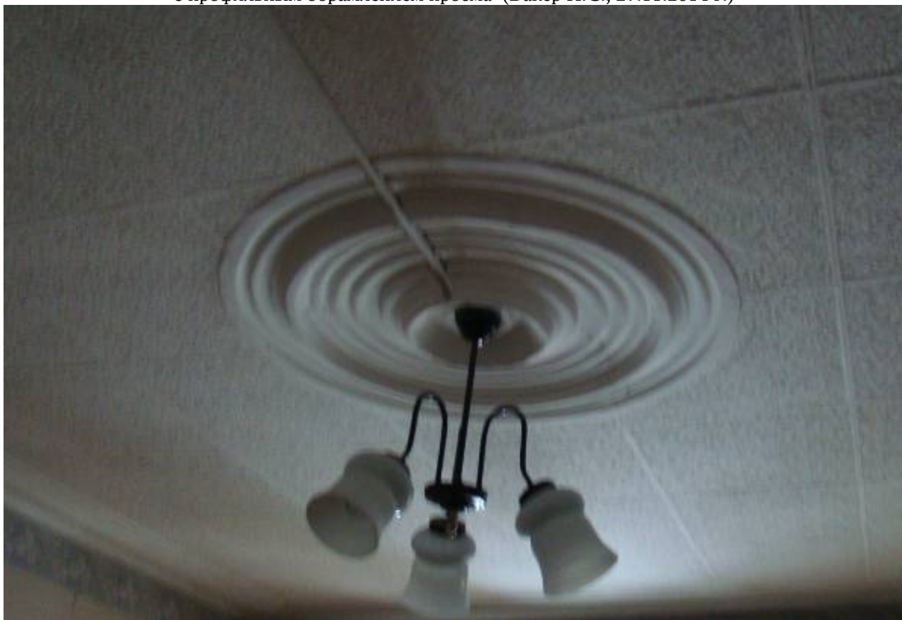
Видовая точка № 20. Профильная штукатурная потолочная розетка (Вакер И.С., 27.11.2014 г.)
