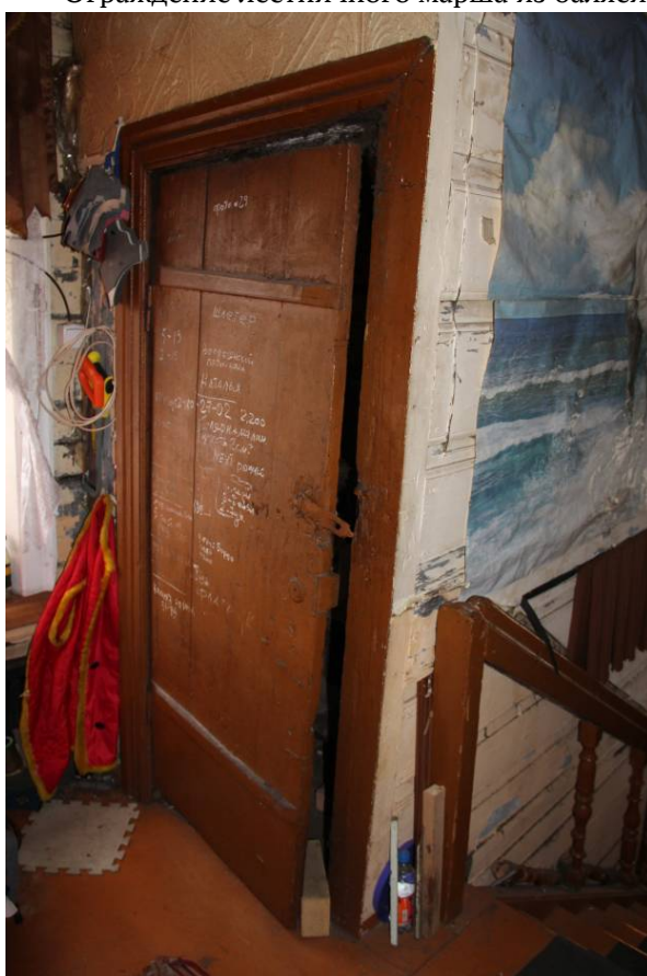
Видовая точка № 18. Деревянная дверь выхода на чердак
