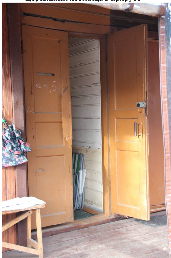
Видовая точка № 17. Дверной проем основного входа на 2-й этаж
