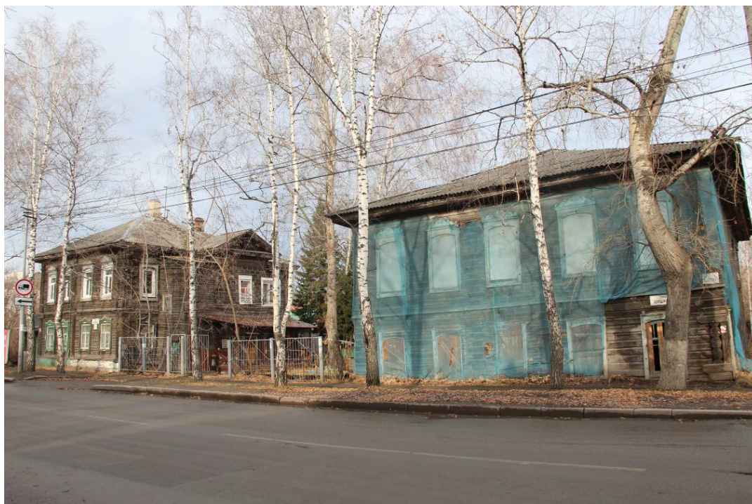
Видовая точка № 2. Общий вид здания в строчке застройки ул. Шишкова
