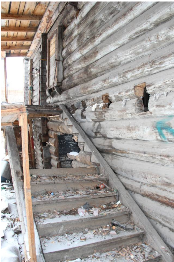
Видовая точка № 13. Лестница в дощатой пристройке к дворовому фасаду (снесена), 21.11.2014 г.
