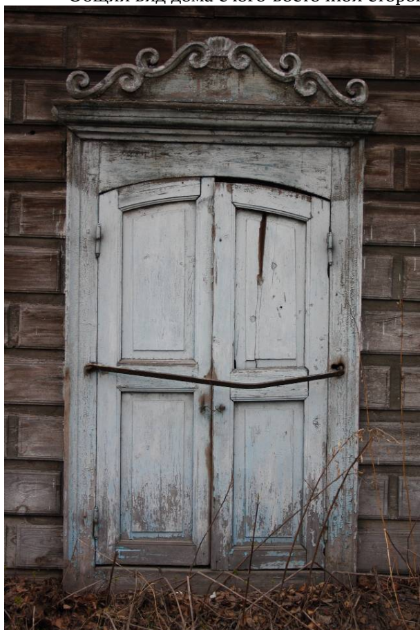
Видовая точка № 18. Наличник окна первого этажа со ставнями (Яблонская М.А., дата съемки: 2011 г.)
