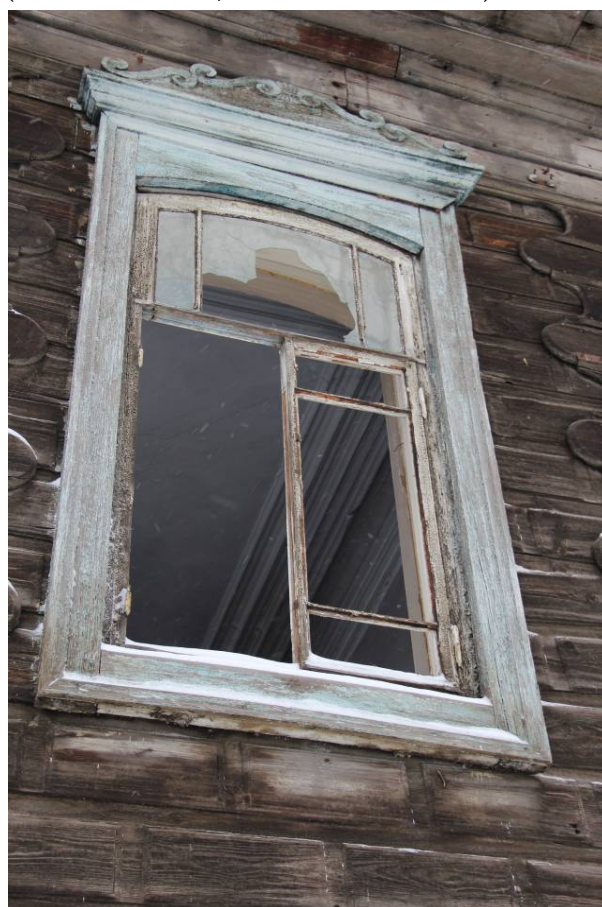
Видовая точка № 19. Наличник окна второго этажа, профильные штукатурные тяги в отделке помещения (Яблонская М.А., 21.11.2014 г.)
