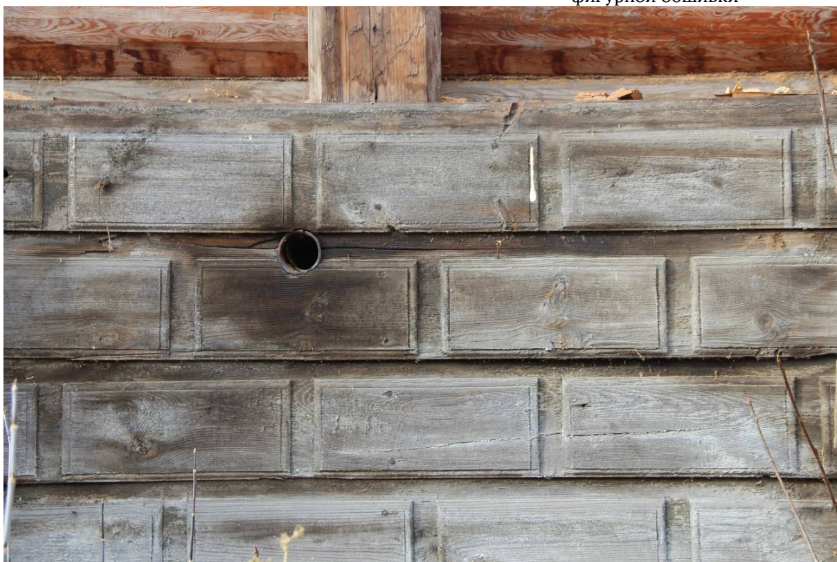
Видовая точка № 9. Рустованная обшивка бревенчатых стен сруба
