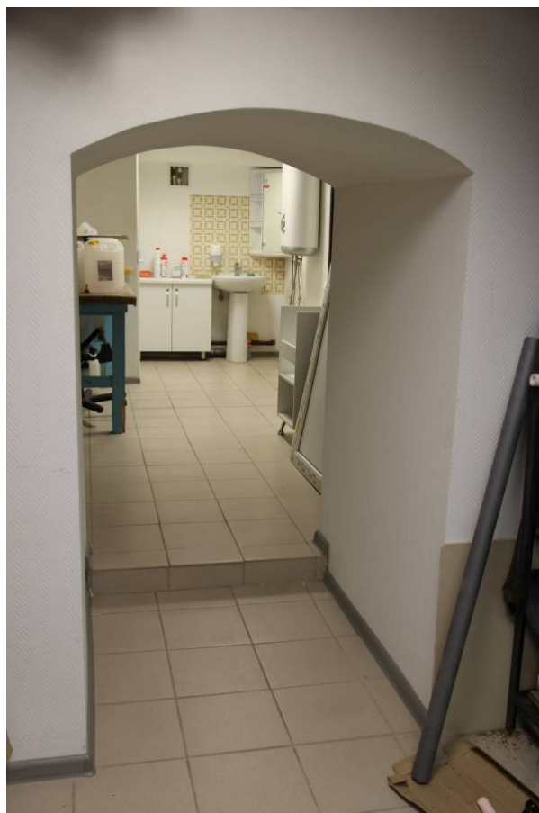
Видовая точка № 29. Лучковый дверной проем в помещении подвала основного объема (10.12.2021 г.)
