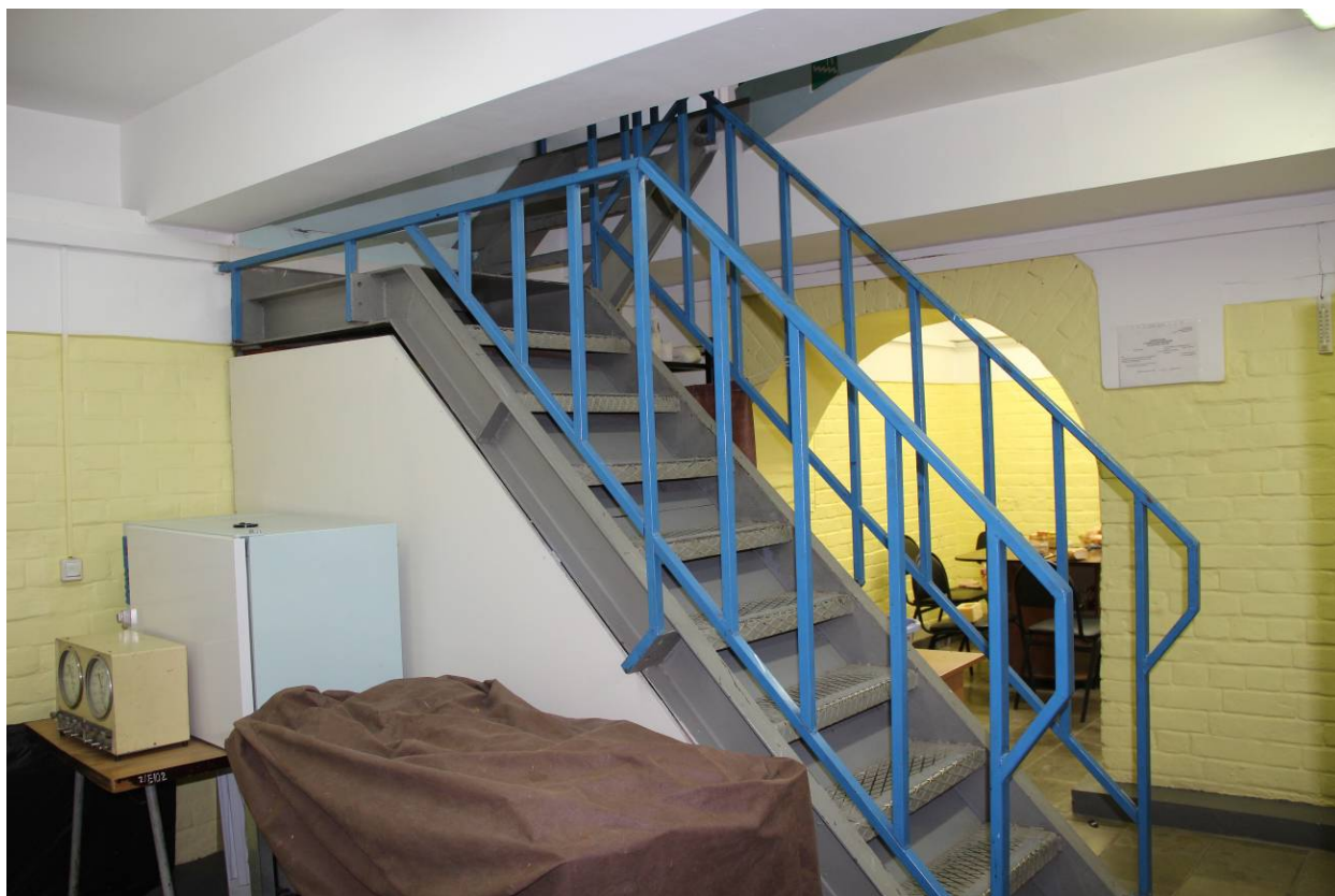
Видовая точка № 31. Общий вид помещения подвала дворового флигеля (Яблонская М.А., 10.12.2021 г.)
