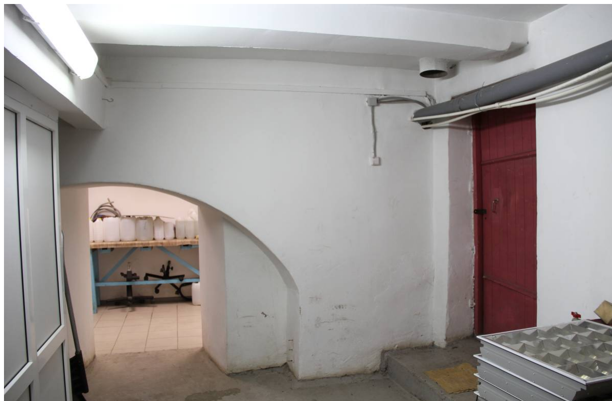
Видовая точка № 30. Общий вид помещения подвала основного объема: лучковый проем, дверной проем выхода во двор (Яблонская М.А., 10.12.2021 г.)
