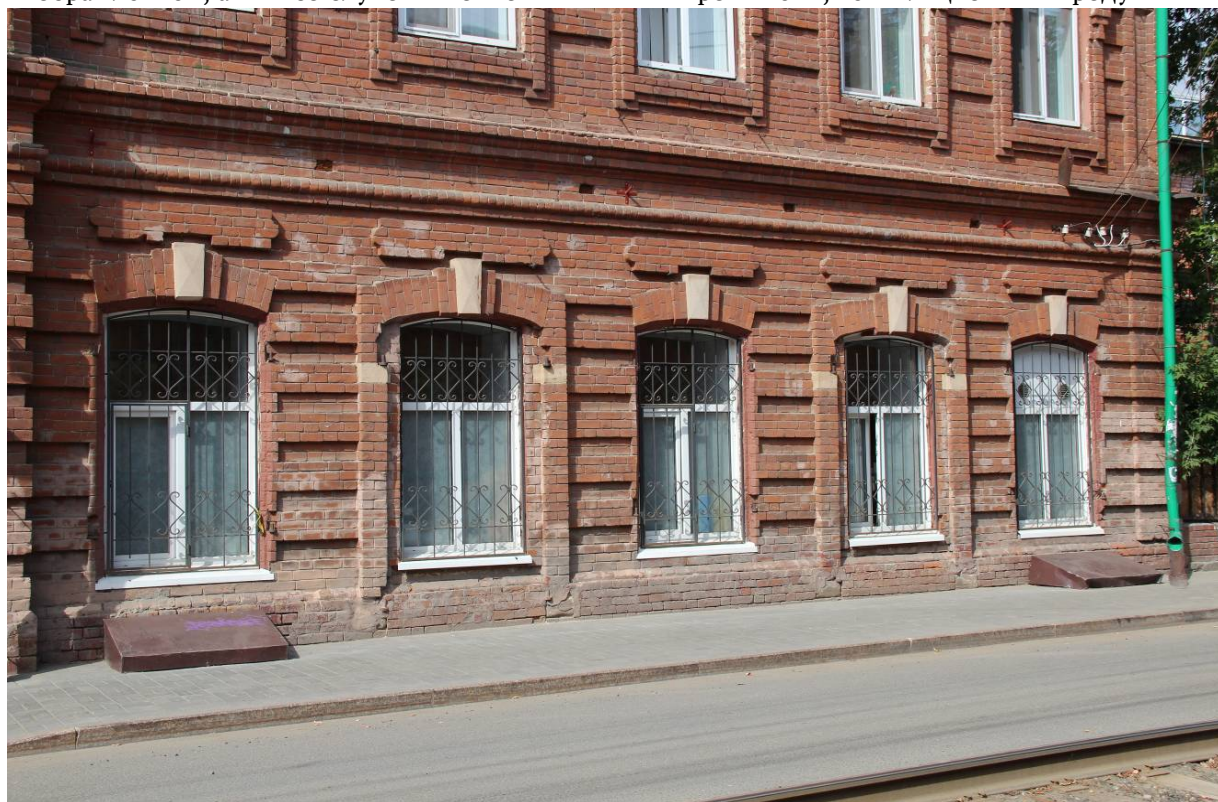
Видовая точка № 5. Фрагмент главного восточного фасада (1 этаж): руст, междуэтажный пояс, цоколь, оконные и дверные проемы (заложены до размеров окон)
