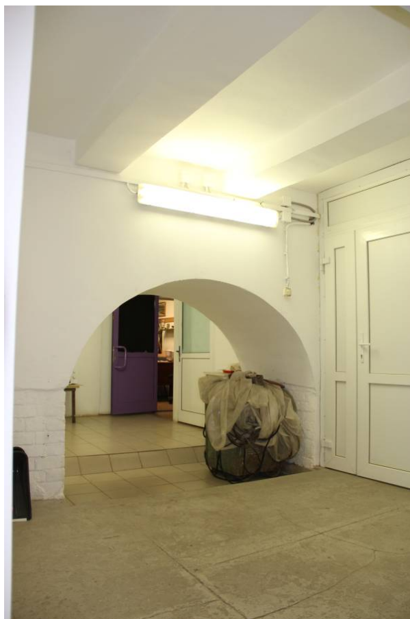
Видовая точка № 28. Арочный проем в помещении подвала основного объема (10.12.2021 г.)
