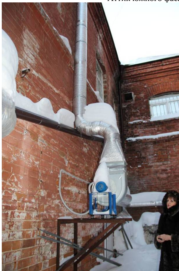
Видовая точка № 17. Восточный фасад дворового флигеля (Яблонская М.А., дата съемки: 29.01.2015)
