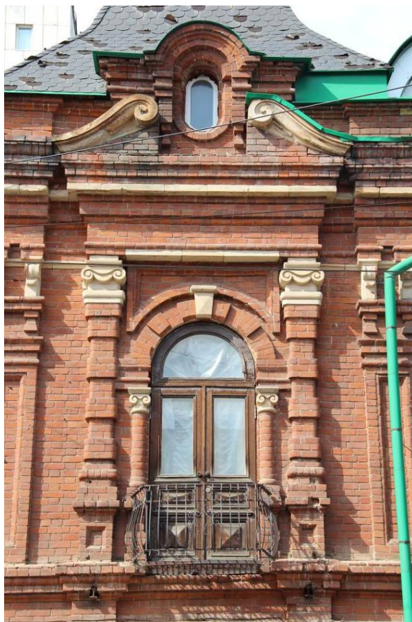
Видовая точка № 3. Фрагмент ризалита главного фасада, балконная дверь с декоративным обрамлением, аттик со слуховым окном
