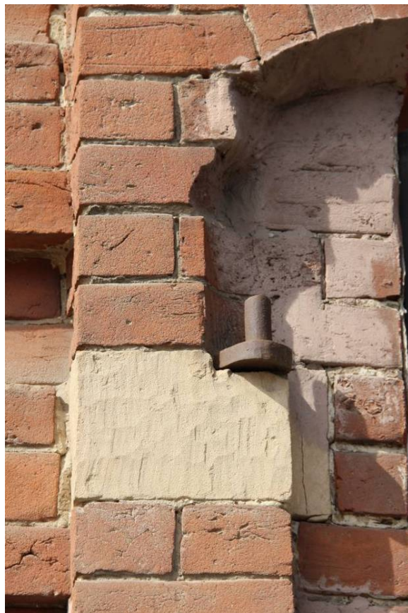
Видовая точка № 7. Кованый подстав на блоке из песчаника для навески ставней на дверном проеме
