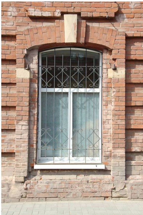
Видовая точка № 6. Исторический дверной проем главного восточного фасада с подставами для ставней
