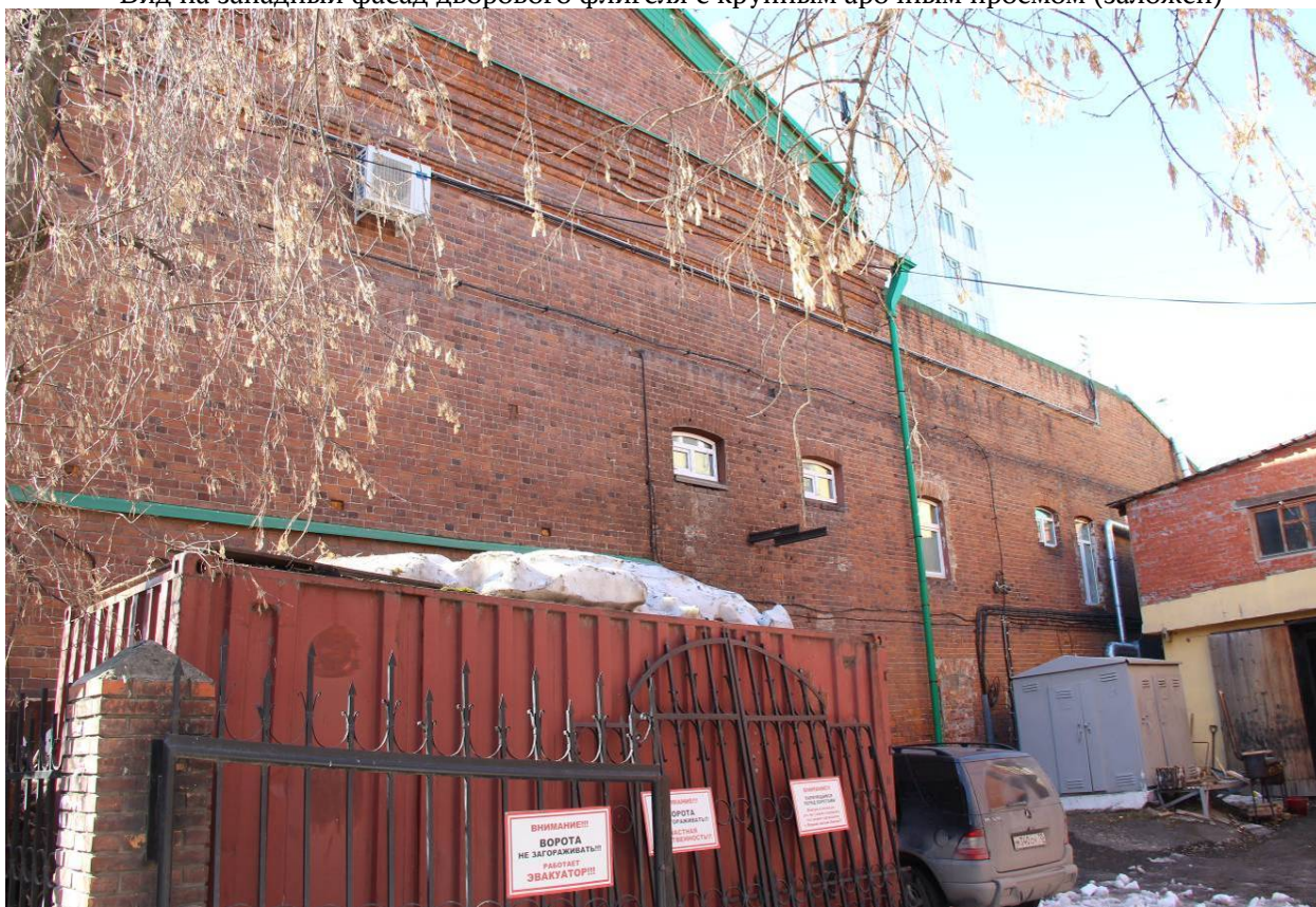
Видовая точка № 20. Северный фасад здания
