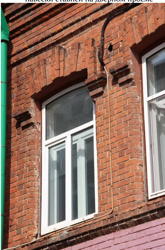
Видовая точка № 9. Декоративное оформление перемычки окна 2-го этажа бокового южного фасада
