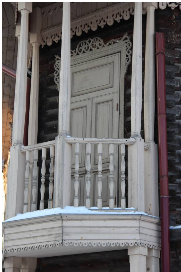
Видовая точка № 6. Балконная дверь углового фасада с резным декором обрамления (24.12.2021)
