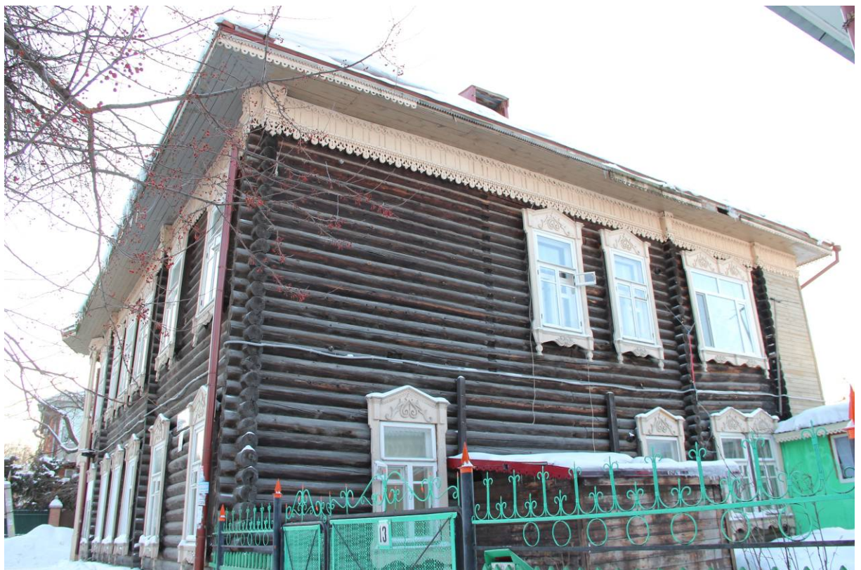
Видовая точка № 4. Боковой северный фасад здания (24.12.2021)
