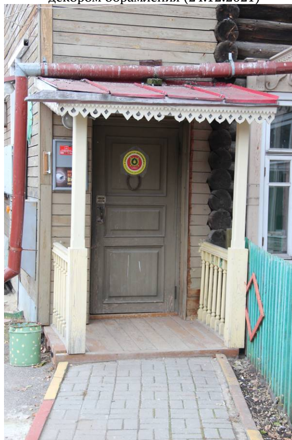
Видовая точка № 8. Дворовый вход южного фасада (Рыжикова А.Ю. 18.10.2017)
