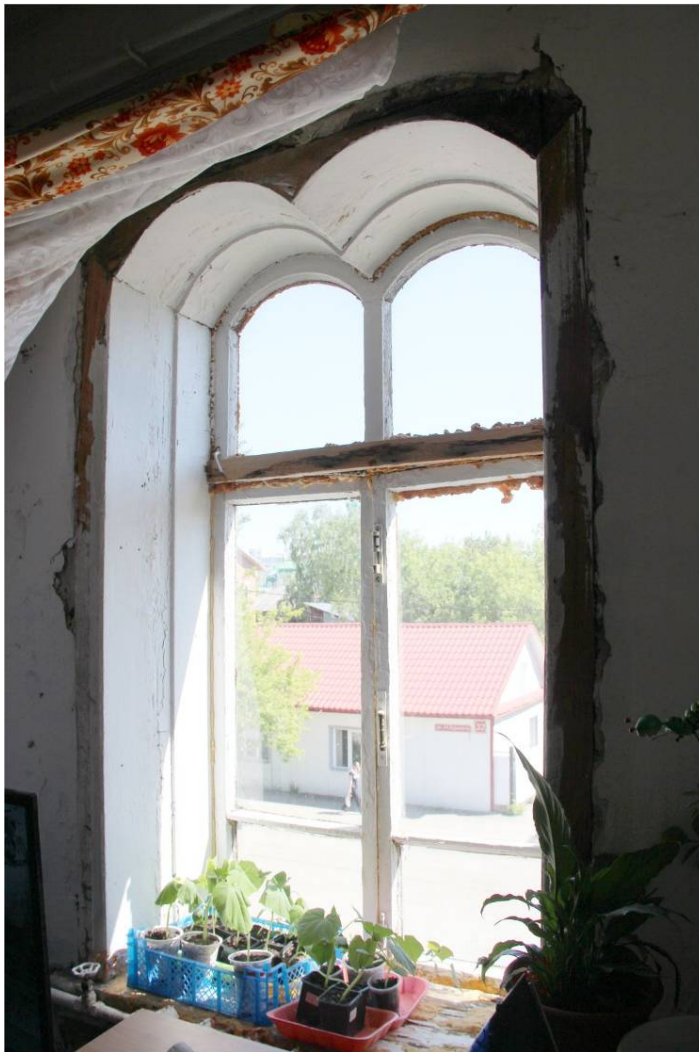
Видовая точка № 18. Деревянная коробка оконного проема второго этажа (Яблонская М.А., 25.05.2022)
