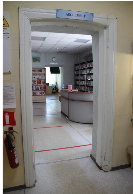
Видовая точка № 15. Лучковый дверной проем с деревянной коробкой в помещении первого этажа (Яблонская М.А., 25.05.2022 г.)
