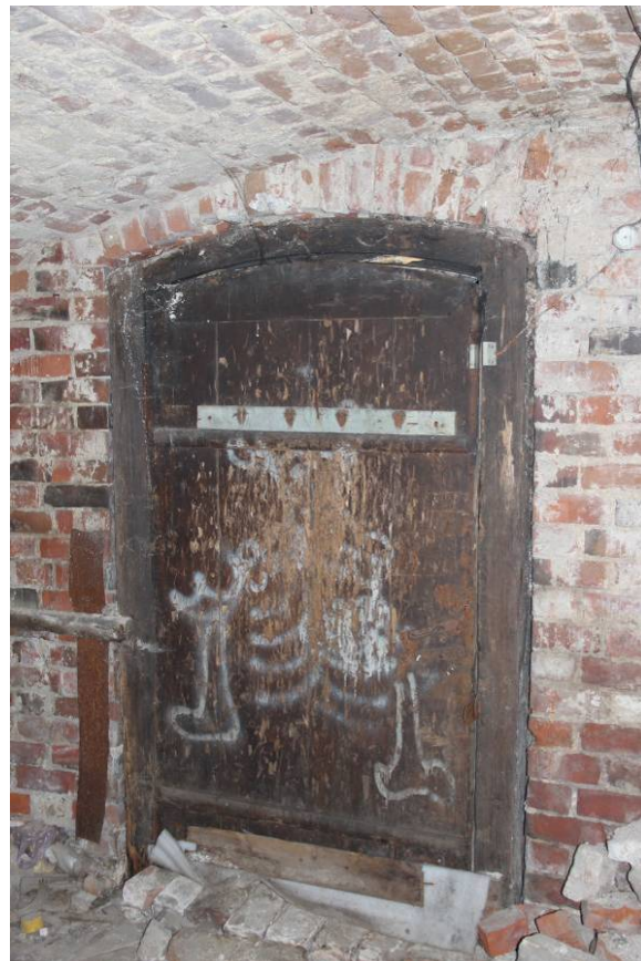
Видовая точка № 23. Дверной блок входа в подвал (Яблонская М.А., 2021 г.)
