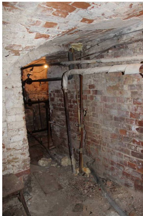
Видовая точка № 25. Перестроенный дверной проем подвала (Яблонская М.А., 2021 г.)
