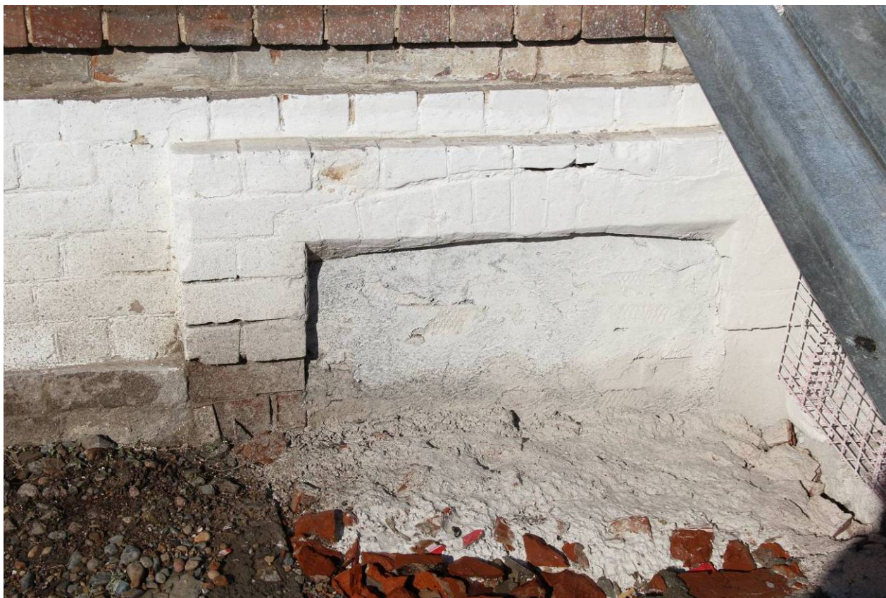
Видовая точка № 15. Оконный проем подвала с приямком главного фасада (Яблонская М.А., 2022 г.)
