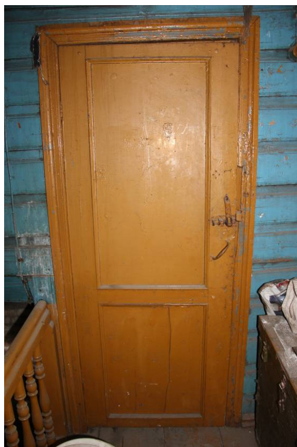
Видовая точка № 21. Деревянная дверь входа в кладовую второго этажа пристройки (Яблонская М.А., 2022 г.)
