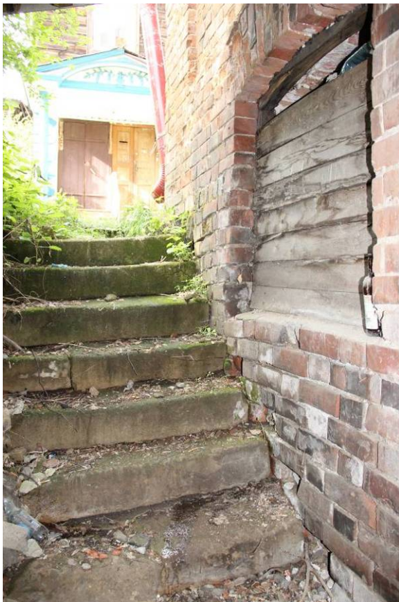
Видовая точка № 22. Спуск в подвал со ступенями из песчаника (Яблонская М.А., 2022 г.)
