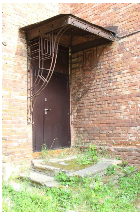
Видовая точка № 10. Кованый козырек и крыльцо из песчаника дворового входа западного фасада (Яблонская М.А., 2022 г.)
