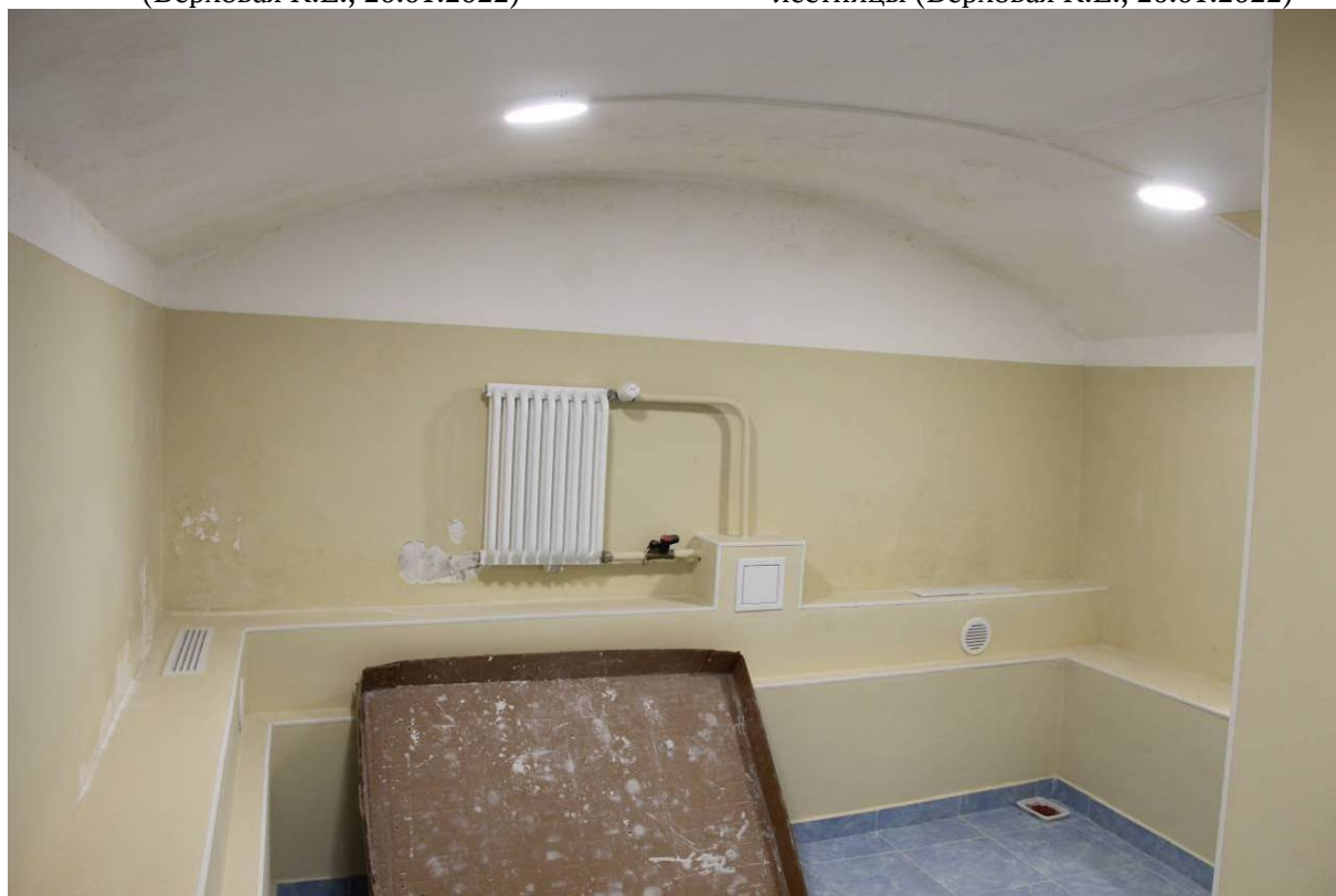
Видовая точка № 22. Помещение подвала с кирпичным сводом (Верховая К.Е., 20.01.2022)
