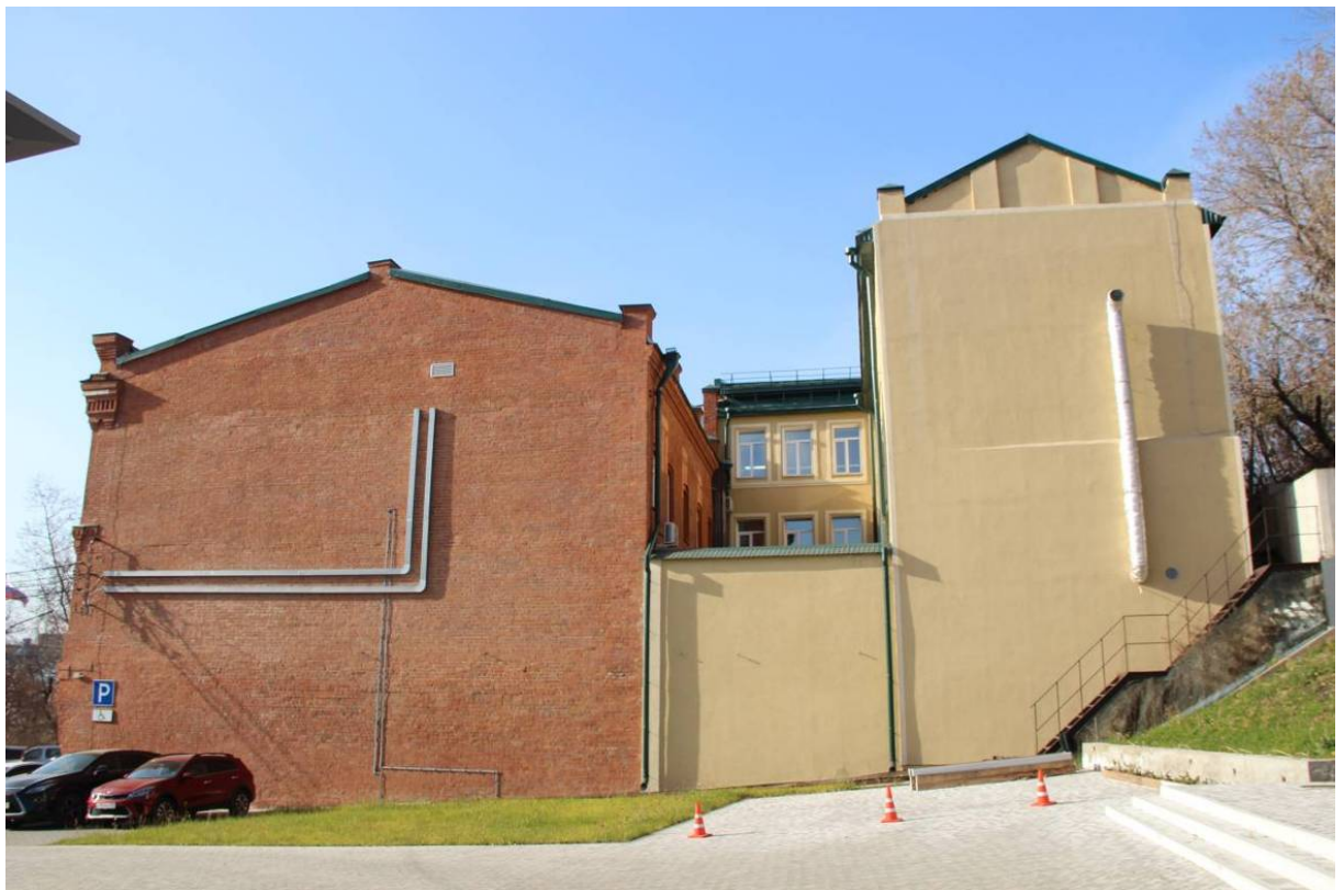
Видовая точка № 13. Фрагмент северного дворового фасада (Яблонская М.А., 27.09.2022)
