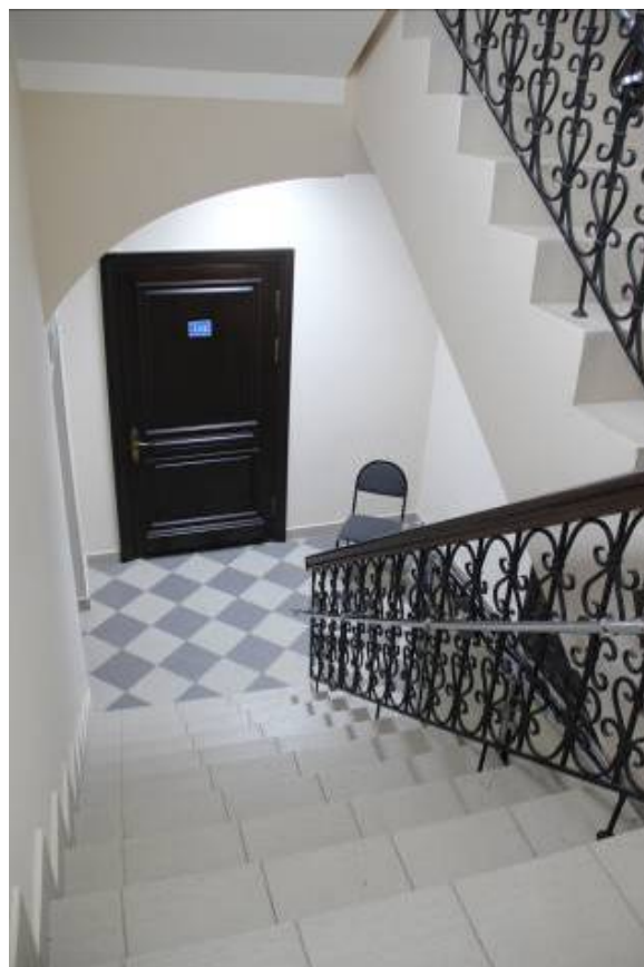
Видовая точка № 15. Лестница северо-западной части здания (Верховая К.Е., 20.01.2022)
