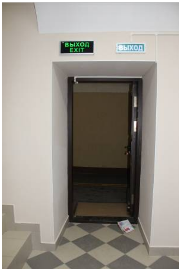
Видовая точка № 14. Лестница восточной части здания (Верховая К.Е., 20.01.2022)
