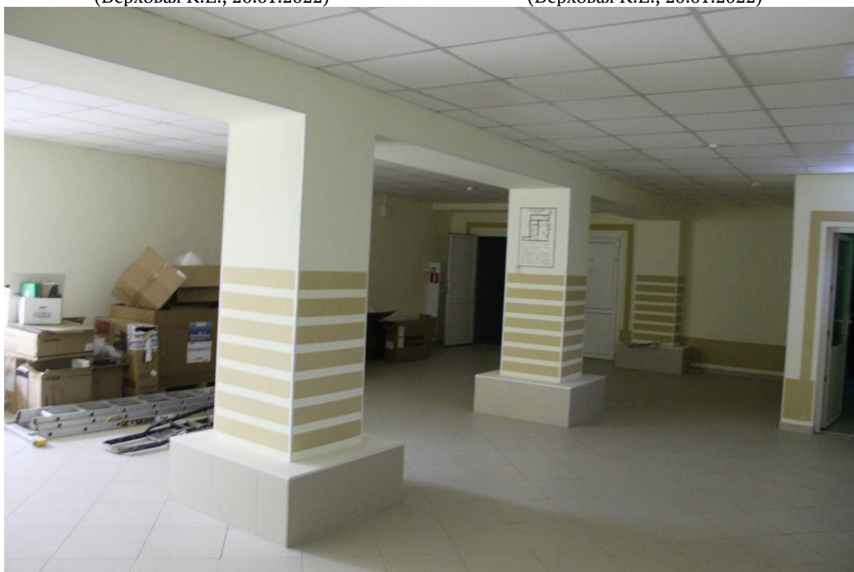
Видовая точка № 25. Помещение подвала с колоннами (Верховая К.Е., 20.01.2022)
