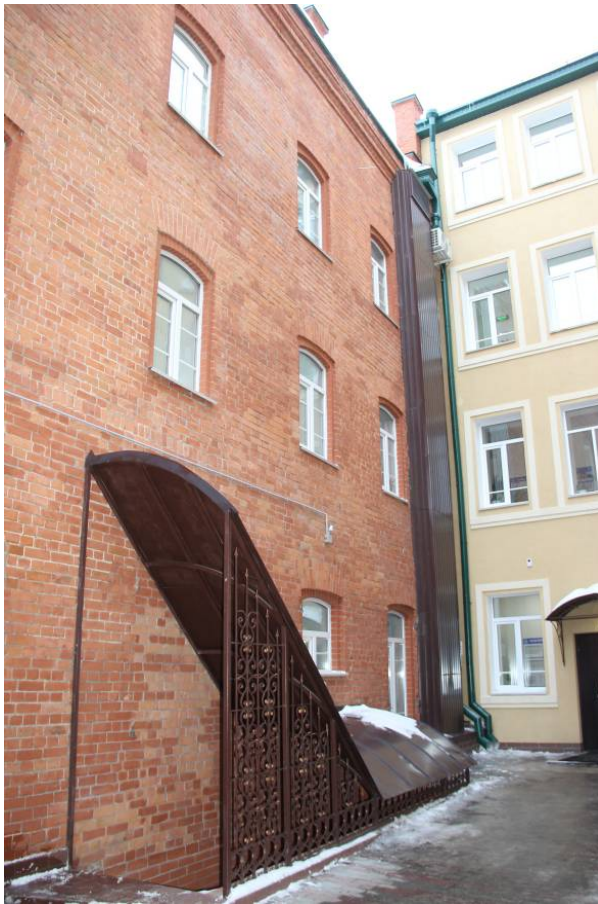
Видовая точка № 11. Фрагмент северного дворового фасада (Яблонская М.А., 20.01.2022)
