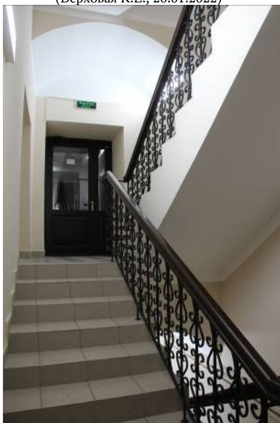
Видовая точка № 16. Лестница восточной части здания (Верховая К.Е., 20.01.2022)
