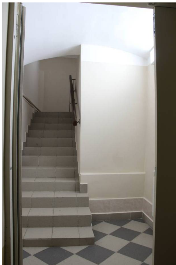
Видовая точка № 23. Спуск в подвал с кирпичным сводом под лестничной площадкой (Верховая К.Е., 20.01.2022)
