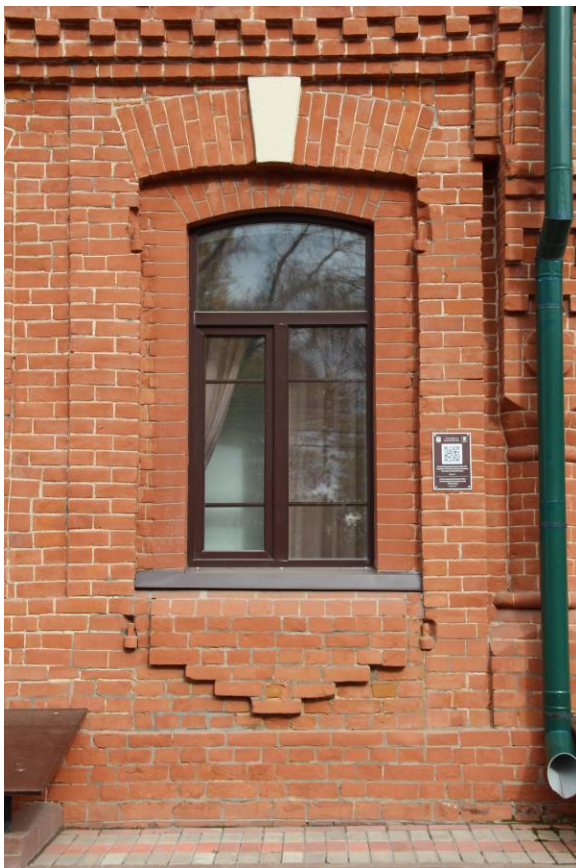
Видовая точка № 7. Местоположение исторического дверного проема южного фасада (Яблонская М.А., 27.09.2022)
