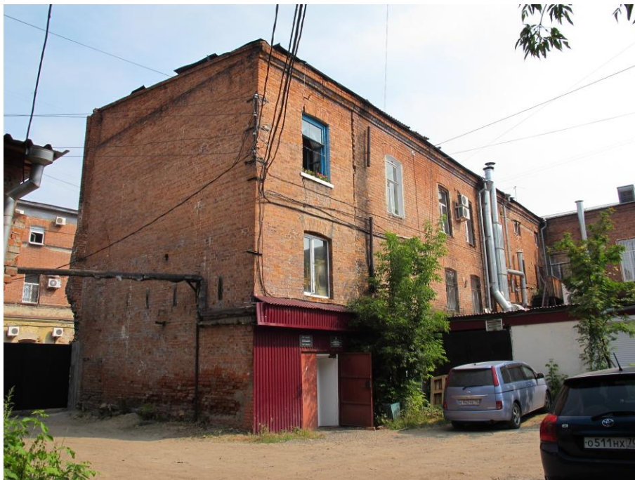
Фото № 11. Вид на дворовой фасад
