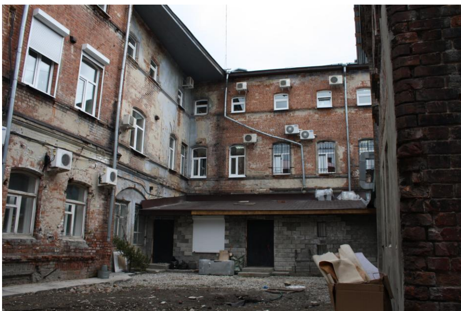
Фото № 10. Вид на дворовой фасад
