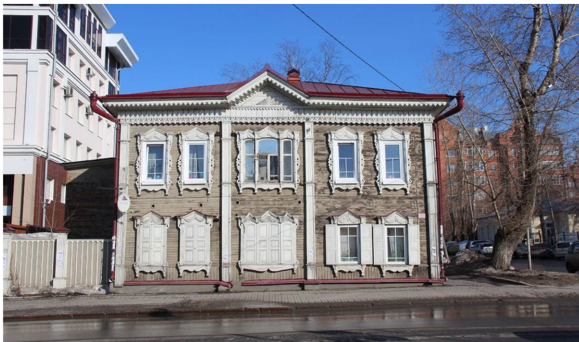
Видовая точка № 2. Западный фасад здания, вид с ул. Красноармейской (Яблонская, 2022)
