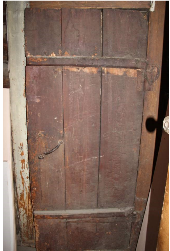
Видовая точка № 11. Дощатая на шпонках дверь выхода в пристройку в уровне 2-го этажа (Яблонская М.А., 29.07.2024)
