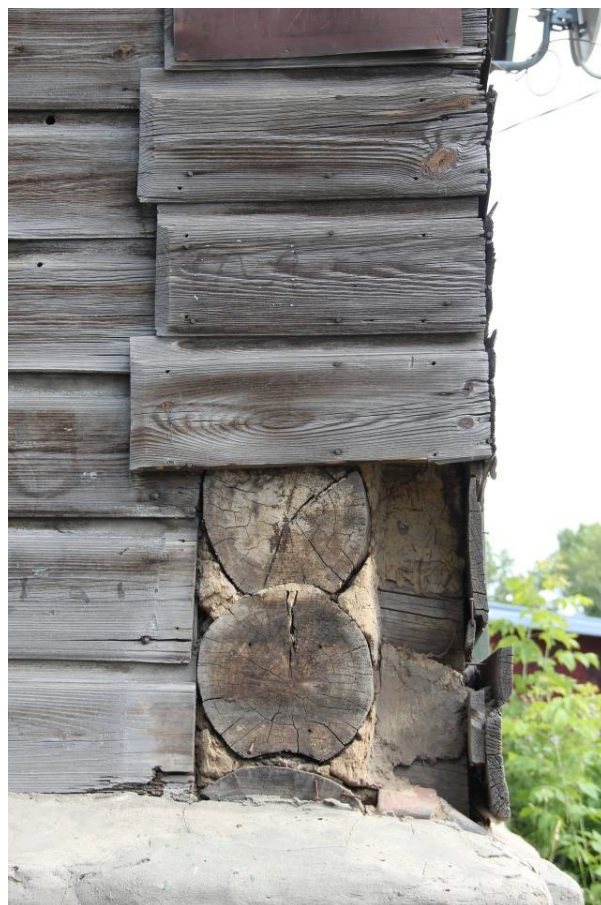
Видовая точка № 6. Фрагмент обшивки фасада (Яблонская М.А., 02.08.2024)
