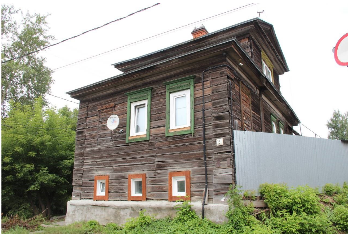
Видовая точка № 3. Южный фасад здания (Яблонская М.А., 02.08.2024)
