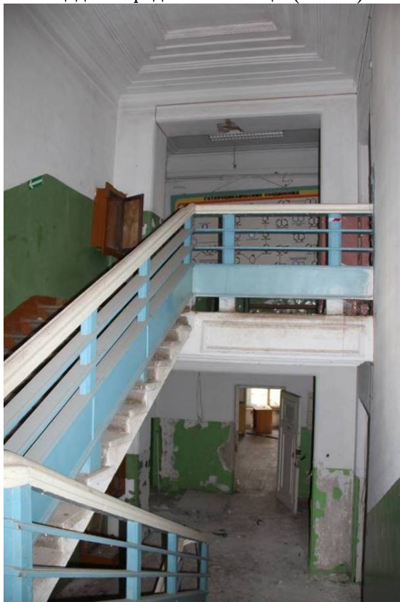
Видовая точка № 22 Интерьер парадной лестницы (3 этаж)
