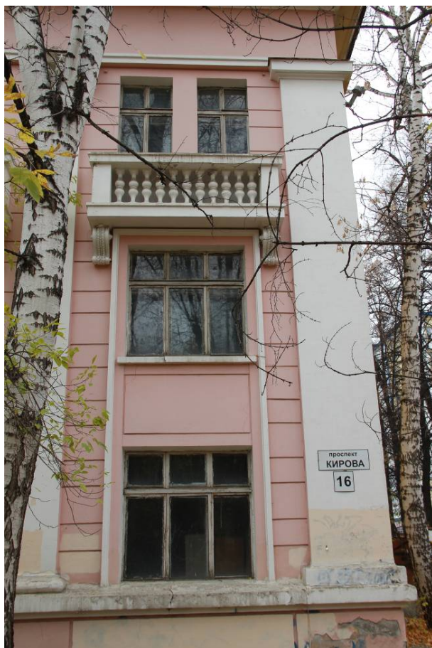
Видовая точка № 7 Фрагмент южного фасада
