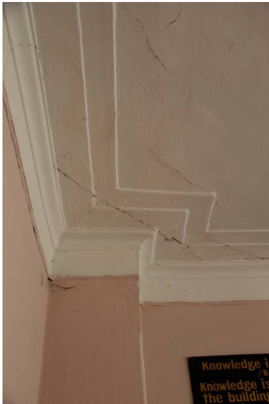
Видовая точка № 28 Фрагмент штукатурного карниза помещения
