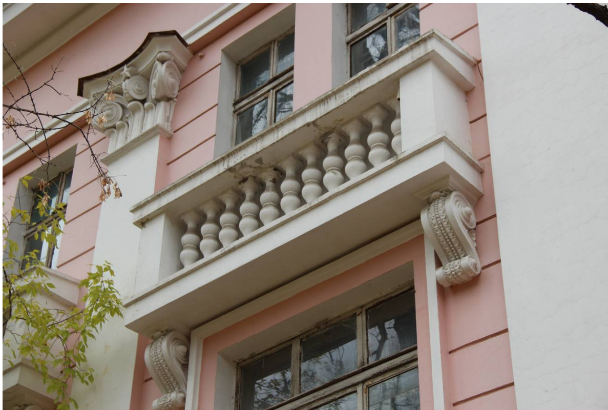
Видовая точка № 6 Фрагмент южного фасада (3-й этаж)
