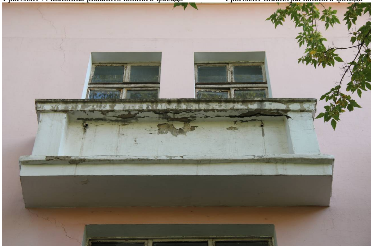
Видовая точка № 11 Балкон 3-го этажа западного фасада
