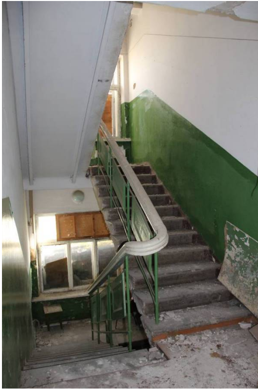
Видовая точка № 24 Лестница западного крыла здания (2 этаж)
