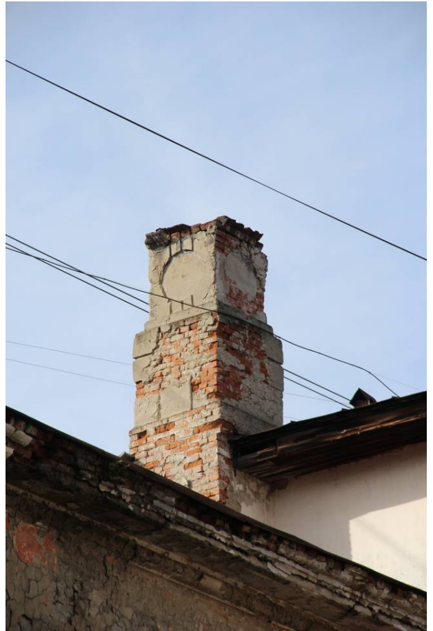
Видовая точка № 13 Дымовая труба со штукатурным декором
