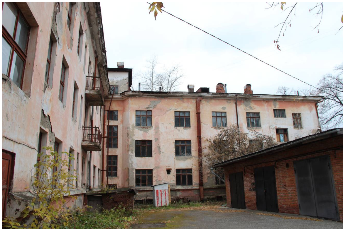
Видовая точка № 15 Дворовый восточный фасад здания
