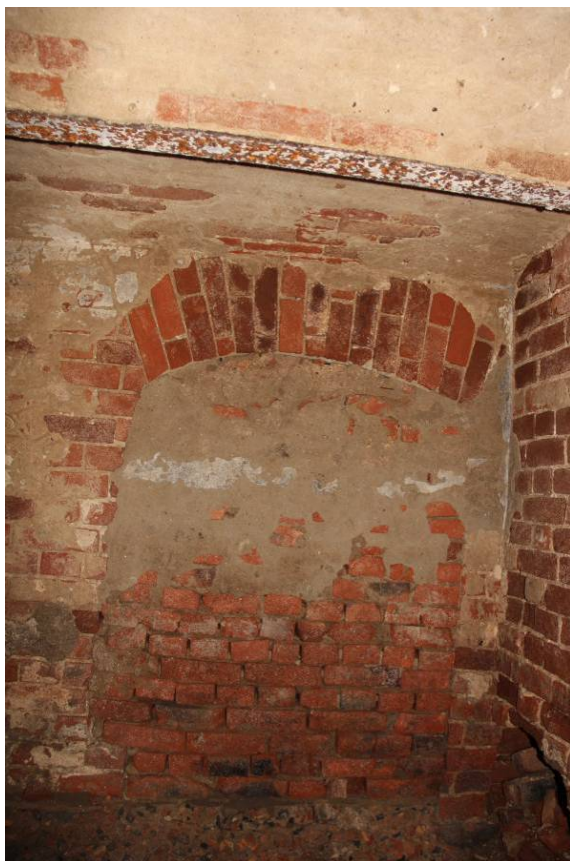
Видовая точка № 15 Заложенный исторический оконный проем в помещении подвала
