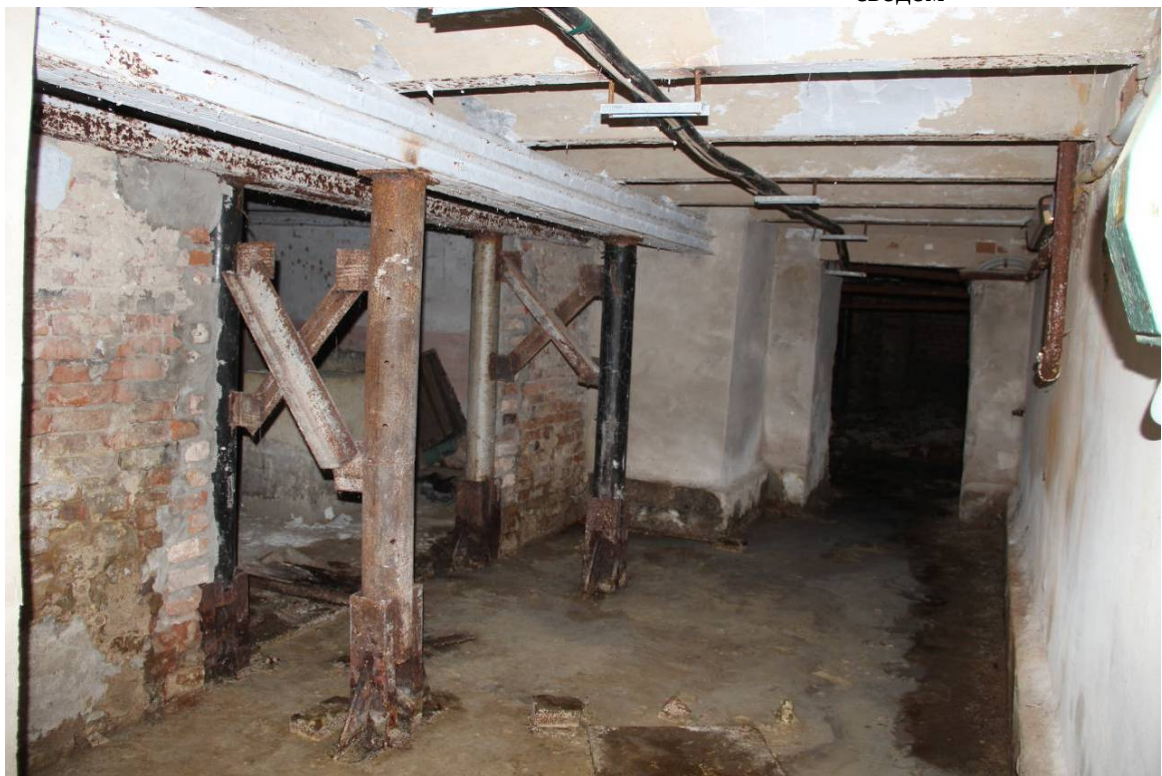
Видовая точка № 19 Металлические балки (рельсы) над большими проемами помещений подвала
