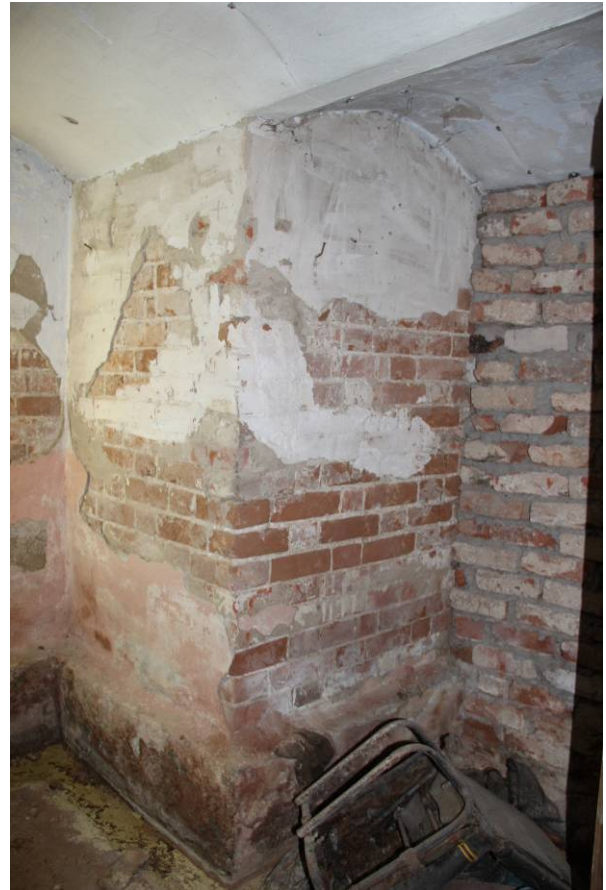
Видовая точка № 18 Фрагмент большого проема во внутренней стене помещения подвала, перекрытого кирпичным сводом
