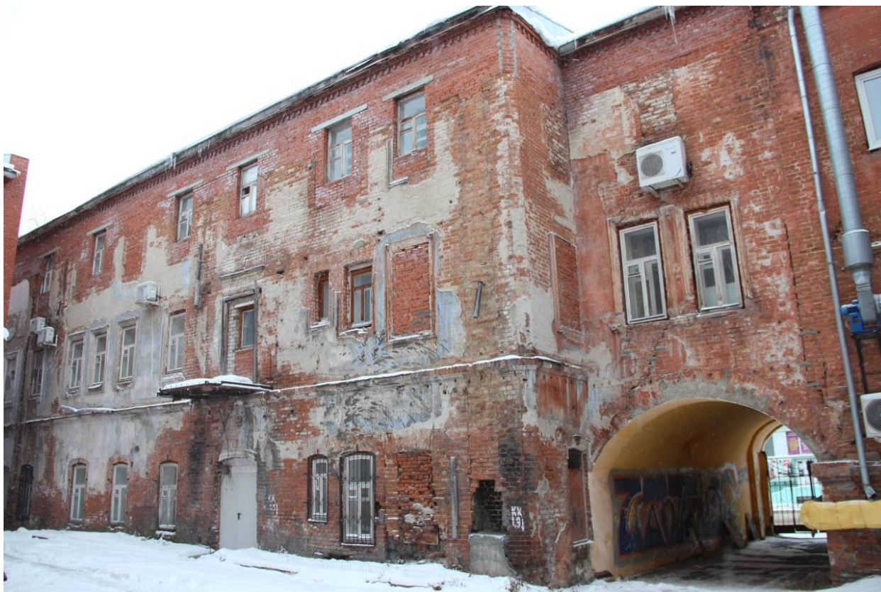
Видовая точка № 6 Дворовый восточный фасад здания
