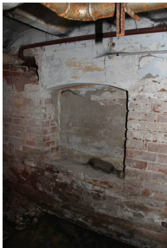
Видовая точка № 16 Ниша с лучковой перемычкой во внутренней стене помещения подвала
