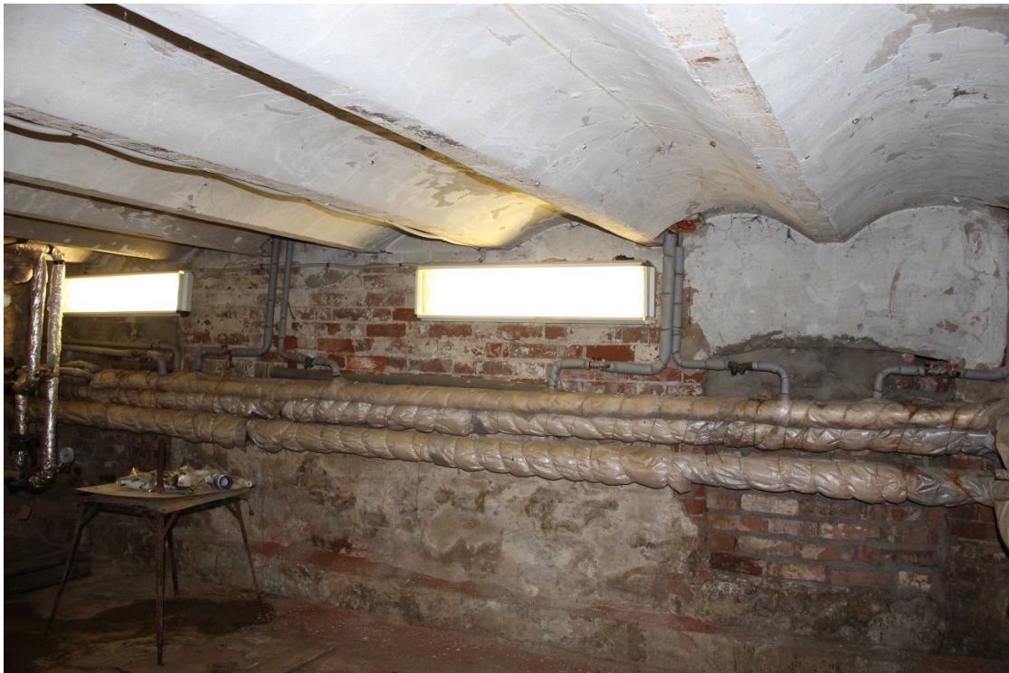
Видовая точка № 14 Кирпичные своды по металлическим балкам в помещении подвала
