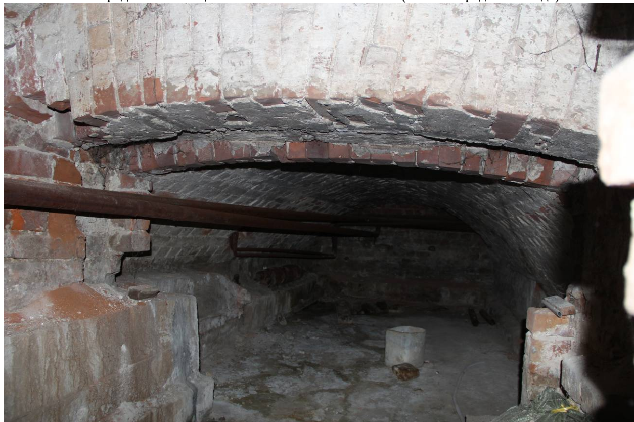
Видовая точка № 13 Кирпичный свод в помещении подвала (под парадной лестницей)
