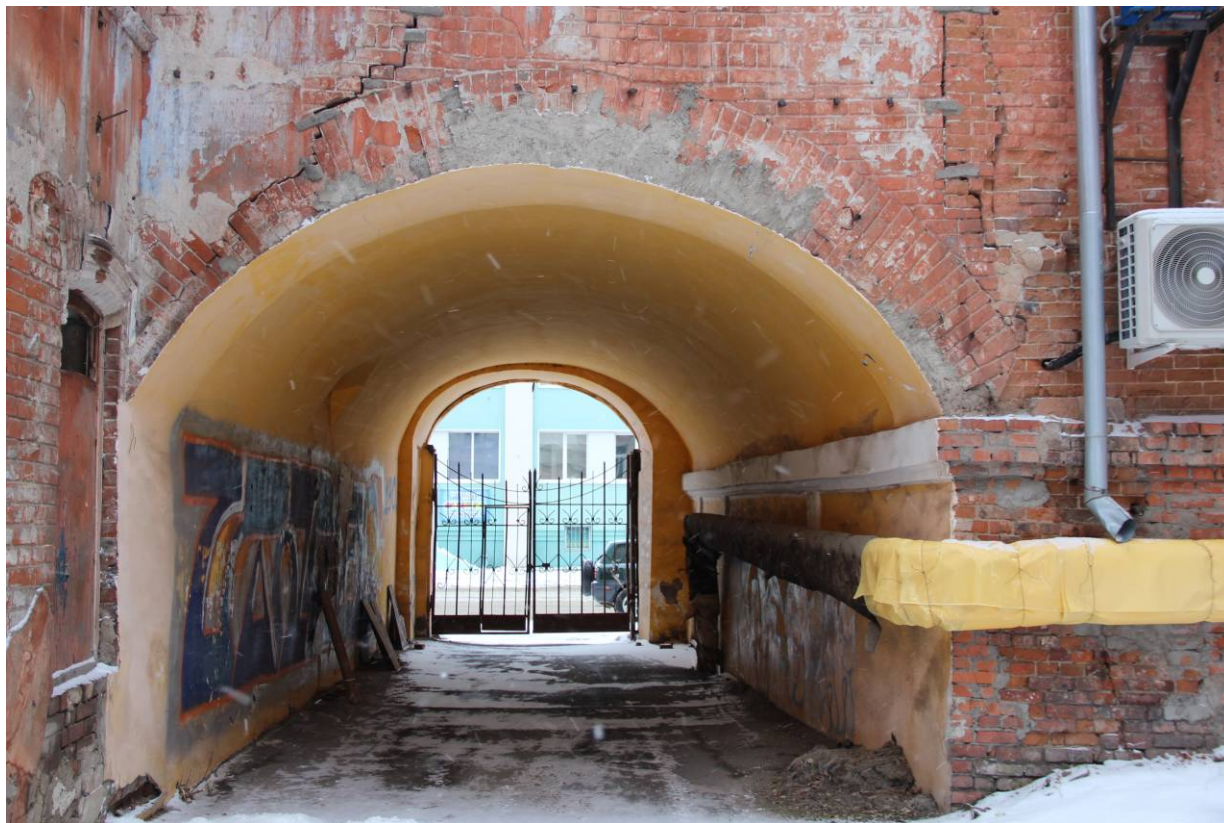
Видовая точка № 8 Сквозной проезд во двор, перекрытый кирпичным сводом
