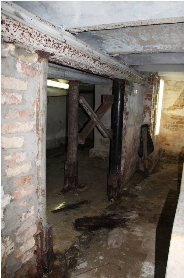
Видовая точка № 17 Металлические балки (рельсы) над большими проемами помещений подвала
