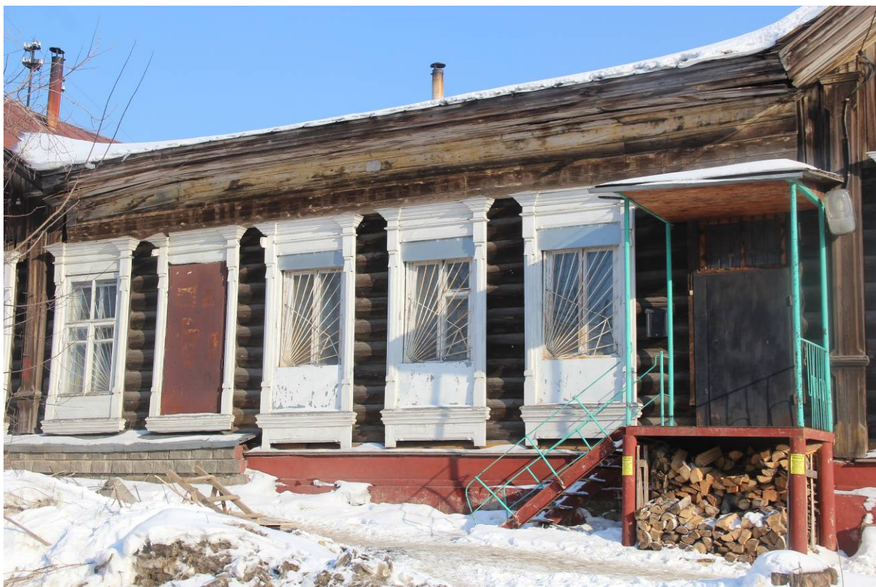
Видовая точка № 6 Фрагмент главного западного фасада
