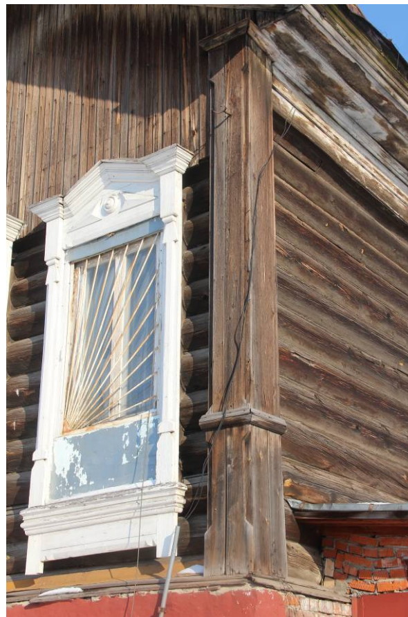
Видовая точка № 4 Угловая пилястра
