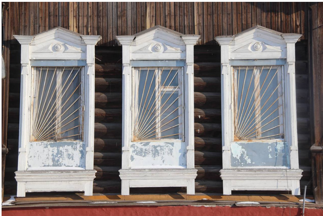
Видовая точка № 5 Наличники окон главного фасада
