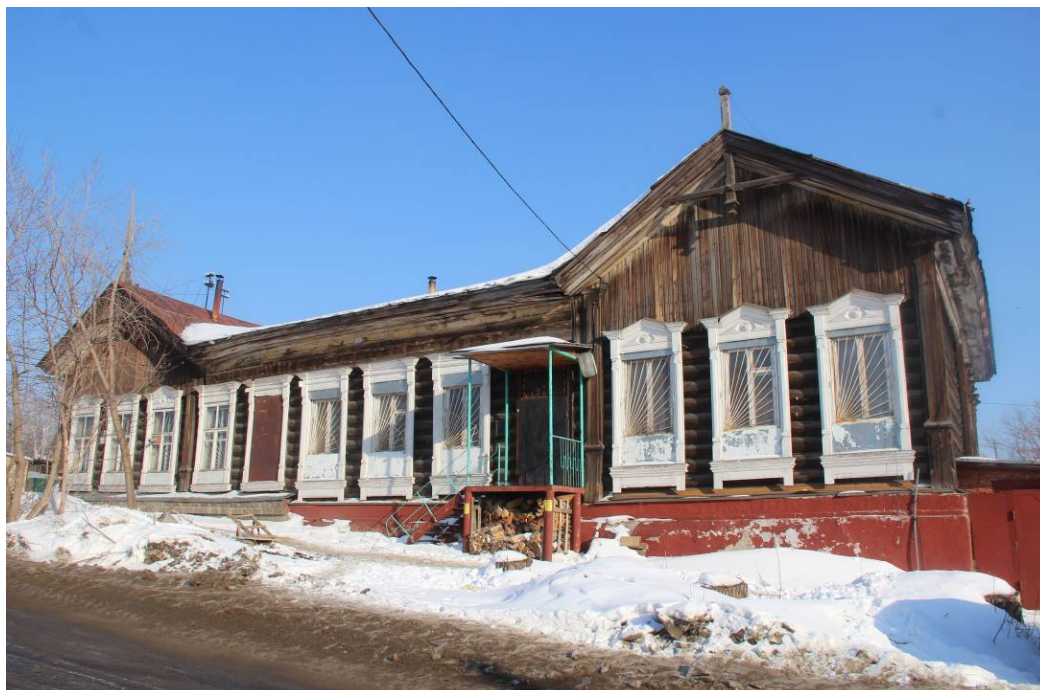
Видовая точка № 2 Главный западный фасад здания
